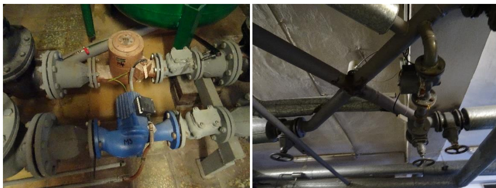
Obr. 4: Obehové čerpadlá, štvorcestný zmiešavací ventil
