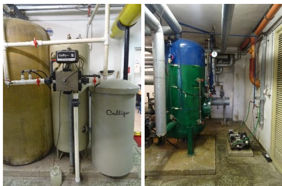
Obr. 5: Chemická úpravňa vody, expanzná nádoba
