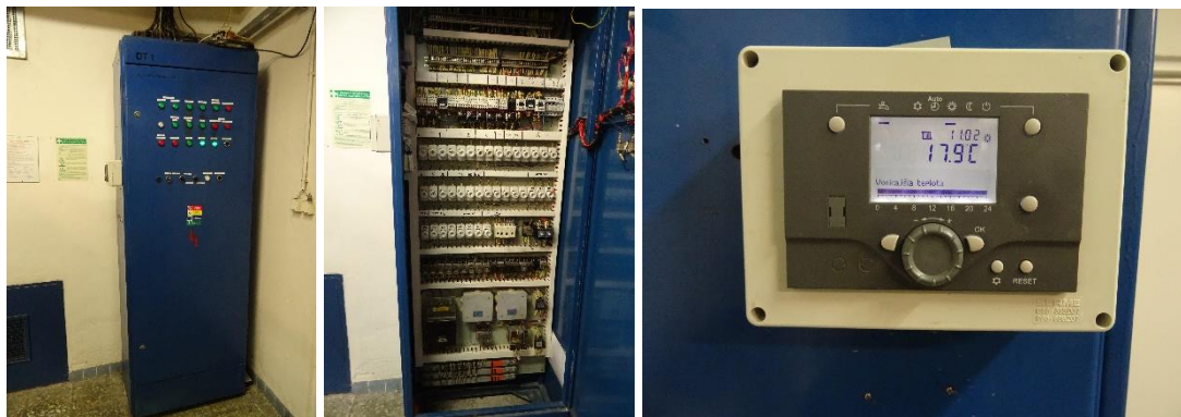
Obr. 6: Riadiaci systém kotolne a ekvitermická regulácia
