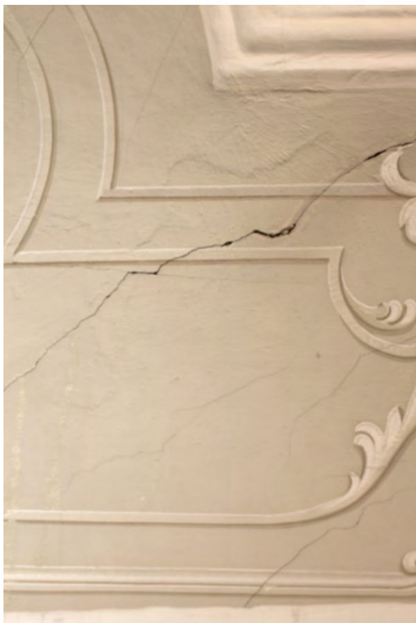
Statické trhliny nástropního obrazu, detaily v denním osvětlení.
