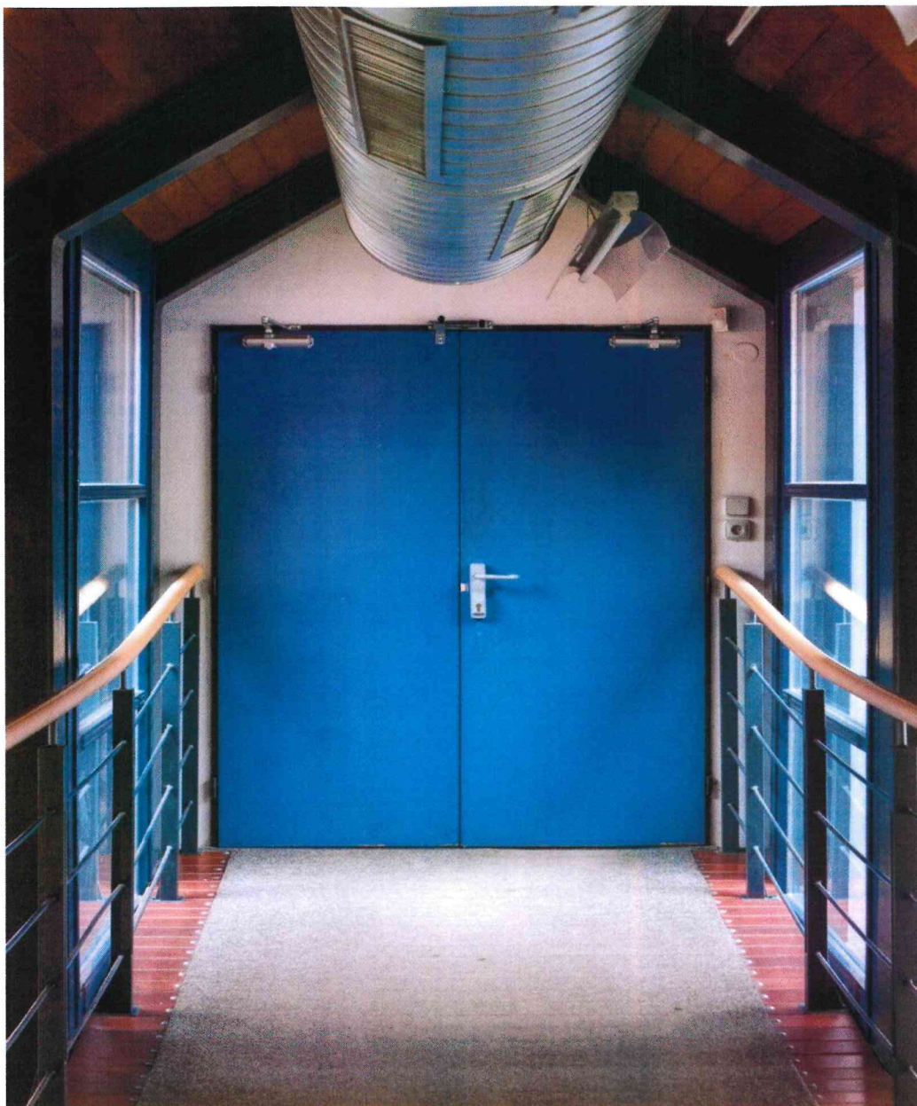
Obrázek 2 - Dveře na únikové cestě s panikovým zámkem a samozavírači a koordinátorem zavírání – bez transparentní plochy
