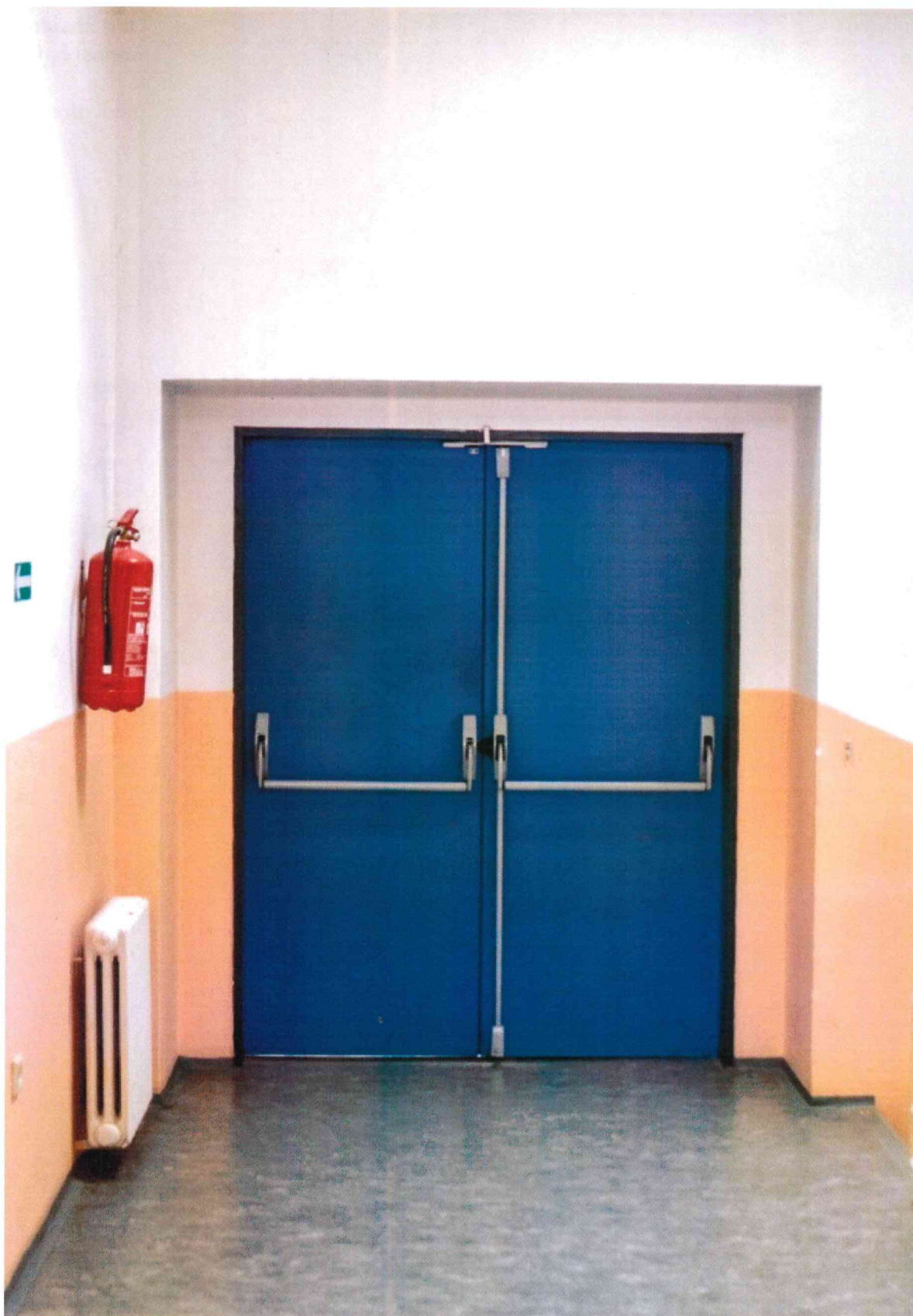
Obrázek 3 - Dveře na únikové cestě s panikovou hrazdou
