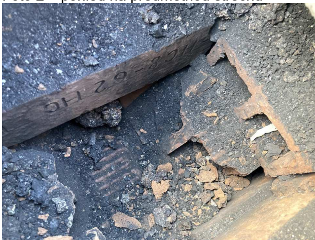
Foto 4 – podélně děrované cihly a škvárový násyp
