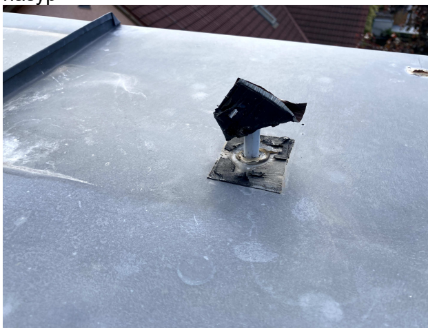
Foto 6 – záplaty na šrouby při kotvení oplechování koruny atiky
