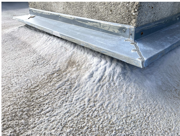
Foto 7 – provedení detailu napojení střechy u komínu
