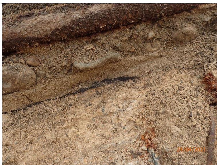
Pole 1, zřícený úsek P římsy, detail degradovaných vrstev na okraji NK.
