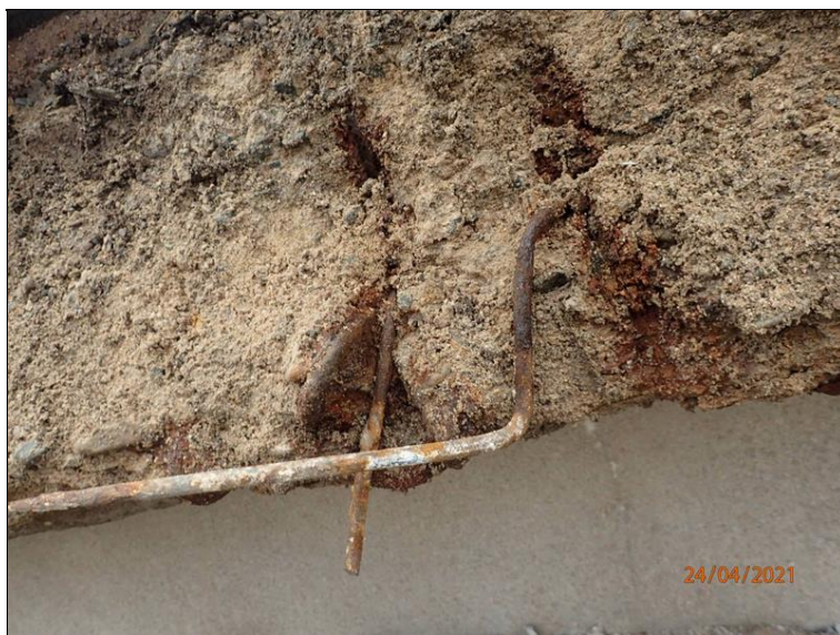
Pole 1, zřícený úsek P římsy, detail z přesahu vytržené kotevní výztuže sloupku zábradlí.
