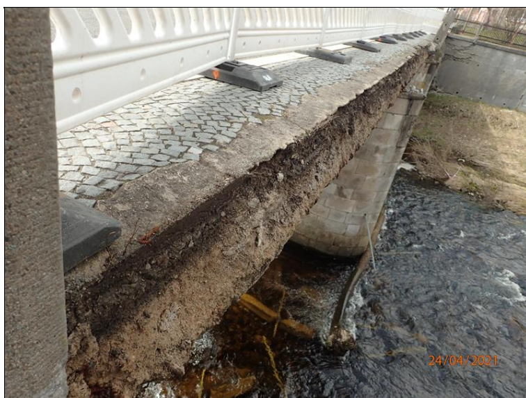
Pole 1, zřícený úsek P římsy, detail dělicí plochy.
