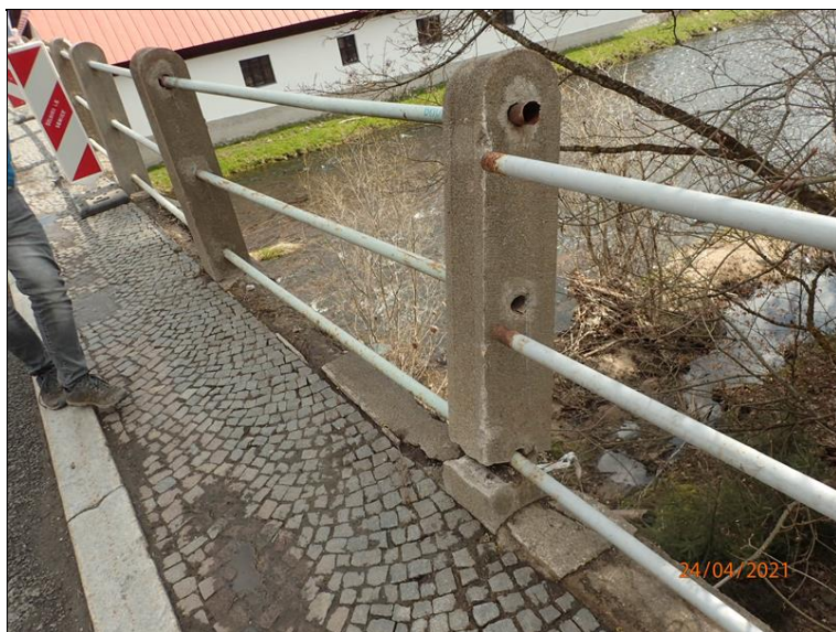
Pole 3, nárazem vozidla zlomený sloupek L zábradlí.
