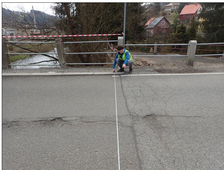
Kontrola šířky vozovky nad opěrou O4, zde naměřeno 603 cm.
