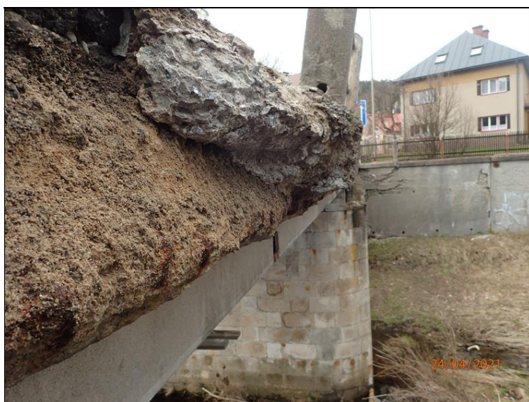
Pole 2, zřícený úsek P římsy, detail přechodu mezi havarovanou a zachovanou částí.
