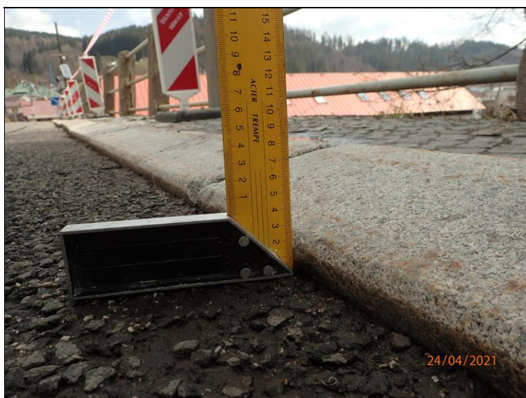
Kontrola výšky vozovkové obruby L chodníku v poli 3, zde naměřeno 2,5 cm.
