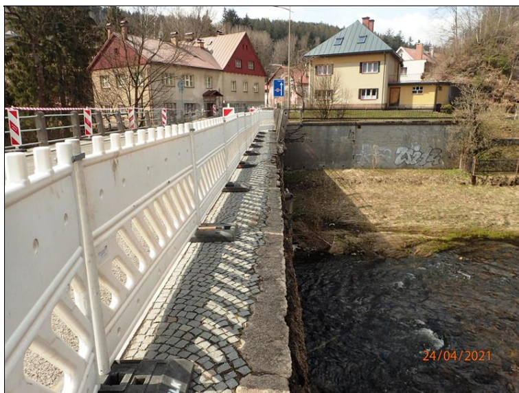
Pole 1, zřícený úsek P římsy + zábradlí, pohled z chodníku nad O1.
