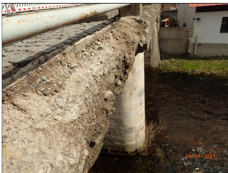
Pole 2, Horní povrch a bok L římsy, pohled směrem k pilíři P2.
