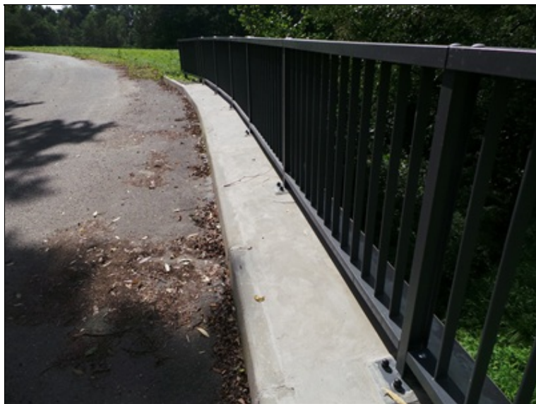
nečistoty na kraji vozovky, provedená sanace římsy
