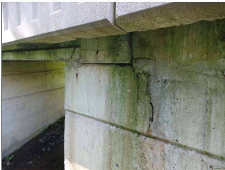
trhliny na křídle OP1 vlevo
