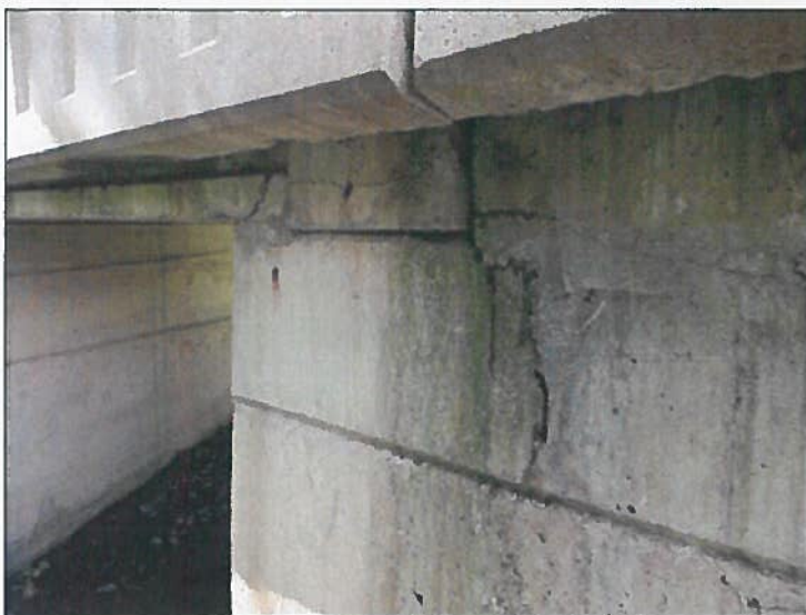
trhliny na křídle OP1 vlevo
