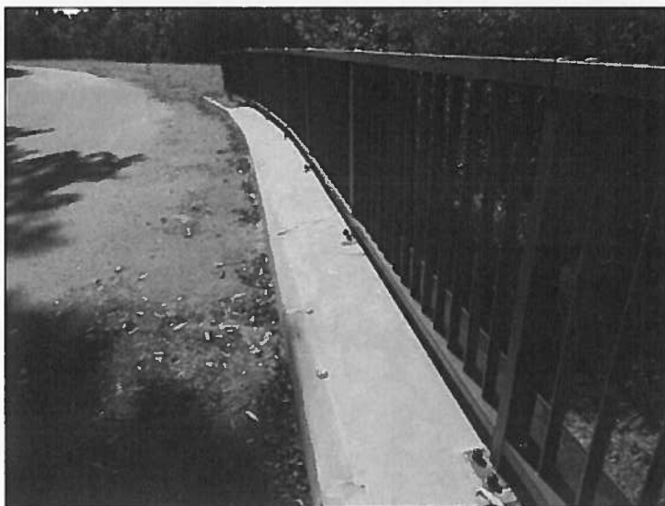
nečistoty na kraji vozovky, provedená sanace řimsy
