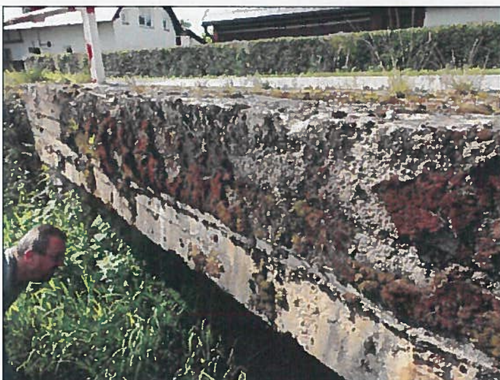
degradace betonu římsy
