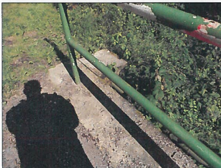
degradace betonu římsy, poškozená PKO
