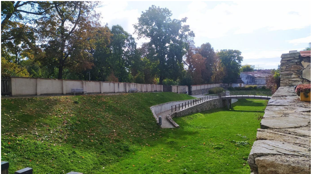
Pohled od parkánové hradby dvora Dolní Česká 13 do hradebního příkopu
