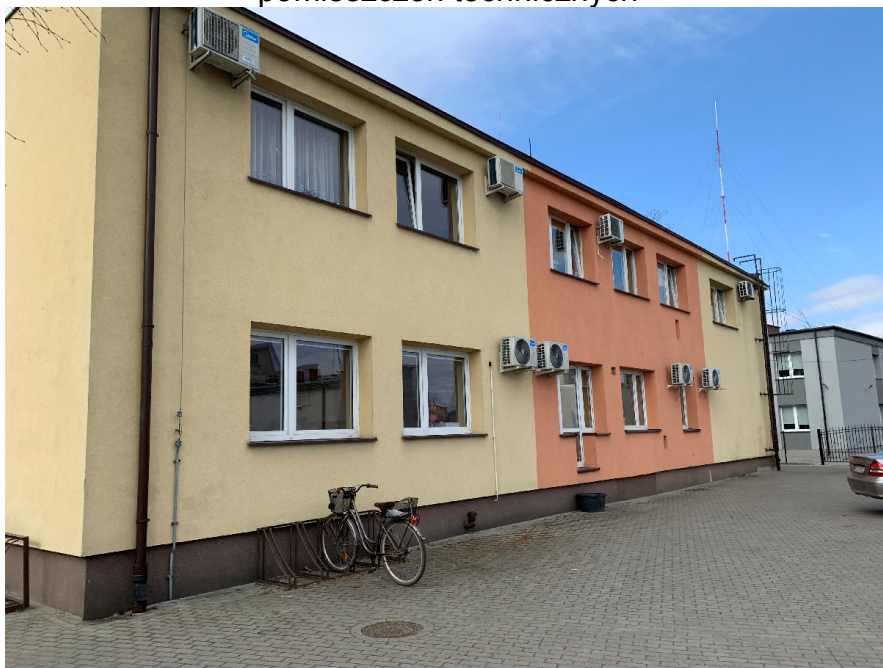
widok na elewację północną od strony parkingu istniejącego
