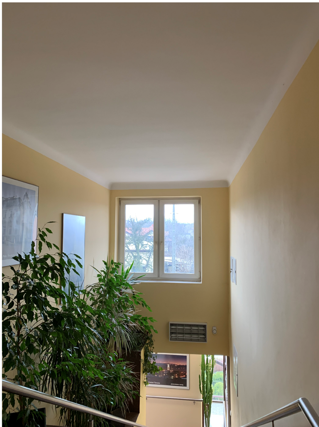
widok z korytarza 1 piętra na ścianę zewnętrzną od strony ulicy Zielonej (widoczna barierka schodów prowadzących z parteru na 1 piętro)
