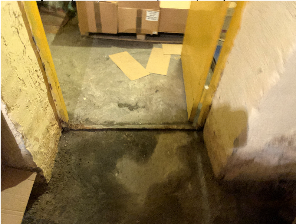
zejście do piwnicy
