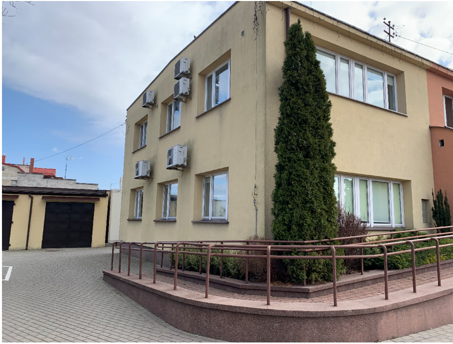
widok na narożnik południowo-zachodni .Widoczna rampa podjazdowa dla osób niepełnosprawnych
