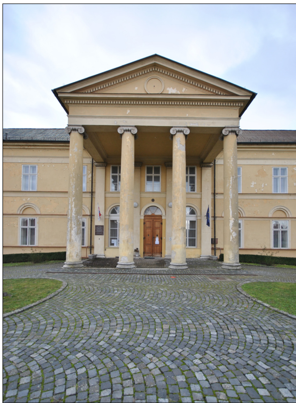
4. SV portikus s hlavným vstupom
