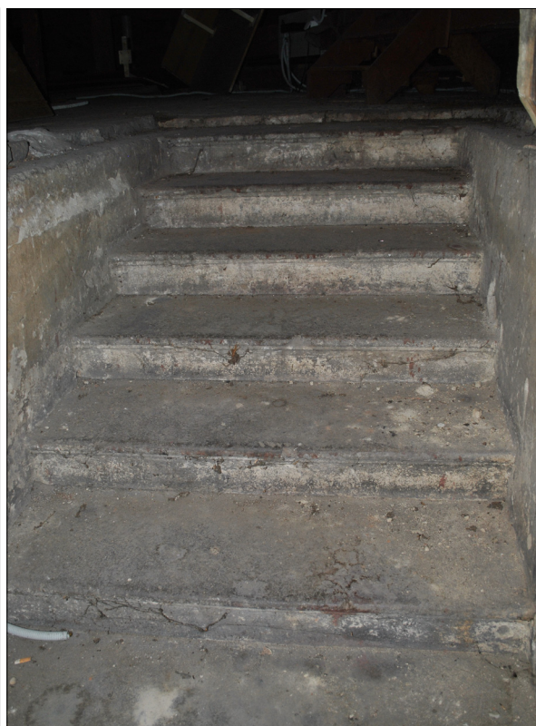
92. Schodisko do krovu
