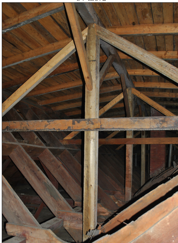
88. Krovová konštrukcia strednej mladšej časti
