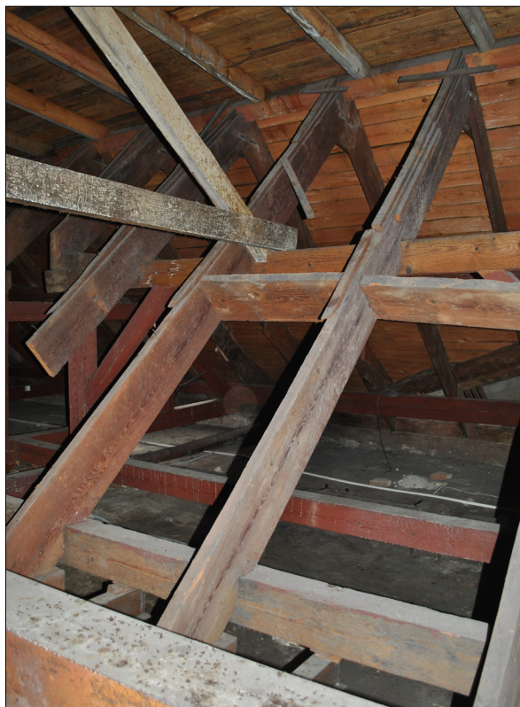
86. Krov – pohľad od úžľabia na krokvy pôvodného SV krovu
