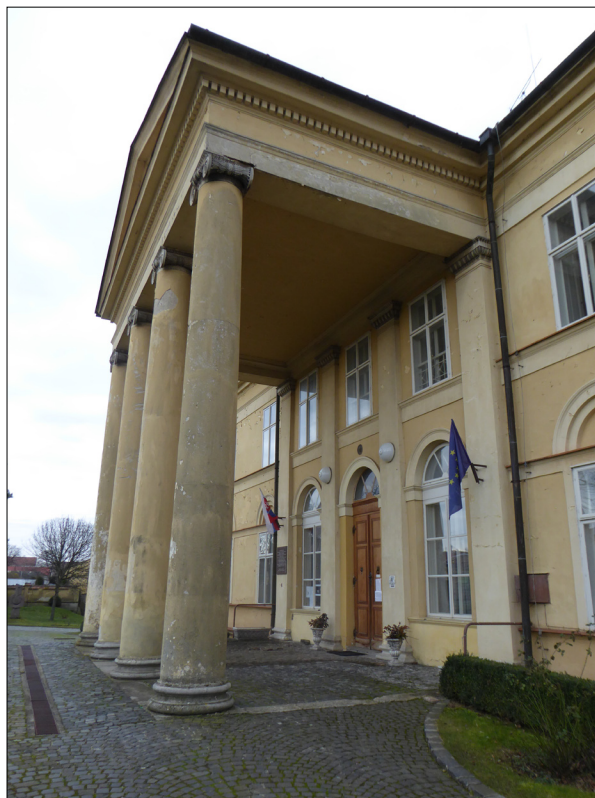
6. SV portikus s hlavným vstupom
