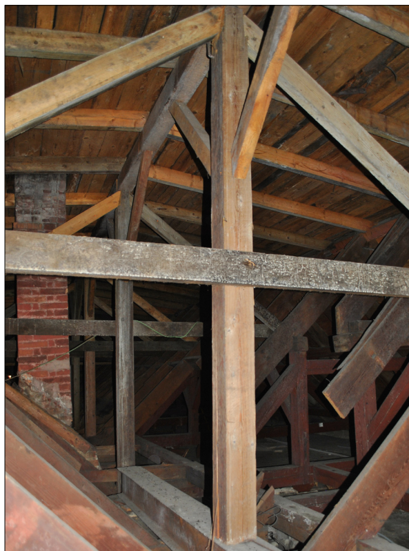
85. Krovová konštrukcia strednej mladšej časti
