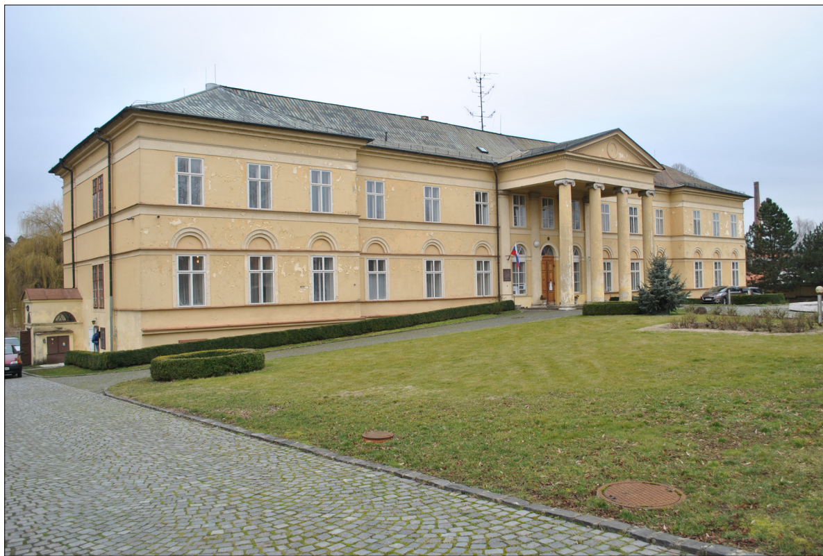
2. Pohľad na hlavnú fasádu kaštieľa z východu
