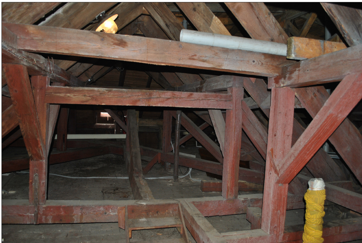
83. Krovová konštrukcia pôvodnej sedlovej strechy
