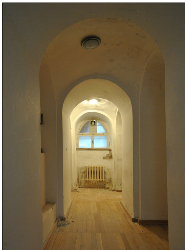
38. Miestnosť č. 013, pohľad na JV
