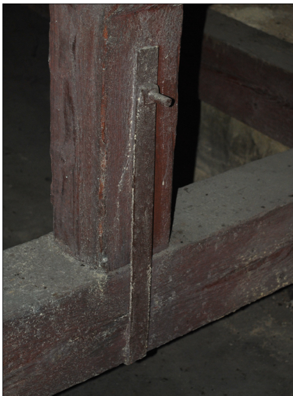
89. Krov pôvodnej sedlovej strechy – strmeň väzného trámu a stĺpika
