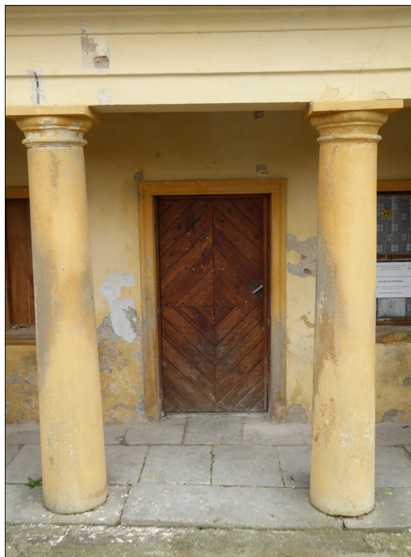
18. Vrátnica – hlavný vstup pod portikom
