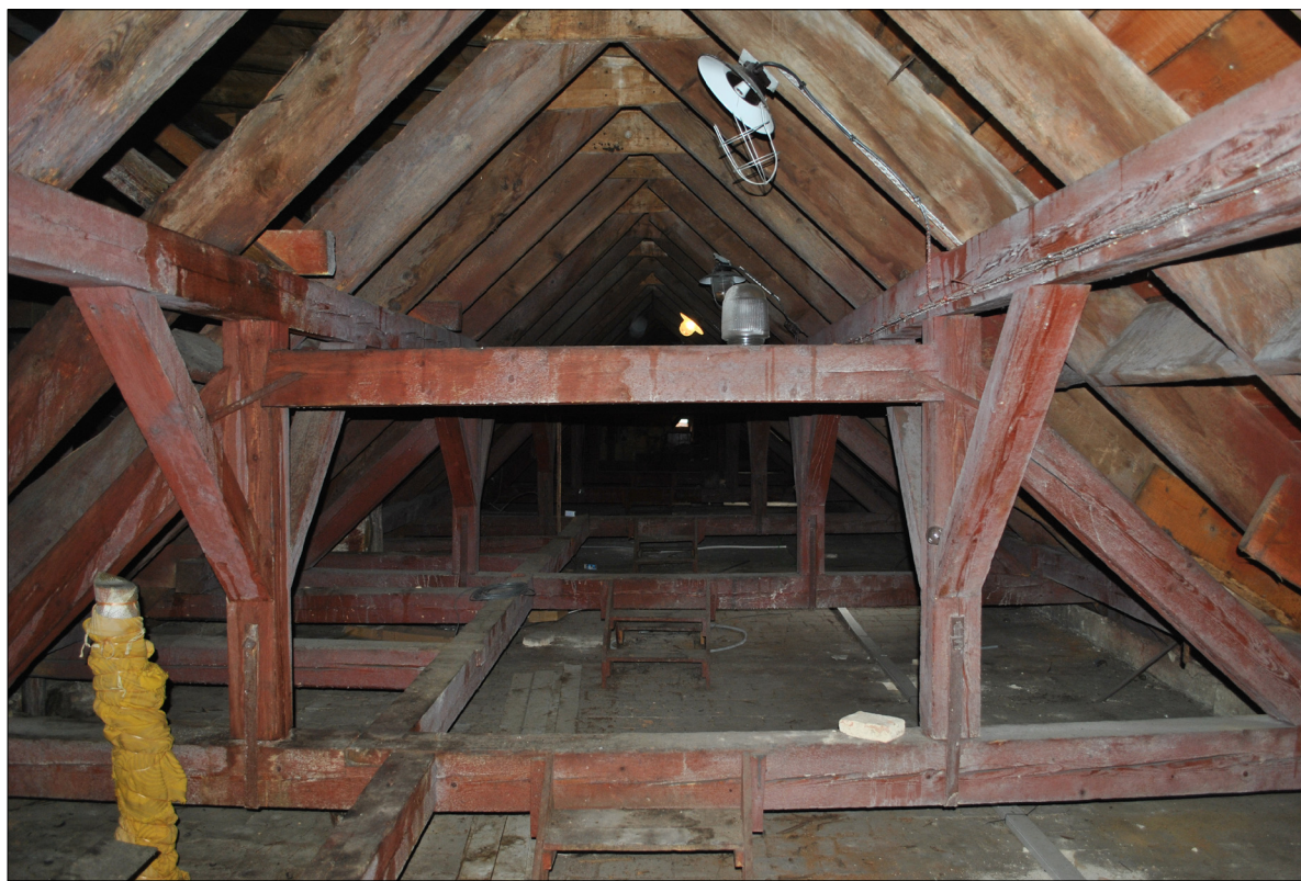
82. Krovová konštrukcia pôvodnej sedlovej strechy
