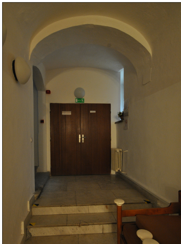
29. Miestnosť č. 003, vľavo vstup na schodisko
