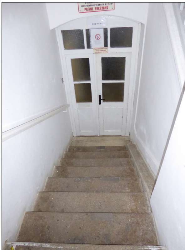
62. Schodisko JV rizalitu smerom na I. PP
