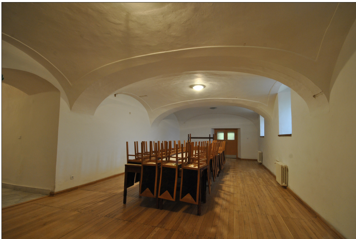
41. Miestnosť č. 011, pohľad na JV
