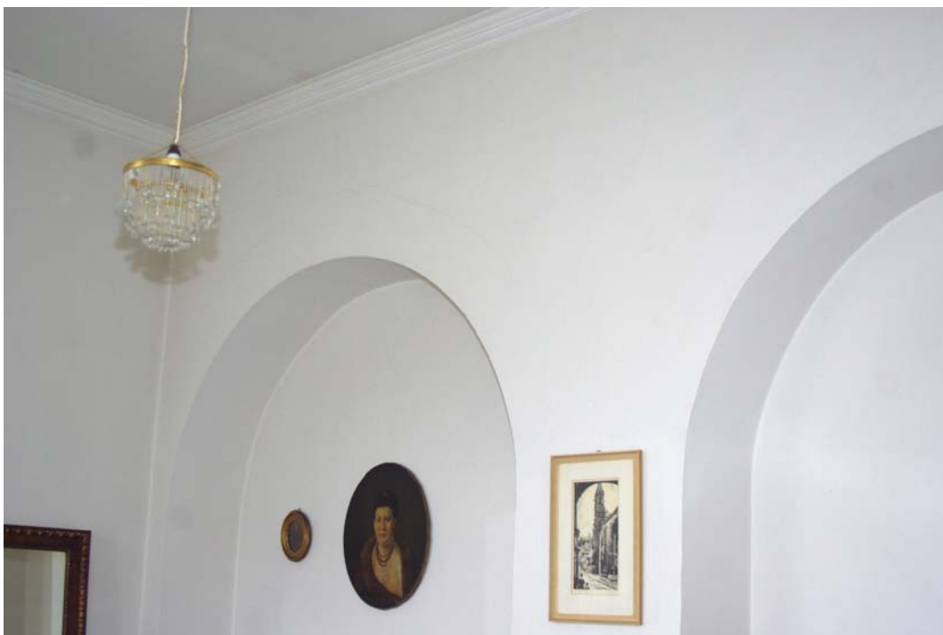
Pohľad na arkády "salónika" na poschodí.
