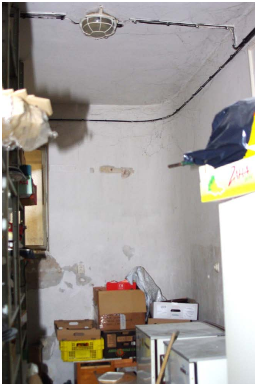
Pohľad na časť severnej steny bývalej kaplnky. Predňou stál oltár. Bývalý priestor v súčasnosti horizontálne predelený na dve miestnosti. Na ľavej strane je časť novodobého okna, ktoré bolo potrebné vybrať na osvetlenie skladového priestoru.
