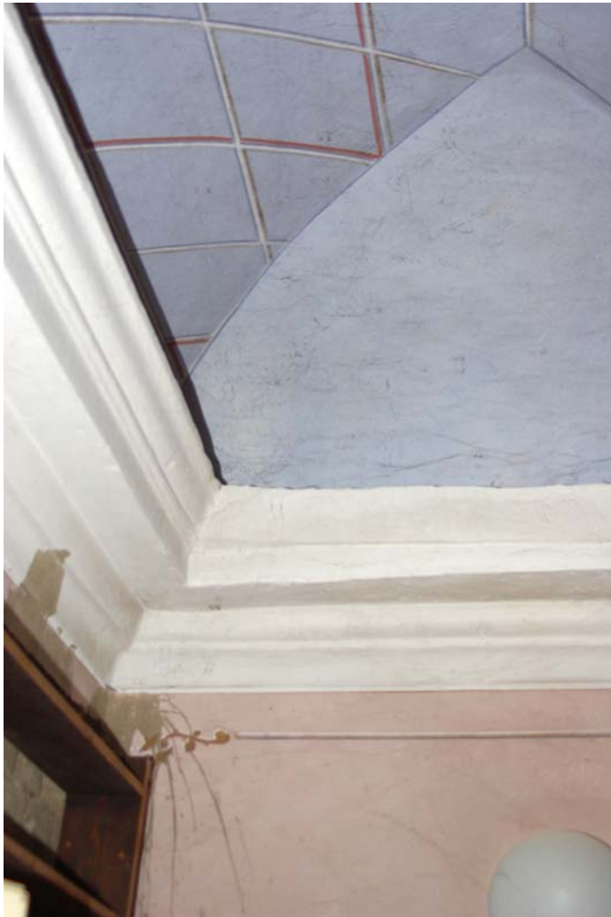
Klenba interiéru vrátnice.
