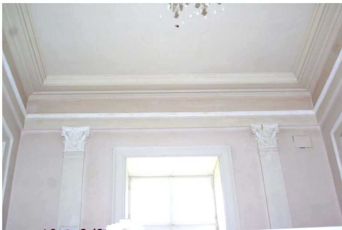
Stena chodby nad schodiskom.
