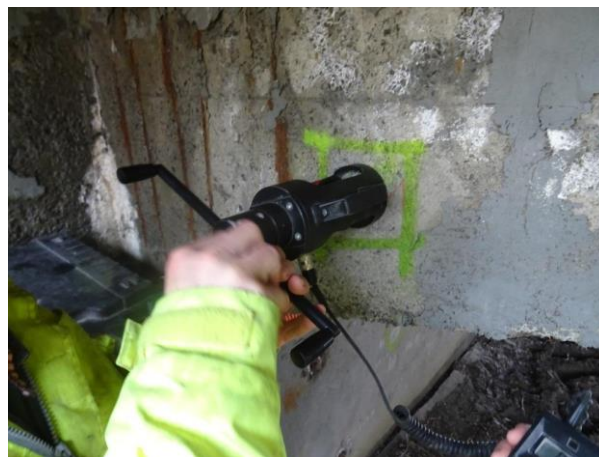
Pohled na samotné zkoušení trhacím přístrojem COMING OP1.
