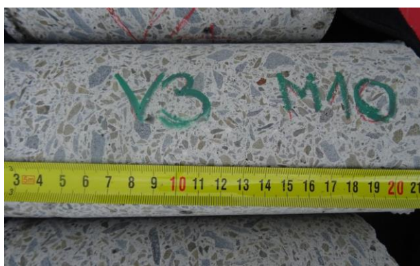
Detailní pohled na jádro vývrty V3.
