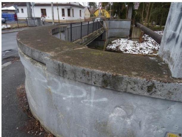
Pohled na obloukové masivní betonové zábradlí navazující na zábradlí ocelové.
