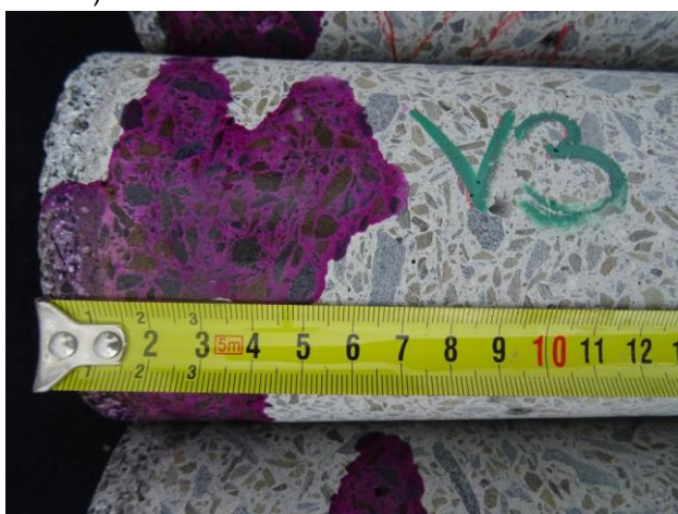
Karbonatce na vývrtnu V3 byla naměřena 10 mm (v omítce).
