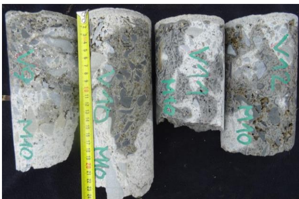
Pohled na vývrty V9, V10, V11 a V12 z OP1 a OP2. Velmi vysoká pórovitost zrn kameniva, viditelné nedohutněná místa při samotné betonáži.
