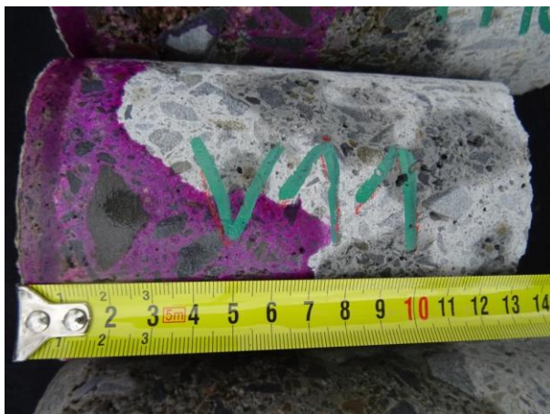
Vývrt V11, kde karbonatace omítky byla naměřena 5 mm. Omítka chrání beton.
