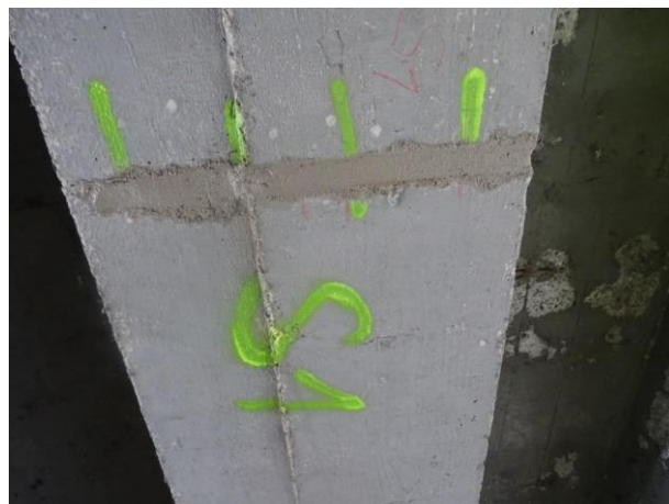
Pohled na zapravení sondy S1.
