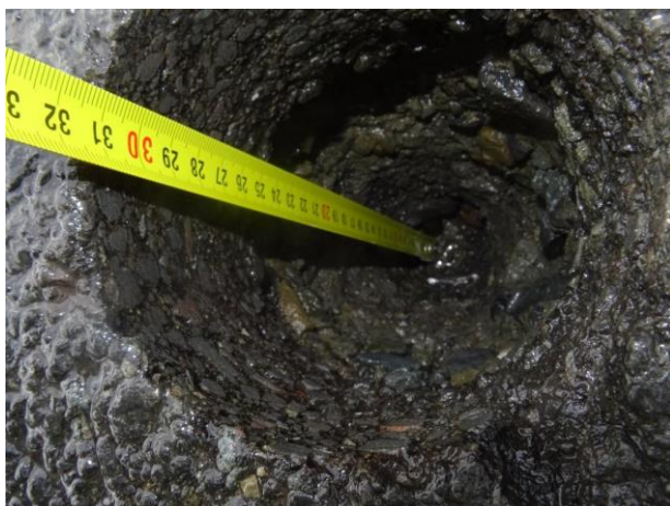
Pohled do sondy. Viditelný štěrkopískový násyp a viditelná vrstva asfaltového krytu.
