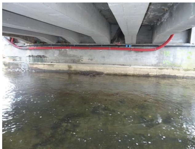
Pohled na opěru OP2.
