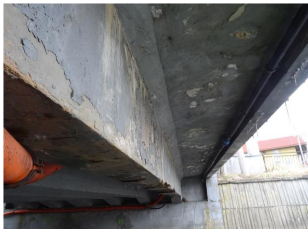
Pohled na navazující nábrežní zeď z betonových prefabrikátů u OP1. Strana vtoku.
