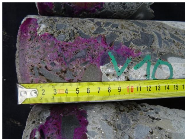
Vývrt V10, kde karbonatce omítky byla naměřena 5 mm. Omítka chrání beton.
