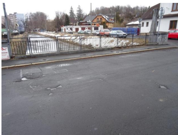
Pohled na levou stranu tvořenou obrubou a asfaltovým chodníkem.
