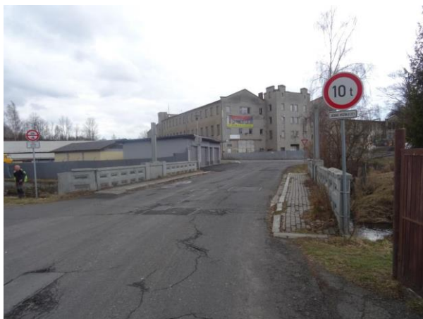
Celkový pohled na svršek mostu ze strany OP1.
