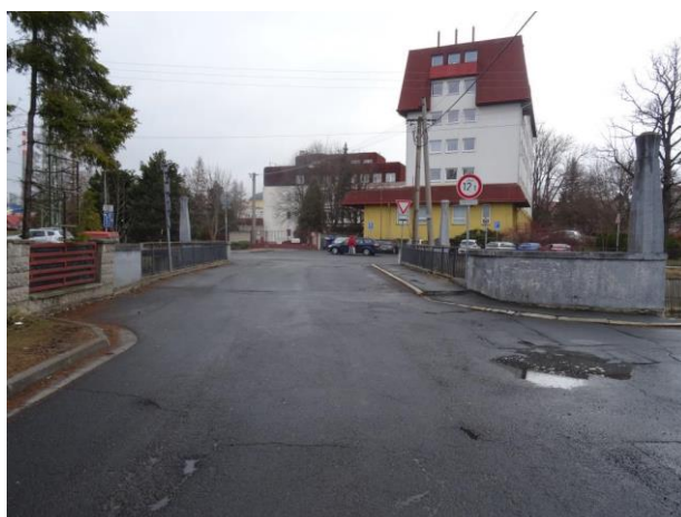
Celkový pohled na svršek mostu ze strany OP2.
