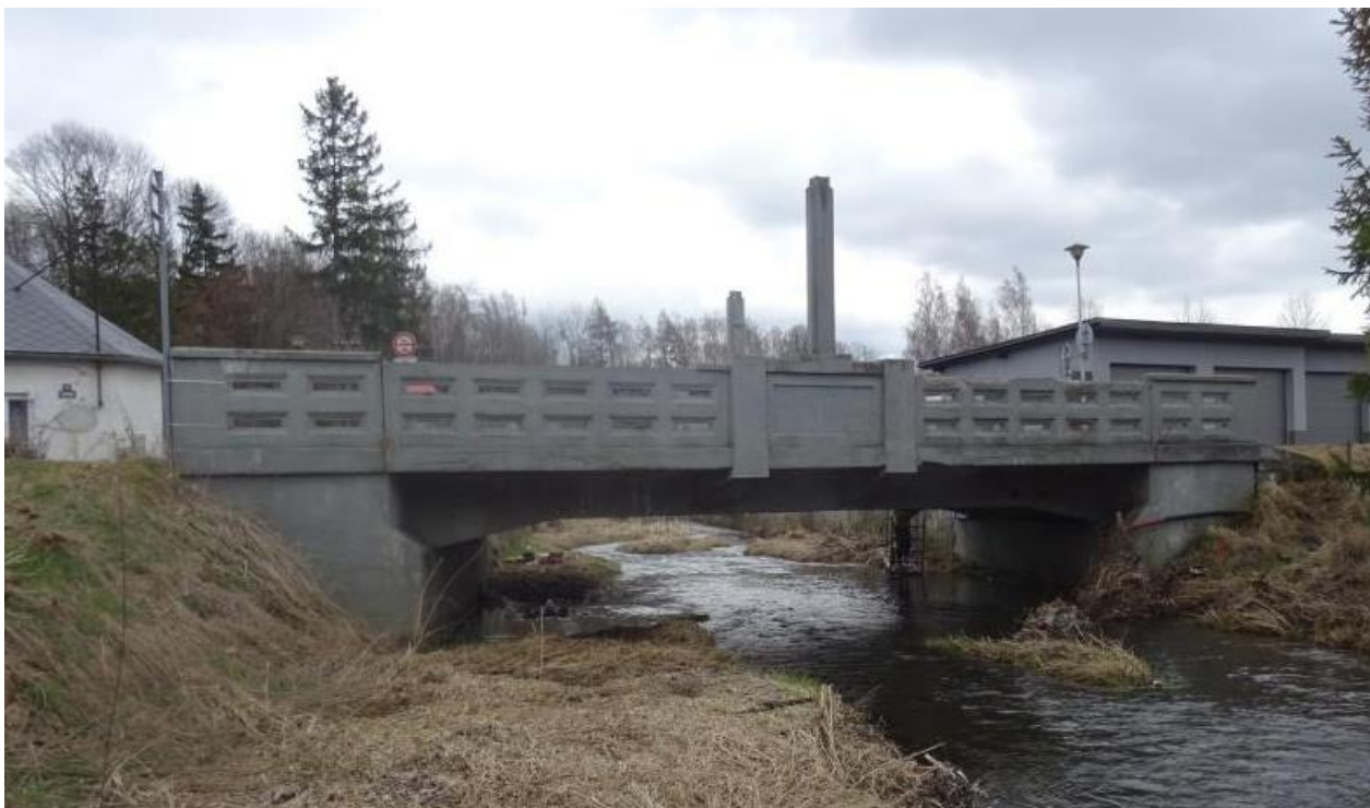
Pohled na mostní konstrukci, pravá strana, vtok.
