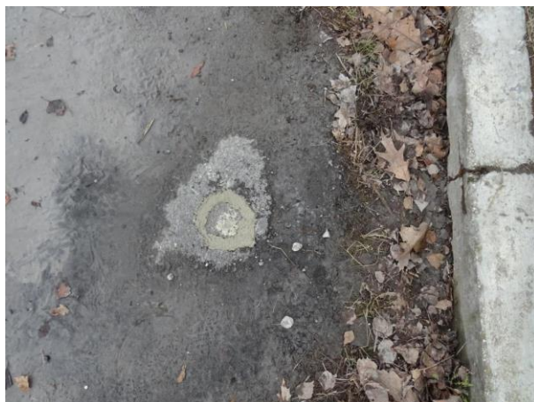
Pohled na zapravení sondy do kryty vozovky.
