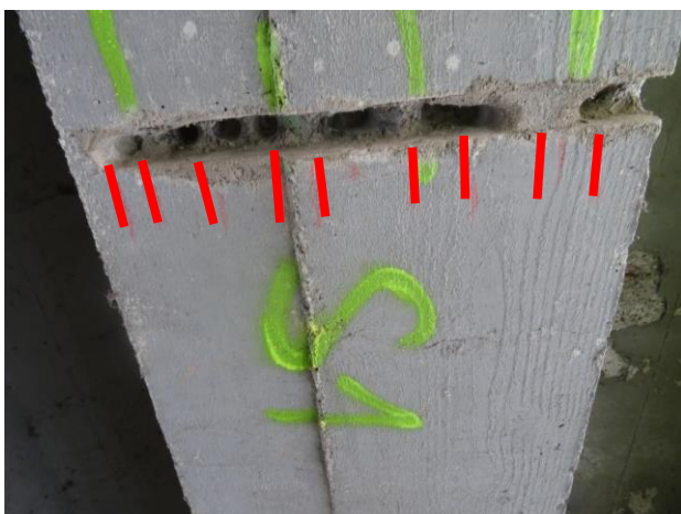
Pohled na sondu S1. 9 x hladká výztuž průměru 35 mm ve spodním lici uprostřed rozpětí.
