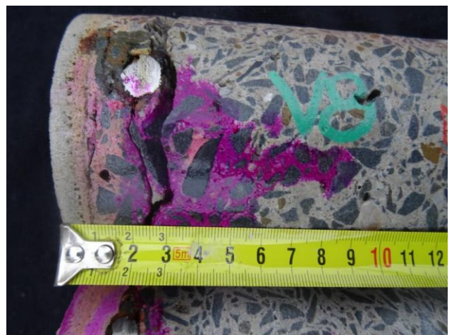
Karbonatce na vývrtnu V8 byla naměřena 25 mm.
