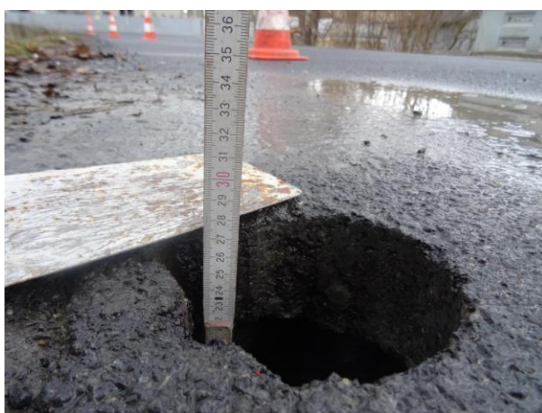
Celková tloušťka souvrství byla naměřena 280 mm.
