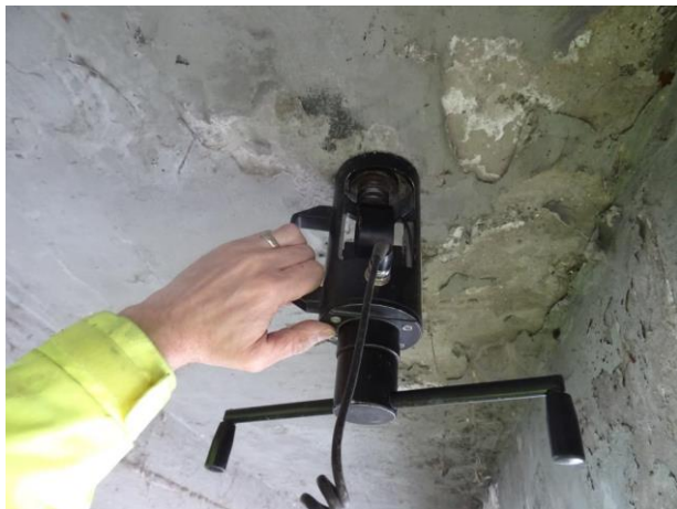
Pohled na samotnou zkoušku na provedenou na spodním líci železobetonové desky.
