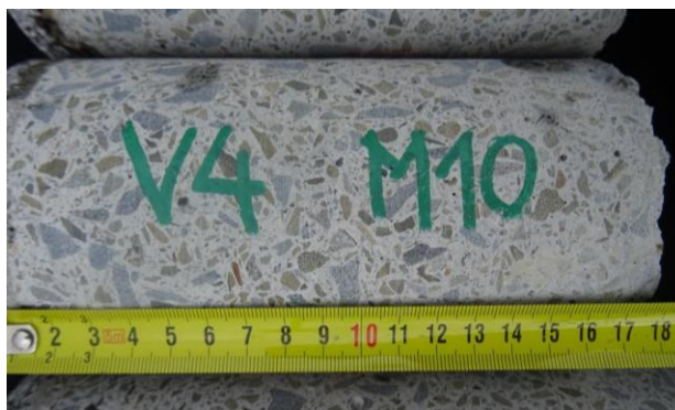
Detailní pohled na jádro vývrty V4.
