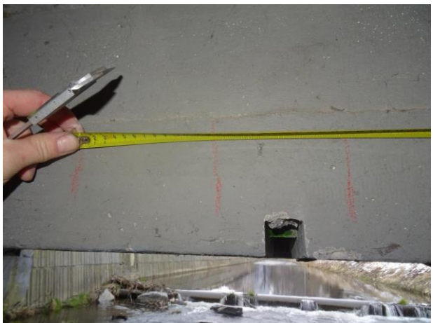
Pohled na detekci třmínků po 150 mm.
