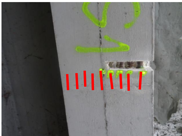
Pohled na sondu S1. 9 x hladká výztuž průměru 35 mm ve spodním líci uprostřed rozpětí.
