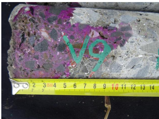
Vývrt V9 s částečně odpadlou omítkou, kde karbonatce betonu byla na betonu naměřena 10 mm. Vývrt V10, kde karbonatce omítky byla naměřena 5 mm. Omítka chrání beton.
