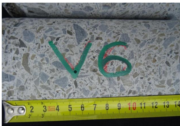
Detailní pohled na jádro vývrty V6.
