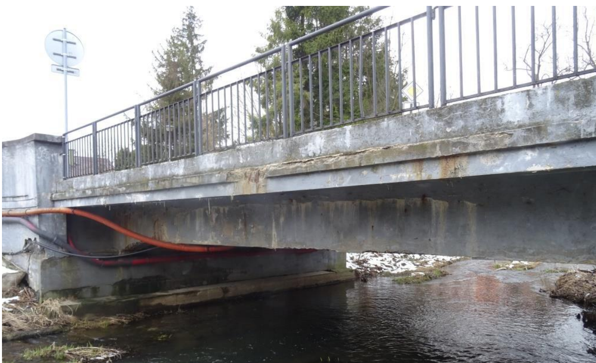
Pohled na mostní konstrukci ze strany vtoku.
