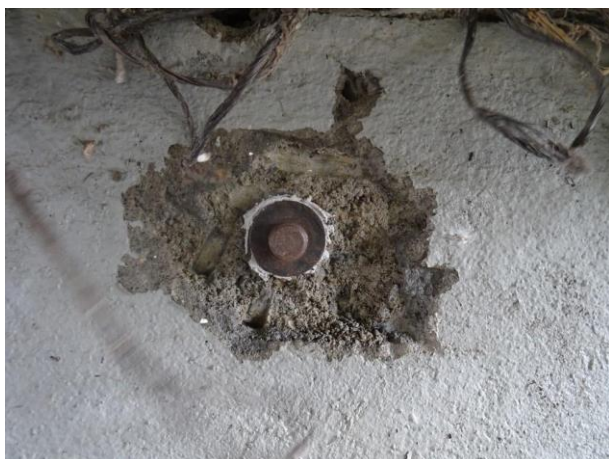
Pohled na nalepený terč na dříku opěry. Byla odstraněna vrstva omítky.
