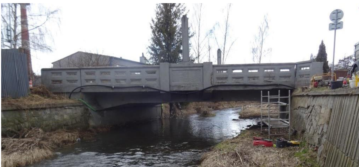
Pohled na mostní konstrukci, levá strana, strana výtoku.
