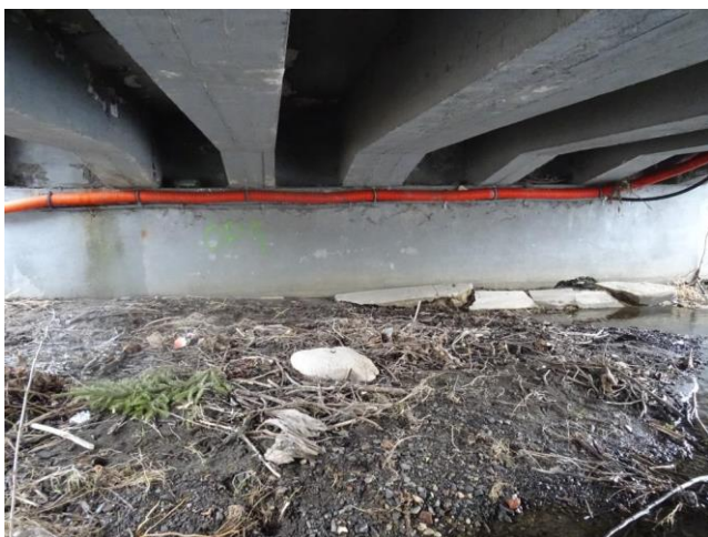
Pohled na opěru OP1.
