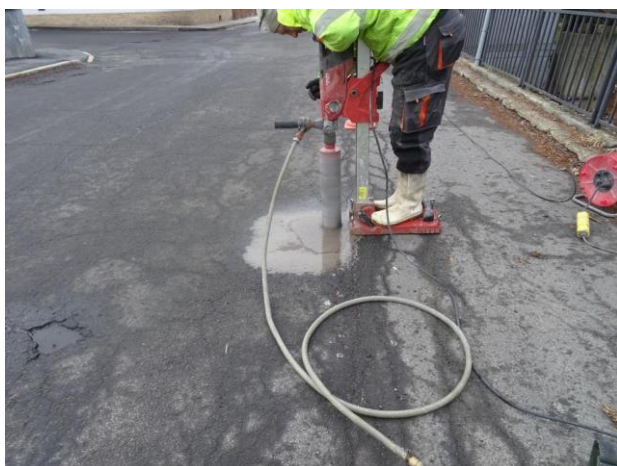
Pohled na jádrové vrtání do krytu vozovky.
