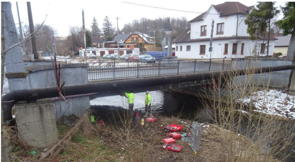
Pohled na mostní konstrukci ze strany výtoku.
