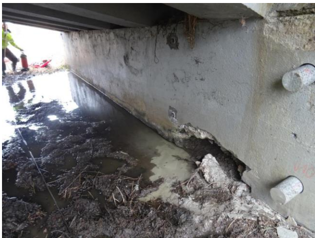
Celkový pohled na opěru OP1.
