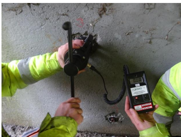
Pohled na samotnou zkoušku odtrhovým přístrojem COMING OP1.
