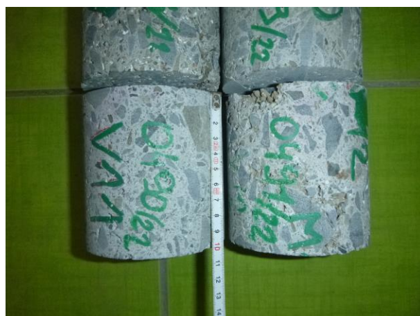
Detailní pohled, viditelná pórovitost v betonu vzorků.
