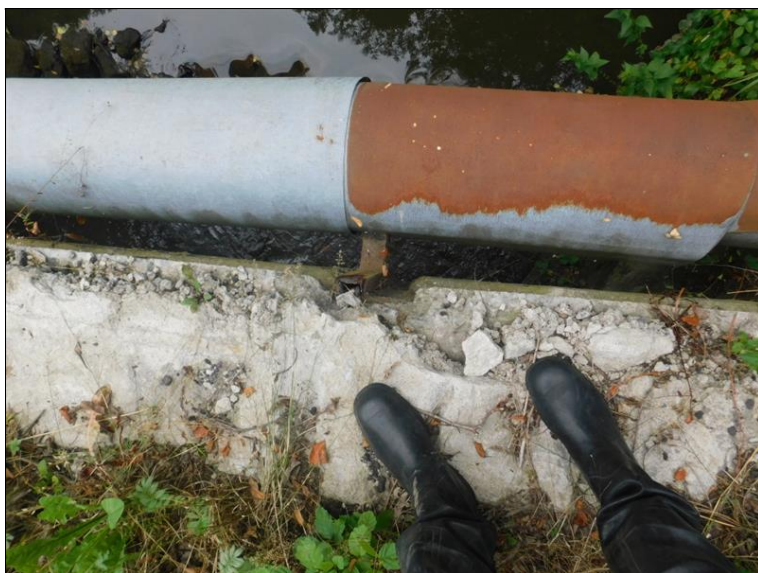
Horní líc nadbetonávky nad krajním nosníkem na pravé straně degraduje.
