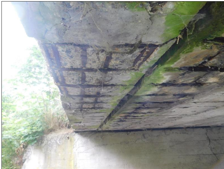
Plošná separace krycí vrstvy betonářské výztuže na spodním líci dvou krajních nosníků na levé straně - silná koroze betonářské výztuže.
