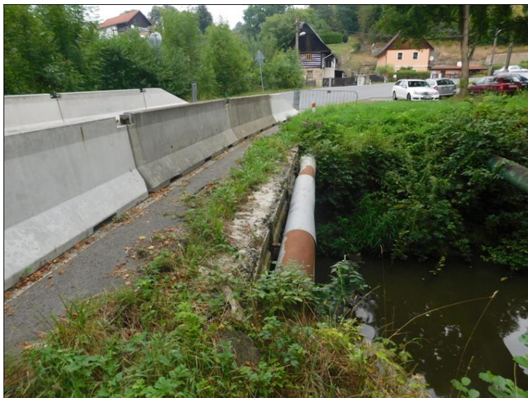
Demontovaná římsa na pravé straně, uchycená vegetace.
