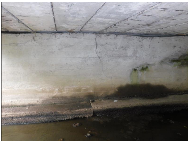
Svislá / šikmá trhlina v dříku opěry OP2.
