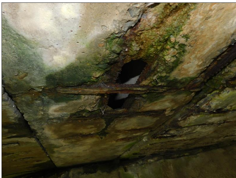
Úplná degradace spodní desky nosníku - odhalená vnitřní dutina, silná koroze betonářské výztuže.
