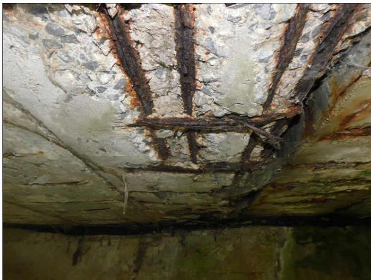
Detail degradace betonu a koroze betonářské výztuže.
