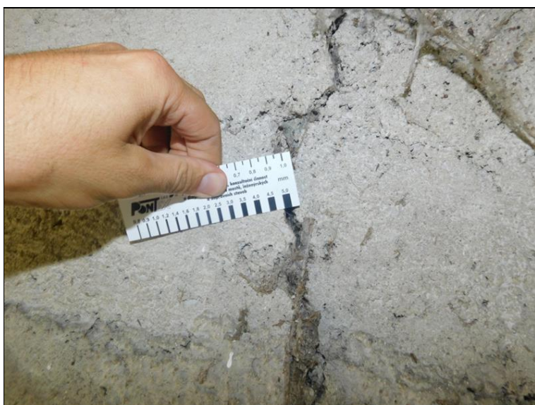
Svislá / šikmá trhlina v dříku opěry OP2, šířka trhliny 5,0 mm.
