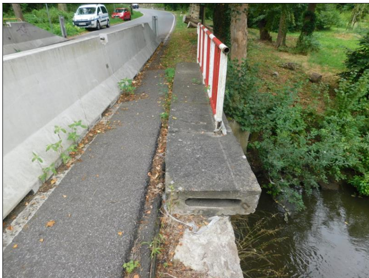
Zbytky římsy na levé straně mostu - část římsy spadla pod most.
