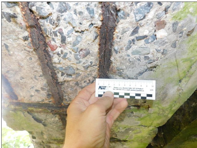
Detail degradace betonu a koroze betonářské výztuže.
