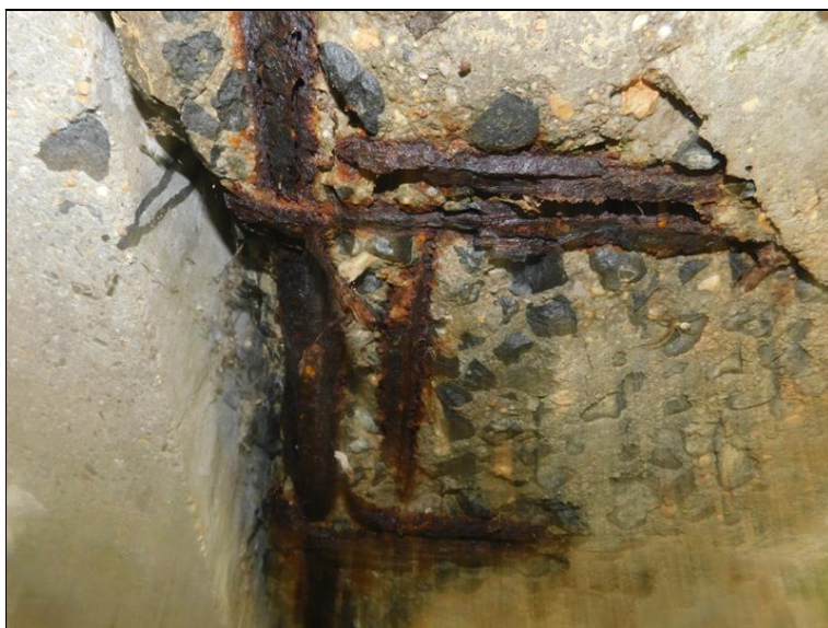
Detail degradace betonu a koroze betonářské výztuže.
