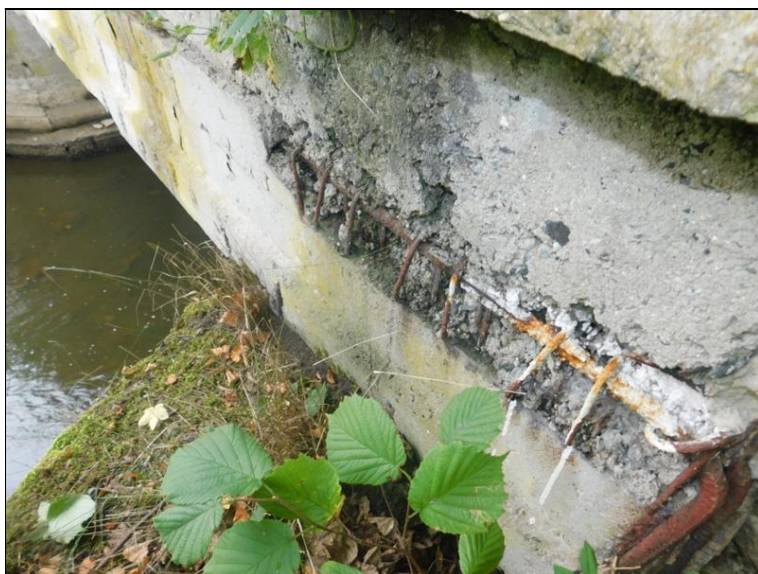
Nedostatečně zabetonovaná výztuž na levém boku nosné konstrukce nad opěrou OP1.
