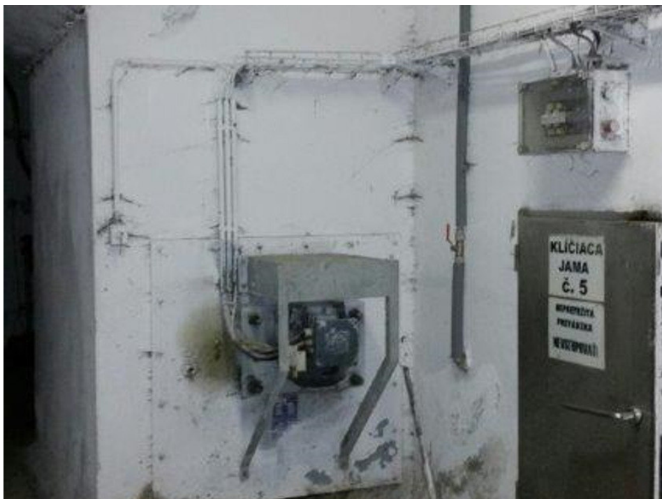
Obrázok č.9.: Pohľad na zastaraný dvojotáčkový ventilátor v klíčiacej skrini č. 5
