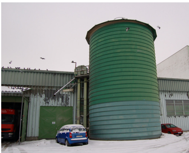
Obrázok č.7.: Vonkajší zásobník na uskladnenie sladu so zastaranými dopravnými cestami
