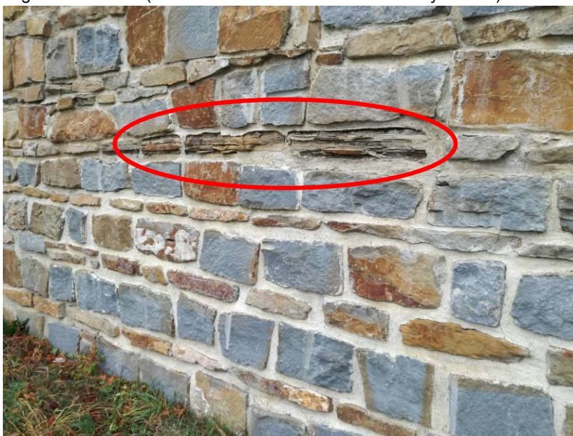
Obr. 6: Příklad degradace staviva (kamenů zvětráním a vlivem klimatických vlivů)
