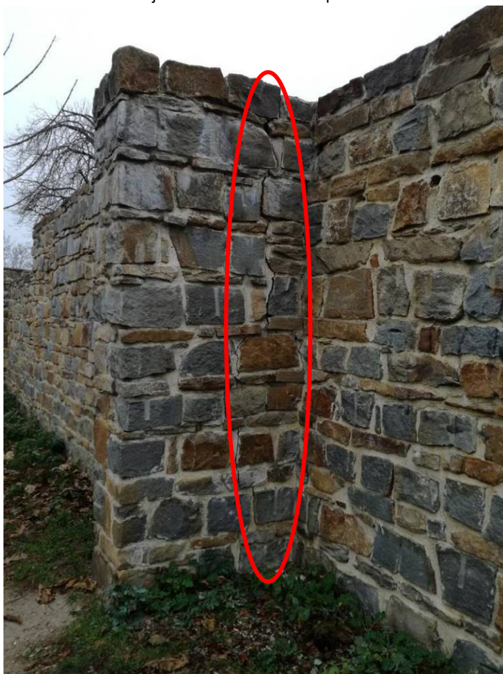
Obr. 7: Příklad trhlin na zdivu hradeb - jednostranná trhlina na pilíři zdiva
