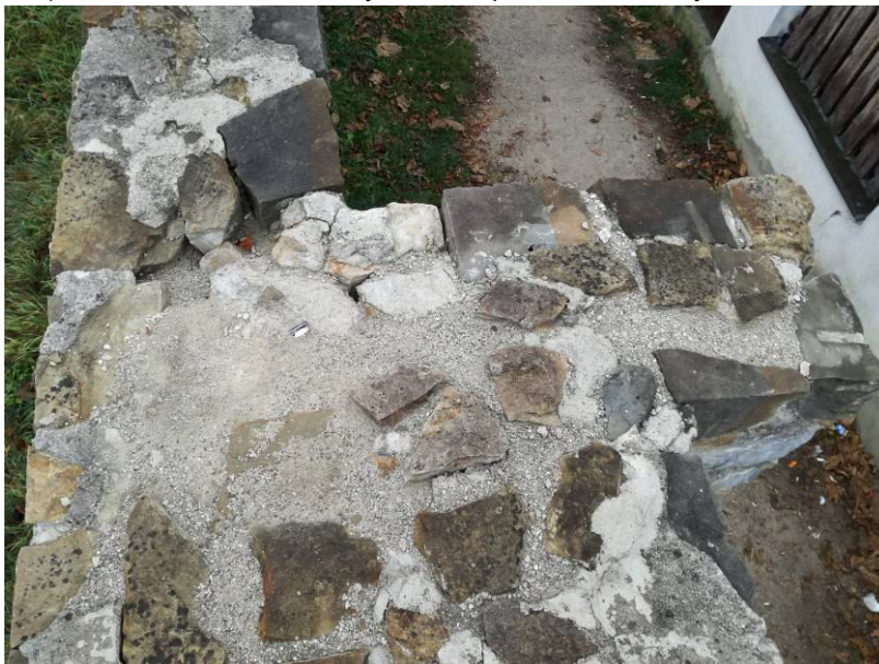
e) Trhliny na koruně orientované kolmo na zdivo severozápadní část hradeb
