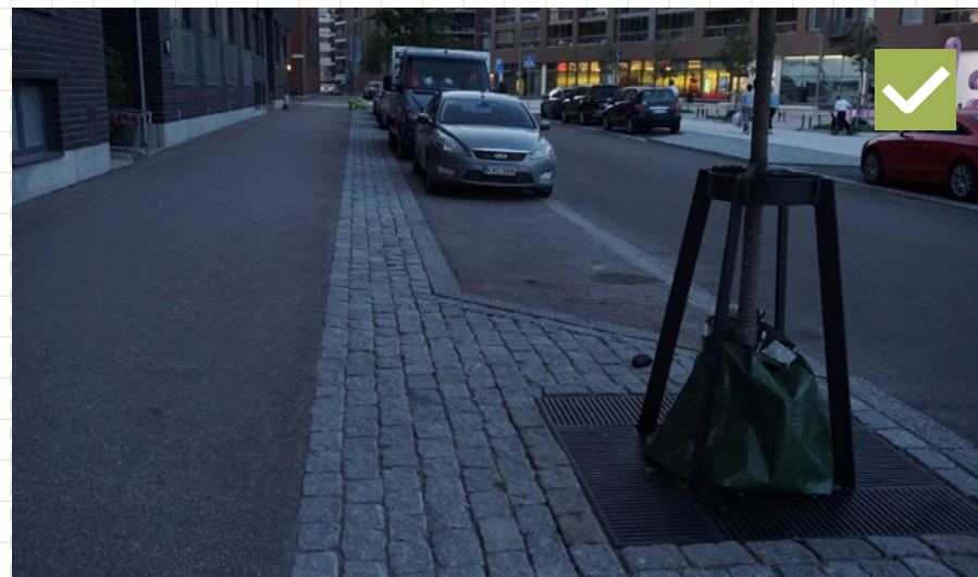
19 Trvalá vodorovná ochrana stromov pred pojazdom a parkovaním vozidiel v kombinácii so zvislou ochranou. Helsinki, Fínsko
