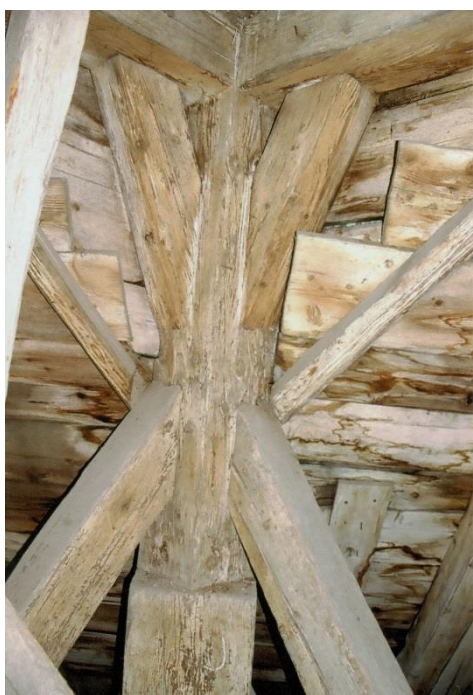
detail přechodu spodní a horní části krovu na J nároží horní části
