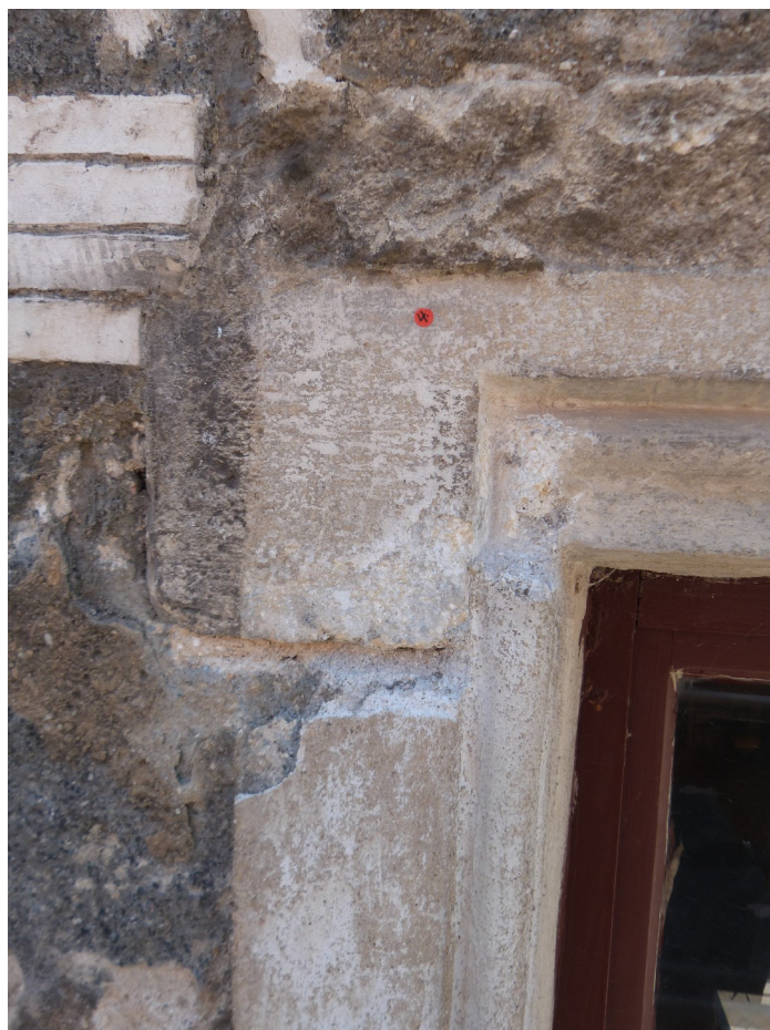
Odhalení kamenného překlady a napojení na štukové šambrány
