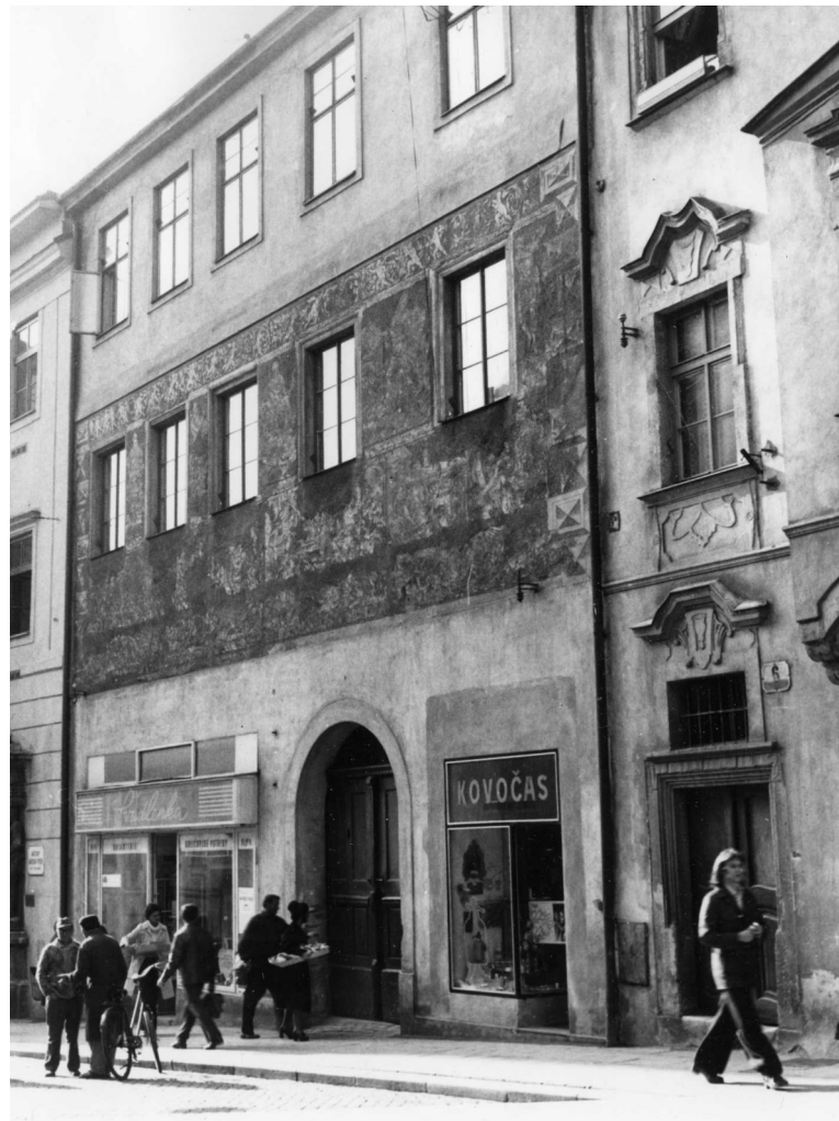
Viditelné opravy pod parapety a zapravení po elektrické instalaci kolem roku 1970
