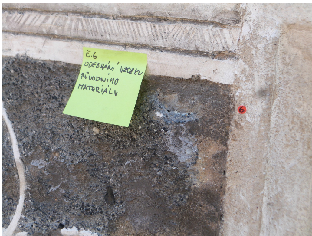
Odebrání vzorku z podkladové probarvené omítky
