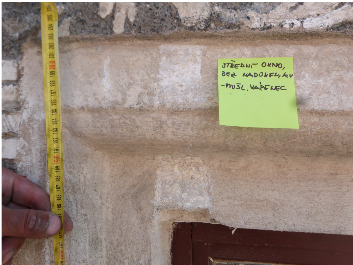
Jediné středové okno bez kamenné profilace okapnice
