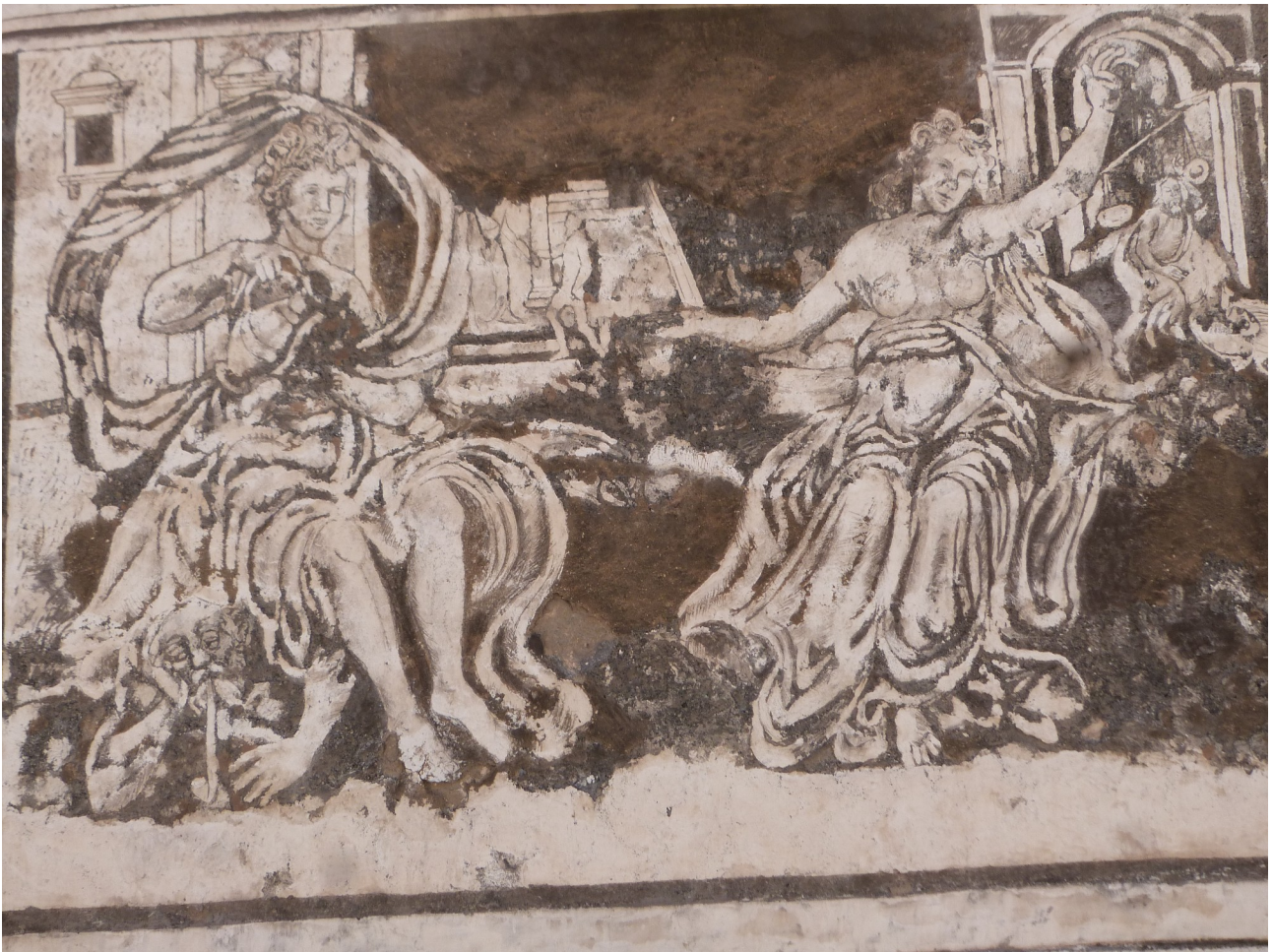
Alegorie č.3 Iustitia vykazuje (stejně jako ostatní části sgrafita) značné množství oprav-průběhový horizontální pás s draperií a části holení obou sedících figur
