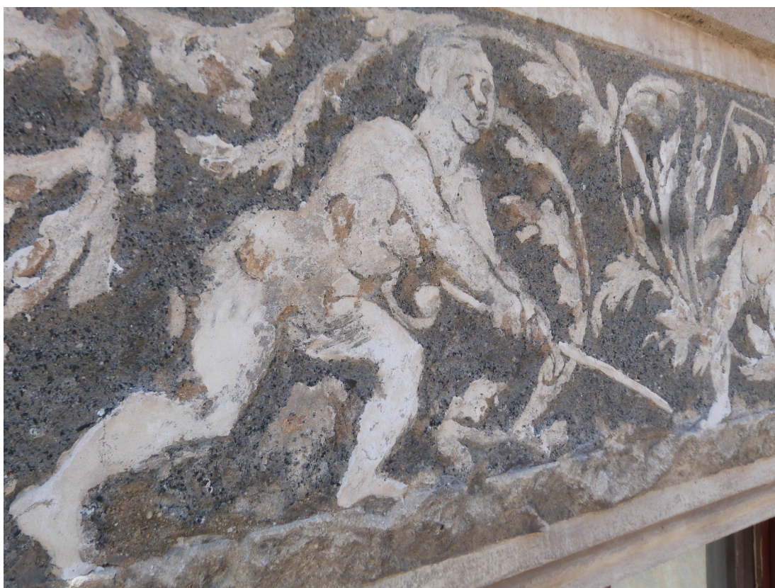
Dekoratívní výplň, opravy kletování a načervenalé tmely pozdějších oprav
