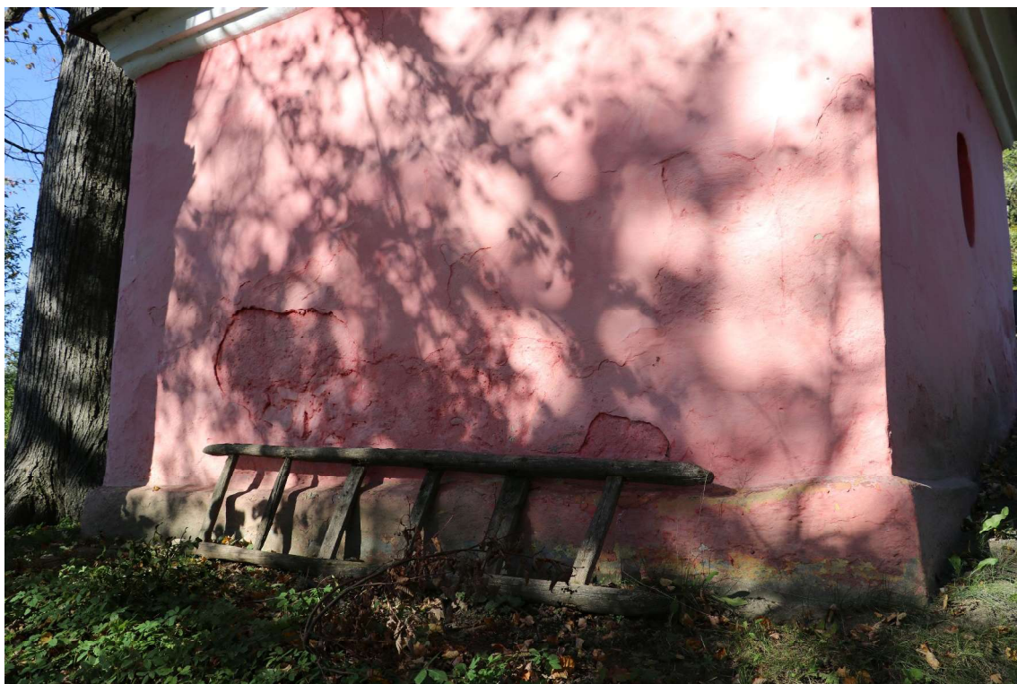
fot. 15: Kapliczka domkowa - widoczne ubytki tynku elewacyjnego zamalowane farbą.
