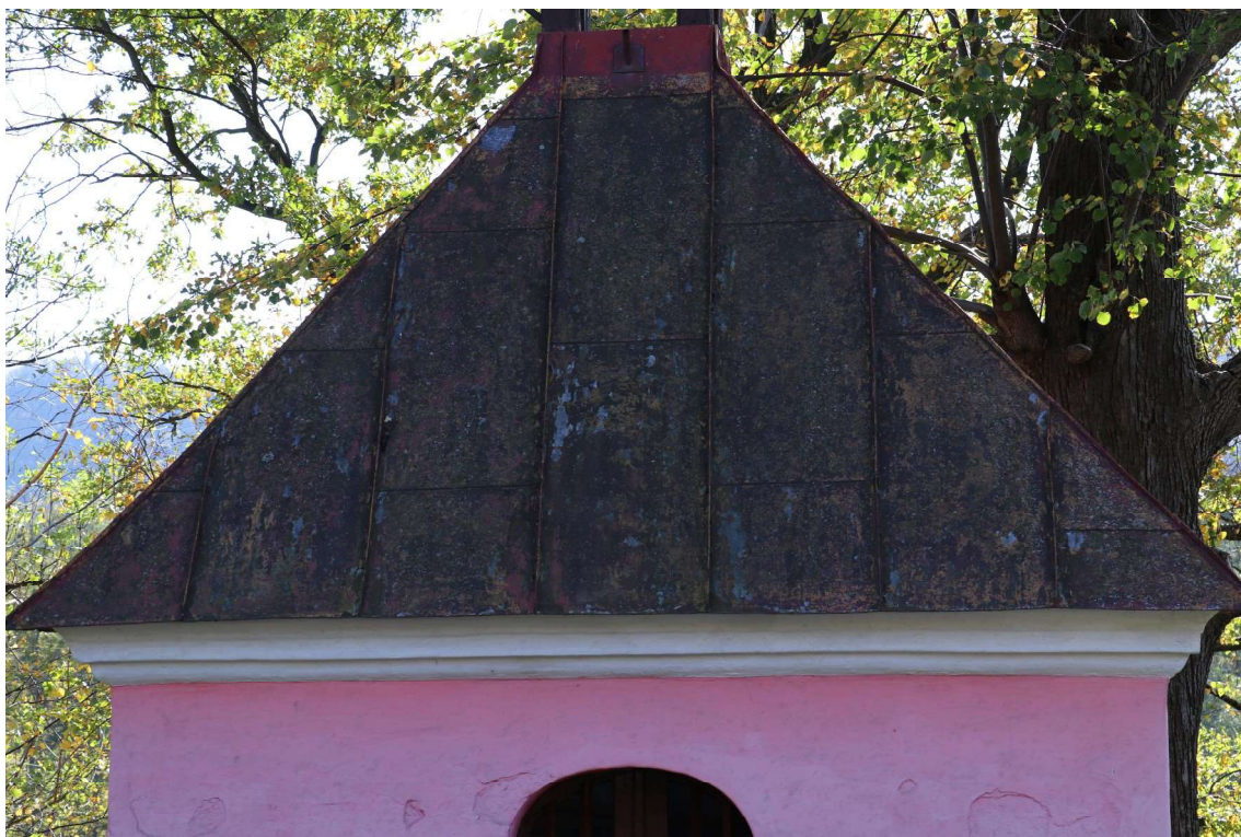
fot. 2: Kapliczka domkowa - dach kapliczki pokryty nalotem biologicznym i atmosferycznym.
