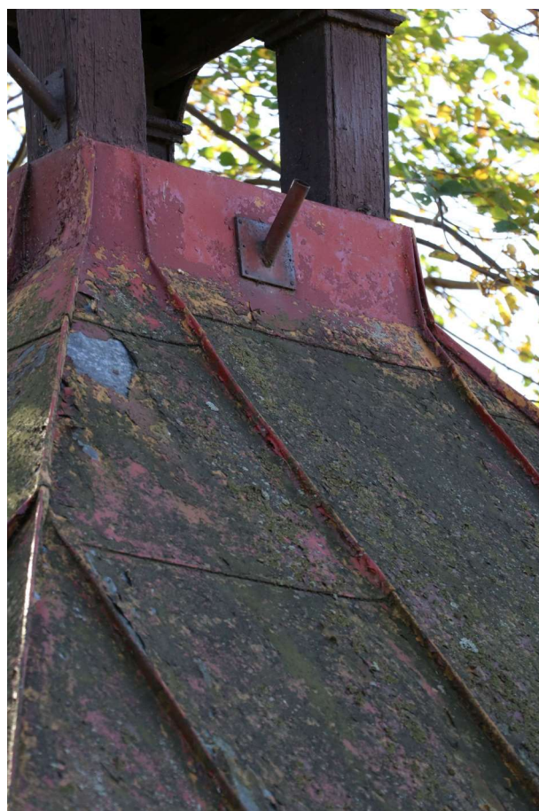
fot. 4: Kapliczka domkowa - fragment pokrycia dachowego pokrytego nalotem biologicznym.
