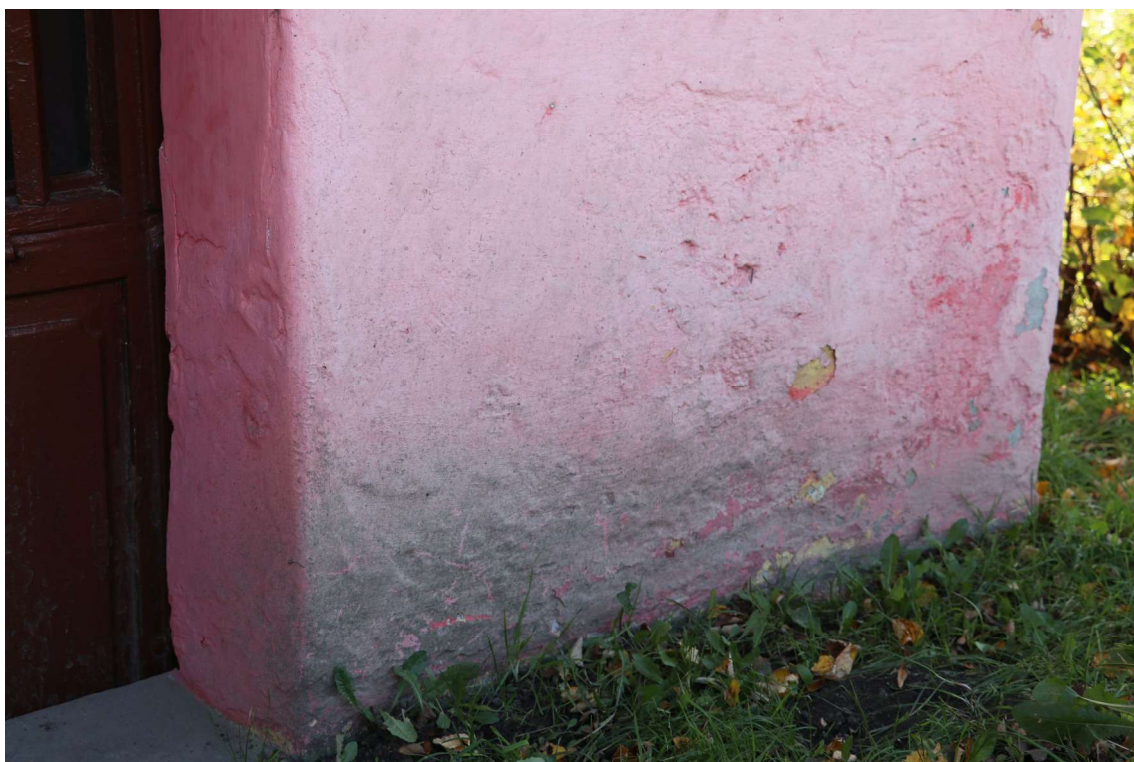
fot. 10: Kapliczka domkowa - widoczne uszkodzenia i nierówności tynku elewacyjnego przy linii gruntu.
