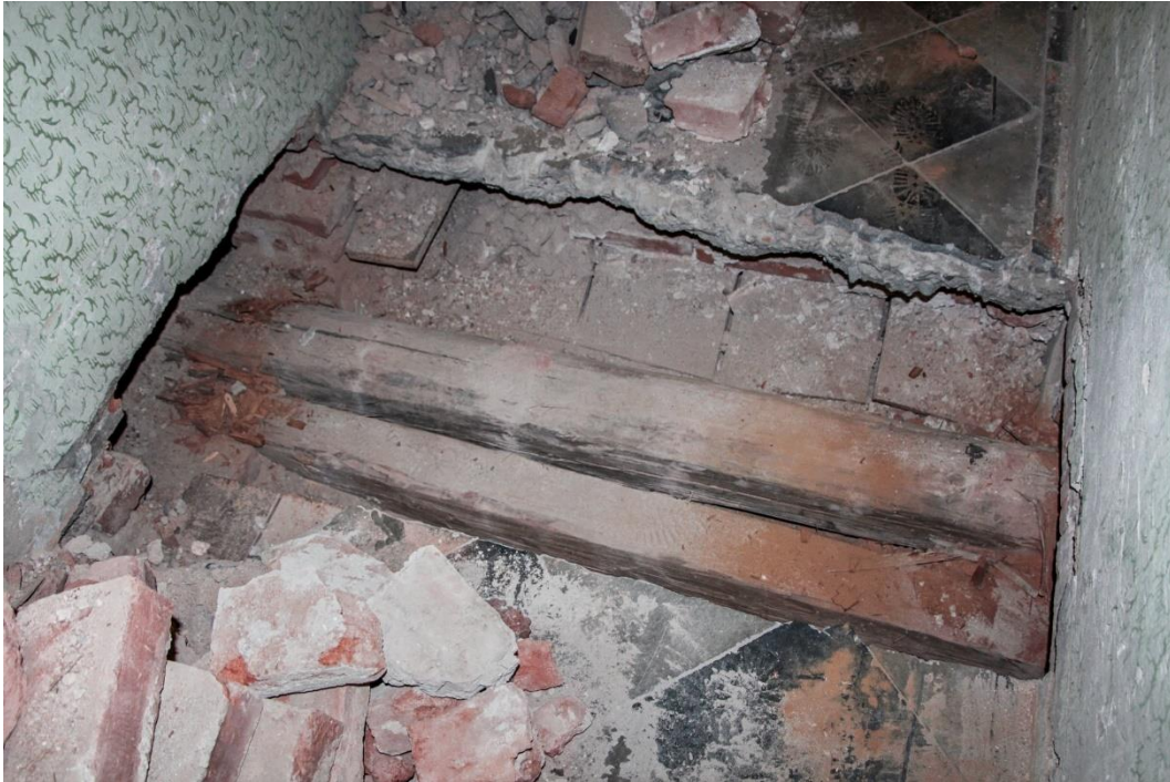
15. Sonda do stropu nad 2.NP na severním konci chodby ve 3.NP.
