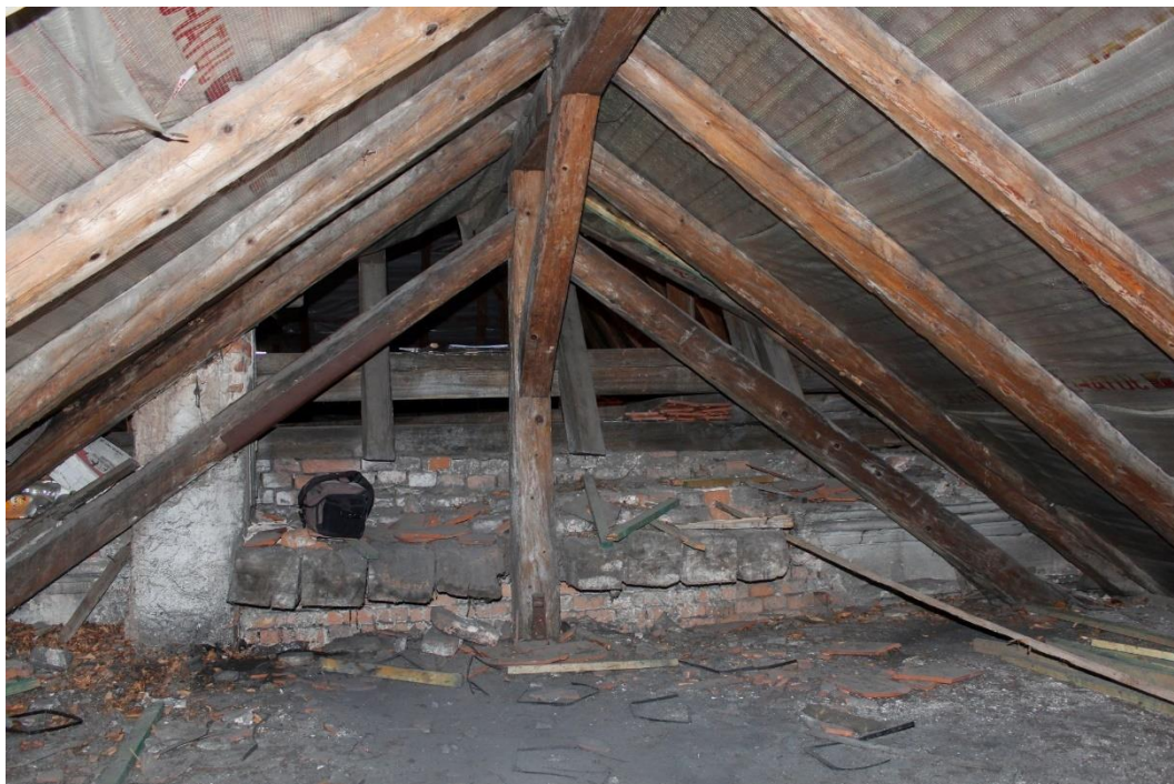
1. Konstrukce krovu východního křídla zámku
