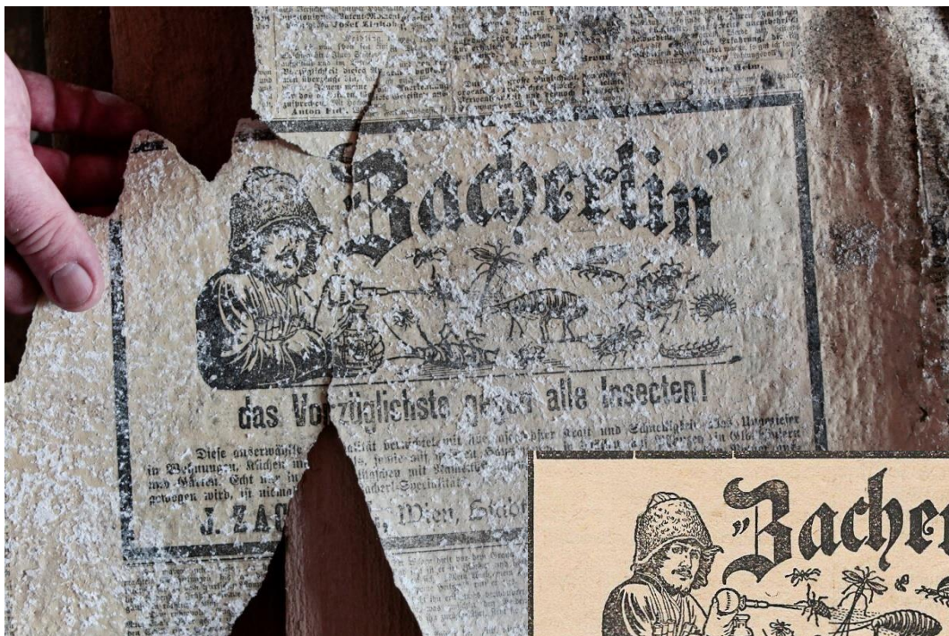
18. Útržek novin z roku 1888, nalezený jako podklad pod tapetou na stěně jedné z místností ve 3.NP, obsahující reklamu na ZACHERLIN - prášek na hubení hmyzích škůdců (jak příznačně z pohledu současného stavu krovu:-). Vyráběl se ve Vídni od roku 1870...
