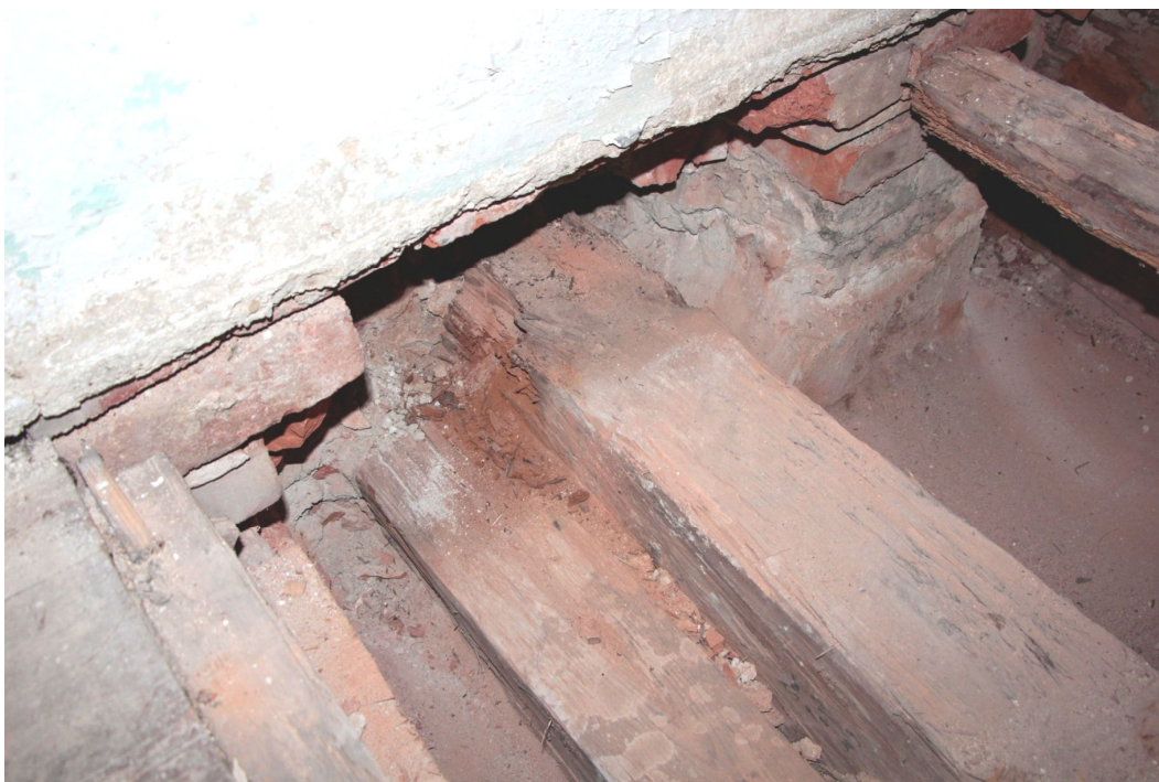
26. Detailní pohled na napadení stropních a podhledových trámů v místnosti č. 302.
