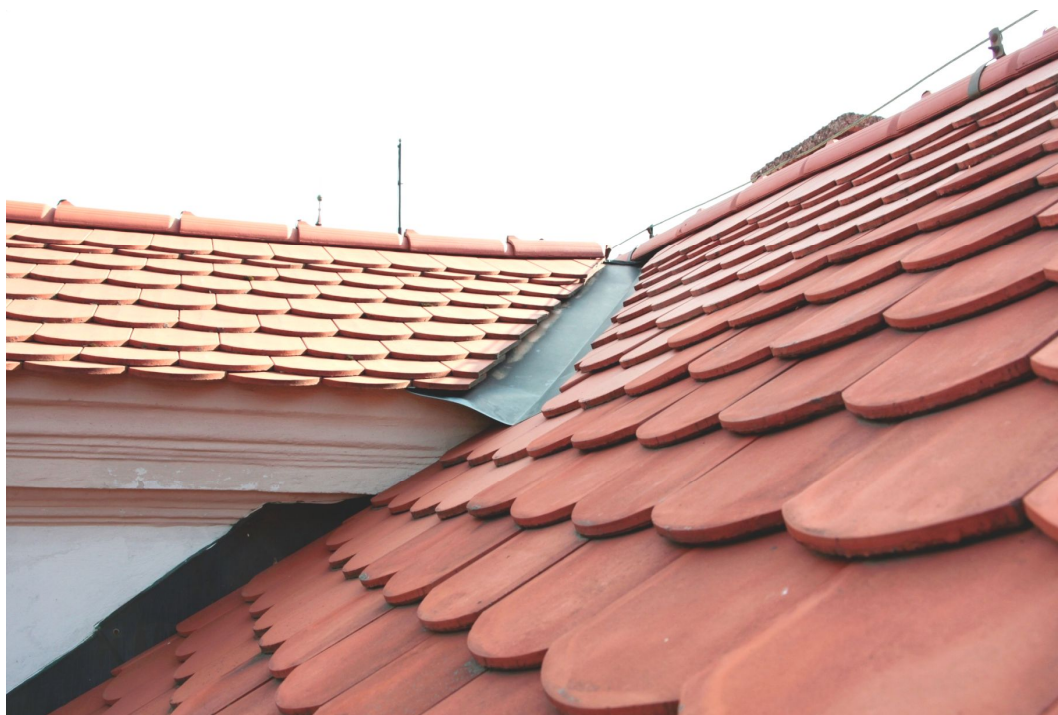
5. Detailní pohled na oplechování úžlabí u centrálního vikýře na východním průčelí.
