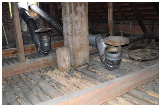
Obr. 4 Ukázka rozmístění skládaného hliníkového potrubí pro přívod horkého vzduchu
