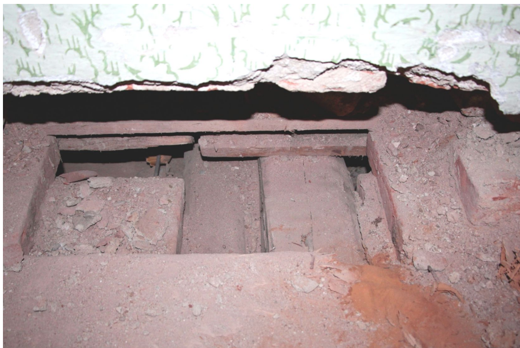
27. Detailní pohled do sondy na jižním konci chodby č. 301 na stropní a podhledový trám zabíhající přes zeď do sousední místnosti č. 302.
