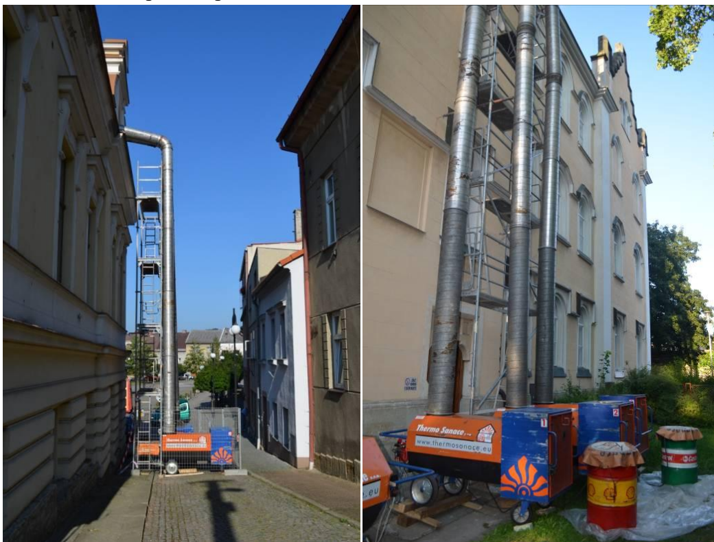
Obr. 3 Ukázka ustavení mobilních horkovzdušných agregátů a vedení skládaného hliníkového potrubí po lešení
