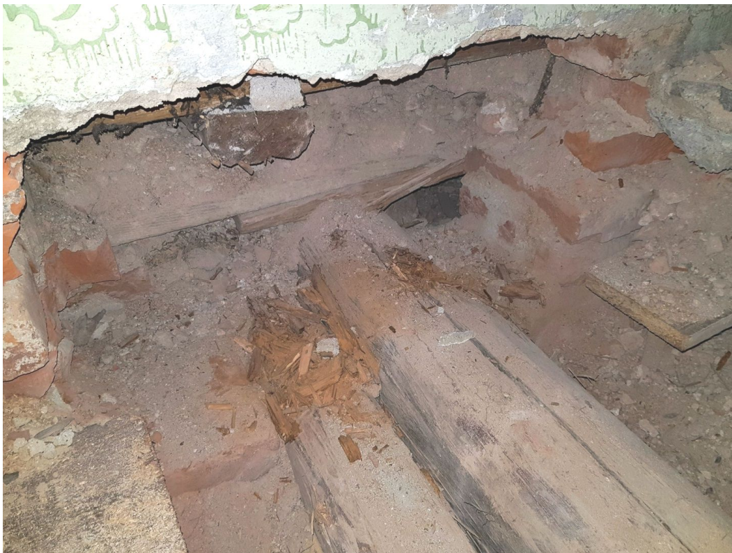
29. Detailní pohled na sondu na severním konci chodby č. 301 s napadením stropního a podhledového trámu dřevomorkou.
