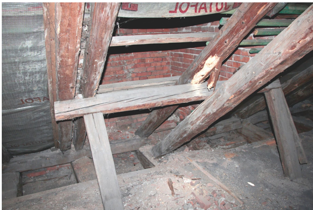
35. Podpurná konstrukce pod boky centrální vikýře na východním průčelí s krokvi a vzpěrou napadenými tesaříkem.
