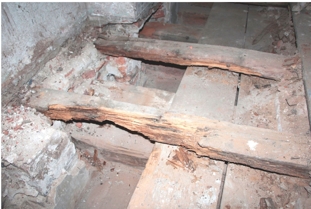
24. Detailní pohled na napadení trámů u stropu a podlahy v místnosti č. 304.
