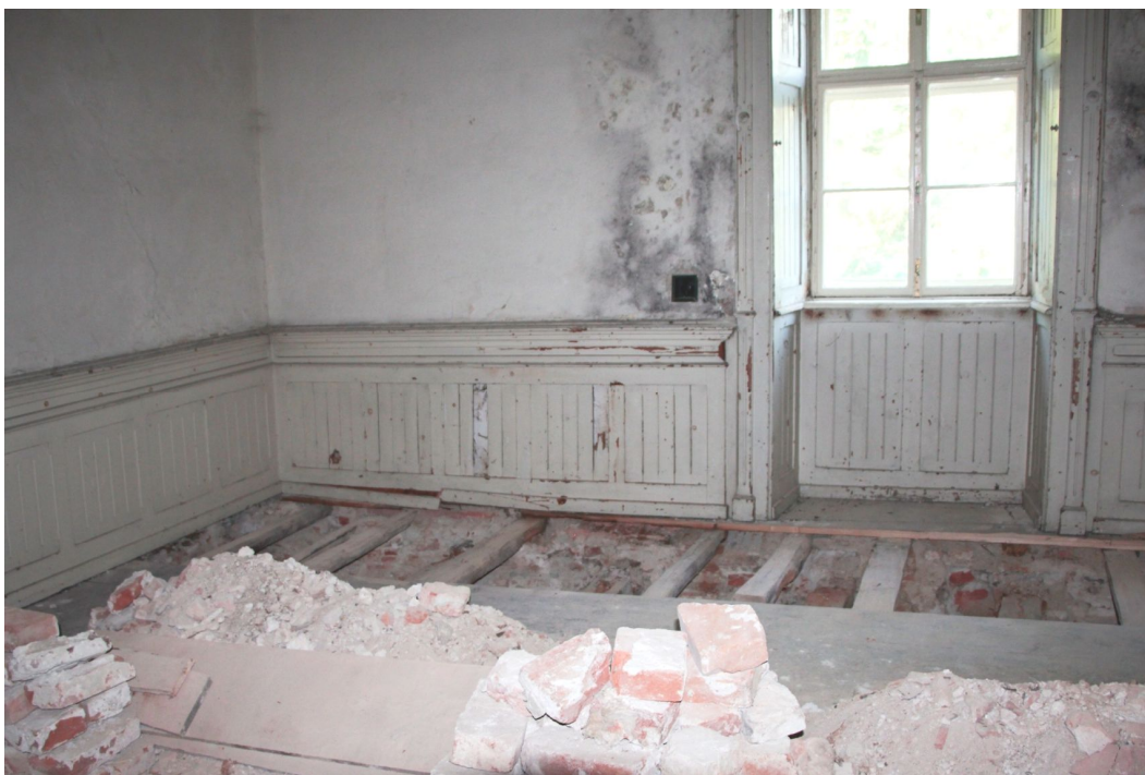
17. Pohled do severovýchodní části místnosti č. 306 s pásovou sondou do stropů a s dřevěným kazetovým obkladem na stěnách.
