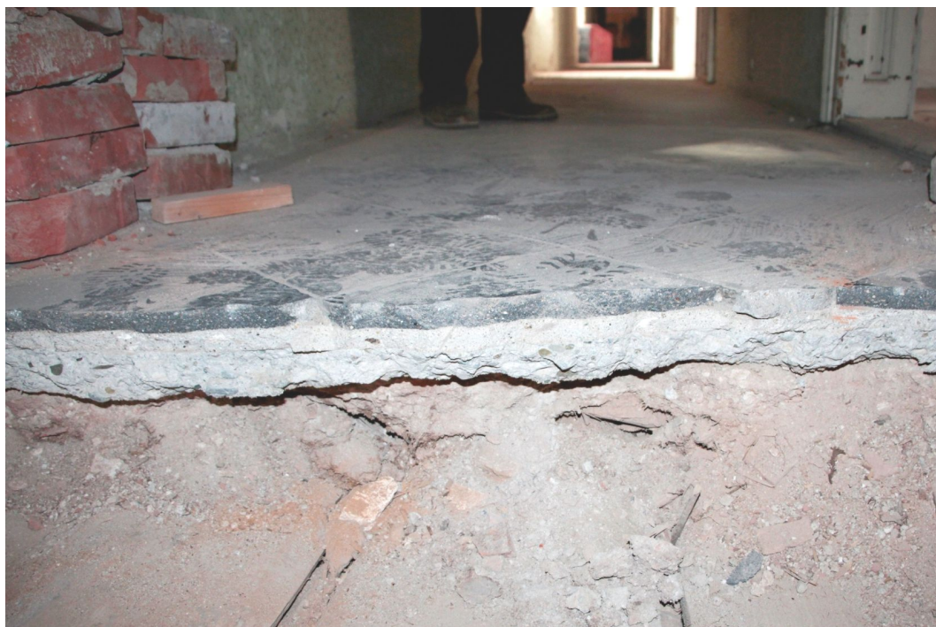
28. Detailní pohled na skladbu podlahy na chodbě s mimořádně tvrdou vrstvou podkladního betonu pod cementovou dlažbou.
