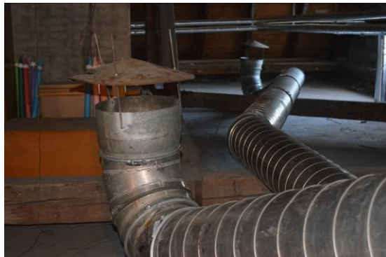
Obr. 4 Ukázka rozmístění skládaného hliníkového potrubí pro přívod horkého vzduchu
