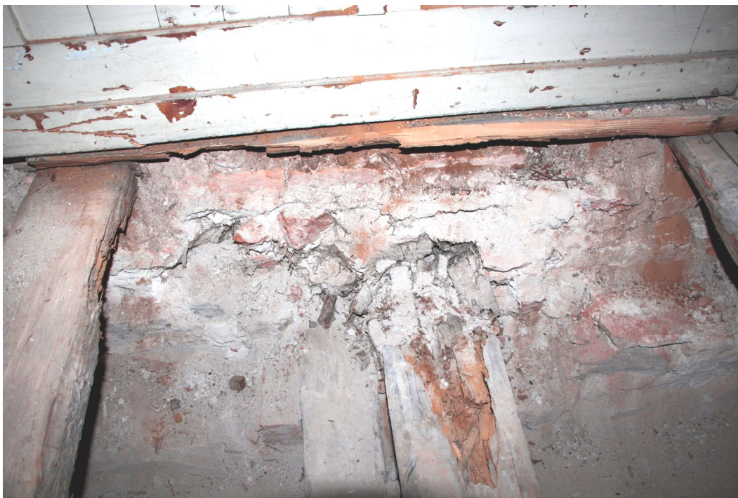
18. Detailní pohled na napadení stropního a podhledového trámu pod dřevěným obložením stěny v místnosti č. 306.
