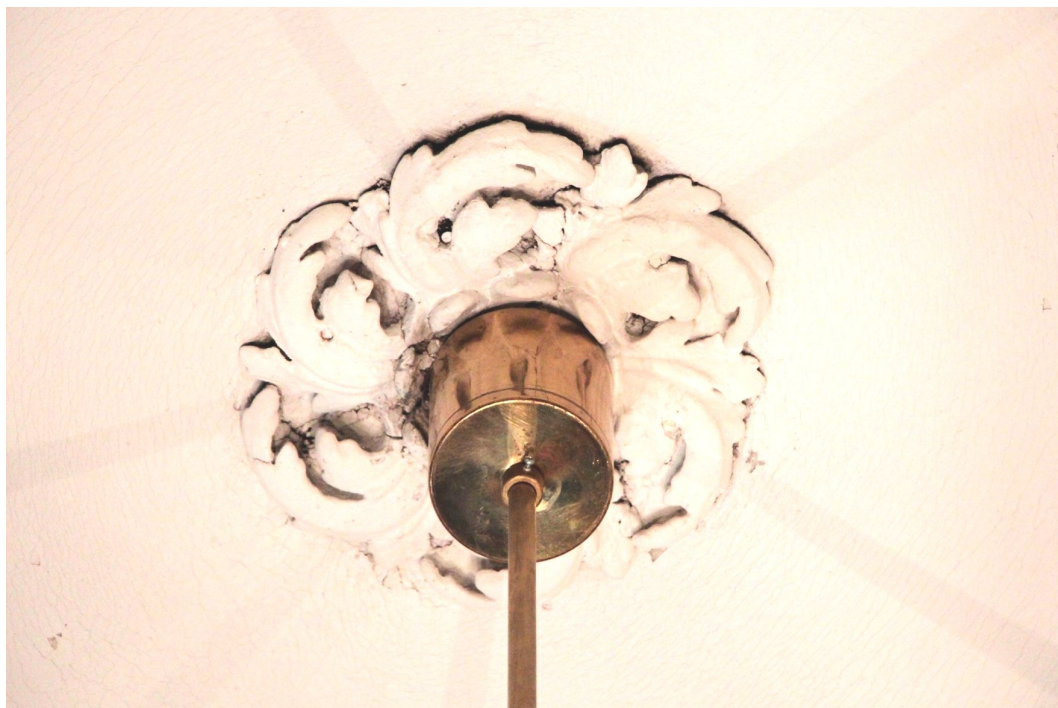
10. Detailní pohled na štukovou ozdobu kolem závěsu osvětlovacího tělesa v předsíni č. 206.
