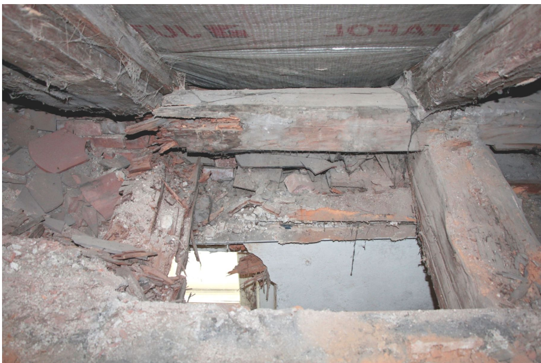
38. Celkový pohled na zničený dřevěný průvlak nad oknem v místnosti č. 304 průhledem z krovu, který vznikl propadnutím záklopu destruovaného dřevomorkou.
