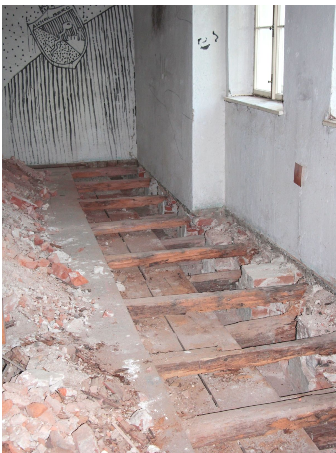
23. Celkový pohled na pásovou sondu podél vnějšího obvodového zdiva v místnosti č. 304.
