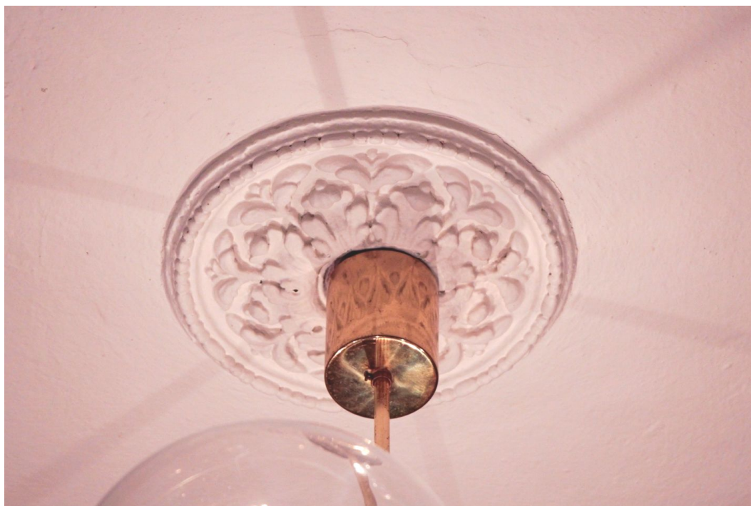
12. Detailní pohled na štukovou ozdobu kolem závěsu osvětlovacího tělesa v kuchyni č. 205.
