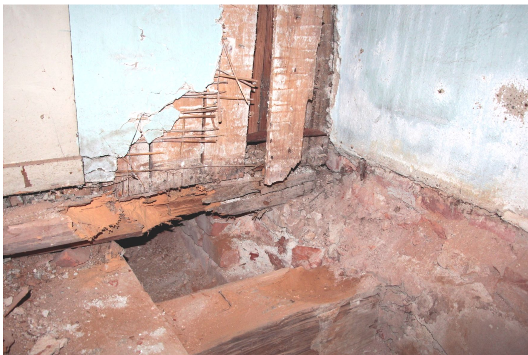
20. Detailní pohled na napadení dřevěné příčky mezi místnostmi č. 305 a 306.
