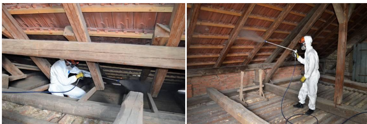
Obr. 9 Ukázka provedení preventivní chemické ochrany po ukončení horkovzdušné sanace
