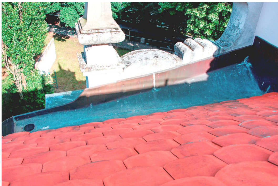
6. Detailní pohled na žlab za atikou centrálního vikýře na východním průčelí.
