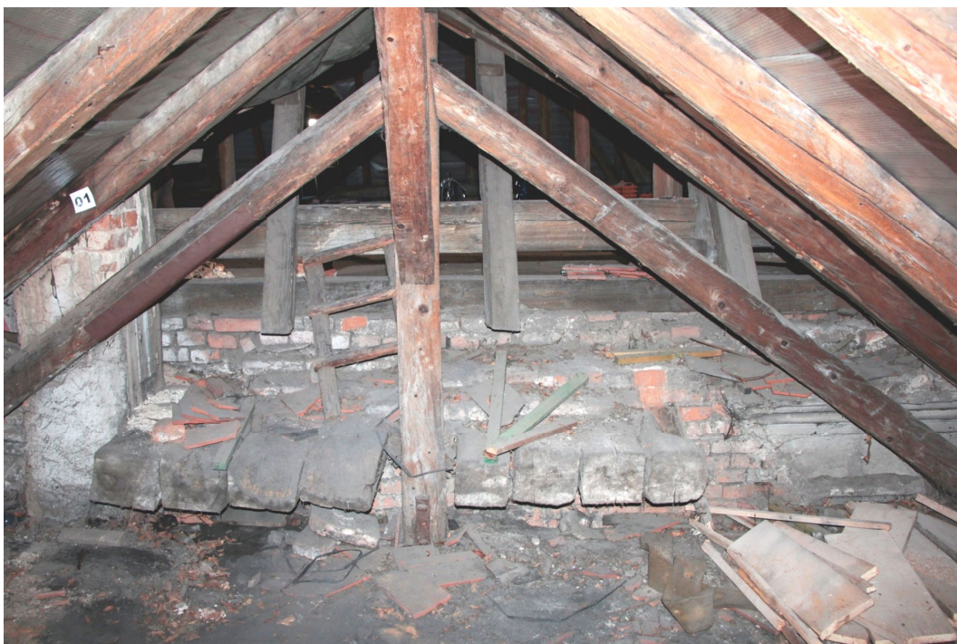
33. Celkový pohled na krajní plnou vazbu krovu u styku východního a severního křídla (jediný vstup do krovu východního křídla), dole jsou patrná čela typlového stropu přecházející ze severního křídla.
