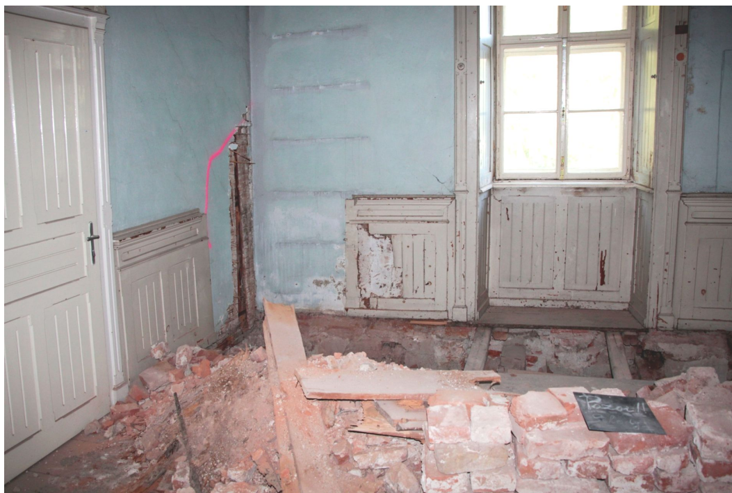
19. Pohled do severovýchodní části místnosti č. 305 s pásovou sondou do stropů a s částečně odstraněným dřevěným kazetovým obkladem na stěnách.
