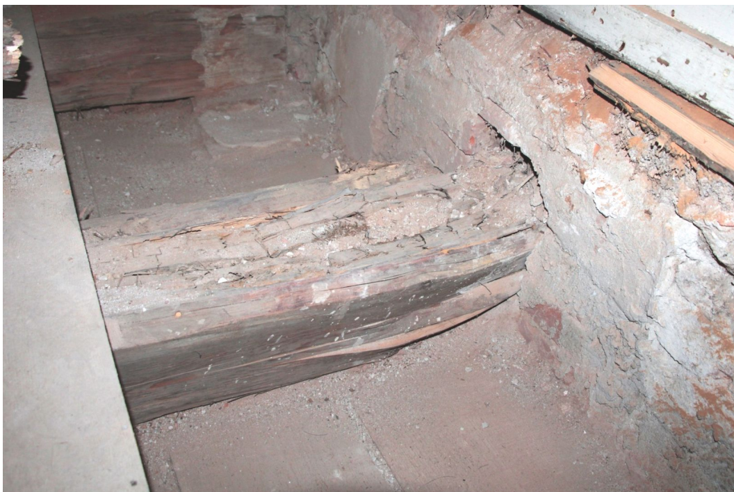
22. Detailní pohled na stropní trám napadený dřevomorkou, který se ve zhlaví propadl.
