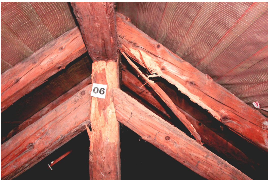
34. Detailní pohled na intenzivní napadení tesaříkem v horní části plné vazby krovu.
