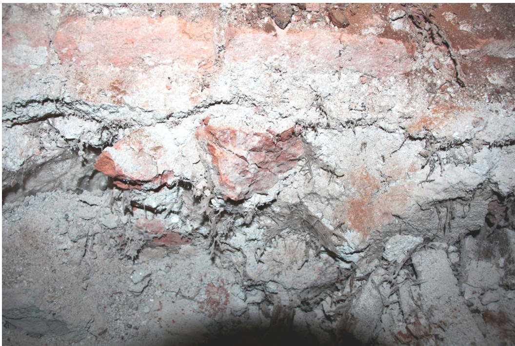
21. Detailní pohled na mycelium dřevomorky prorůstající do zdiva v místnosti č. 305.
