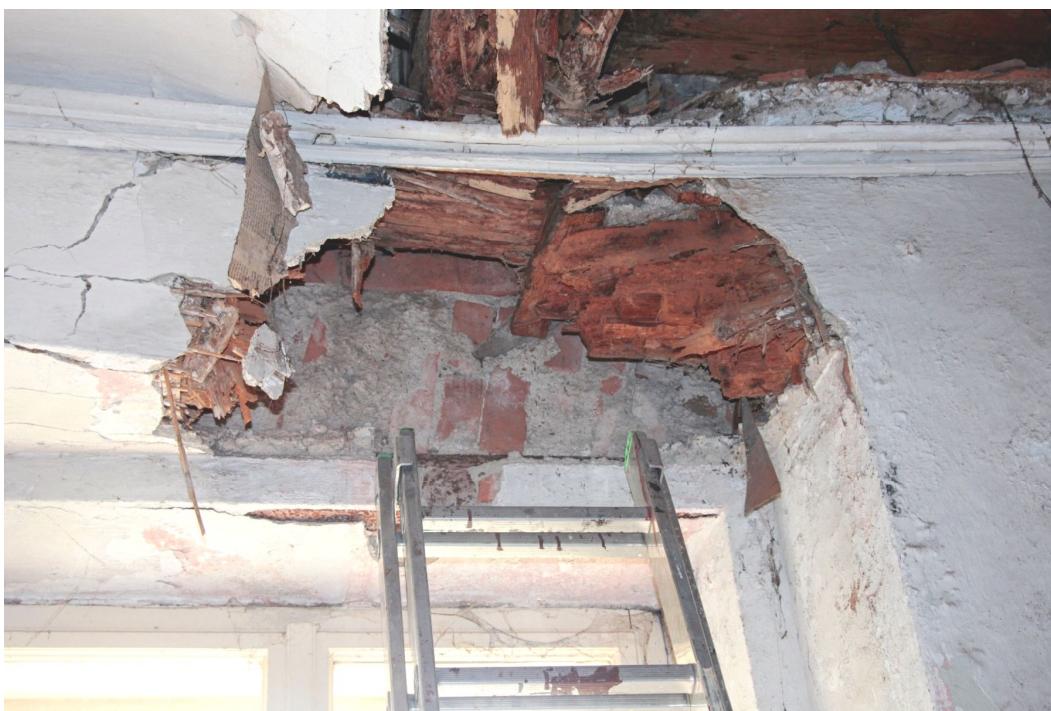
30. Pohled na průvlak ze dvou dřevěných trámů nad oknem v místnosti č. 304, zcela zničený dřevomorkou.
