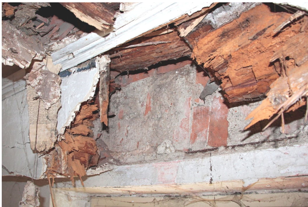
31. Detailní pohled na zcela destruovanou hmotu trámů nad oknem v místnosti č. 304.
