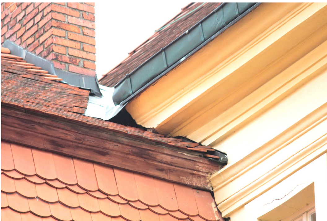
7. Detailní pohled na profilaci římsového trámu a oplechování průniku střech východního a jižního křídla.
