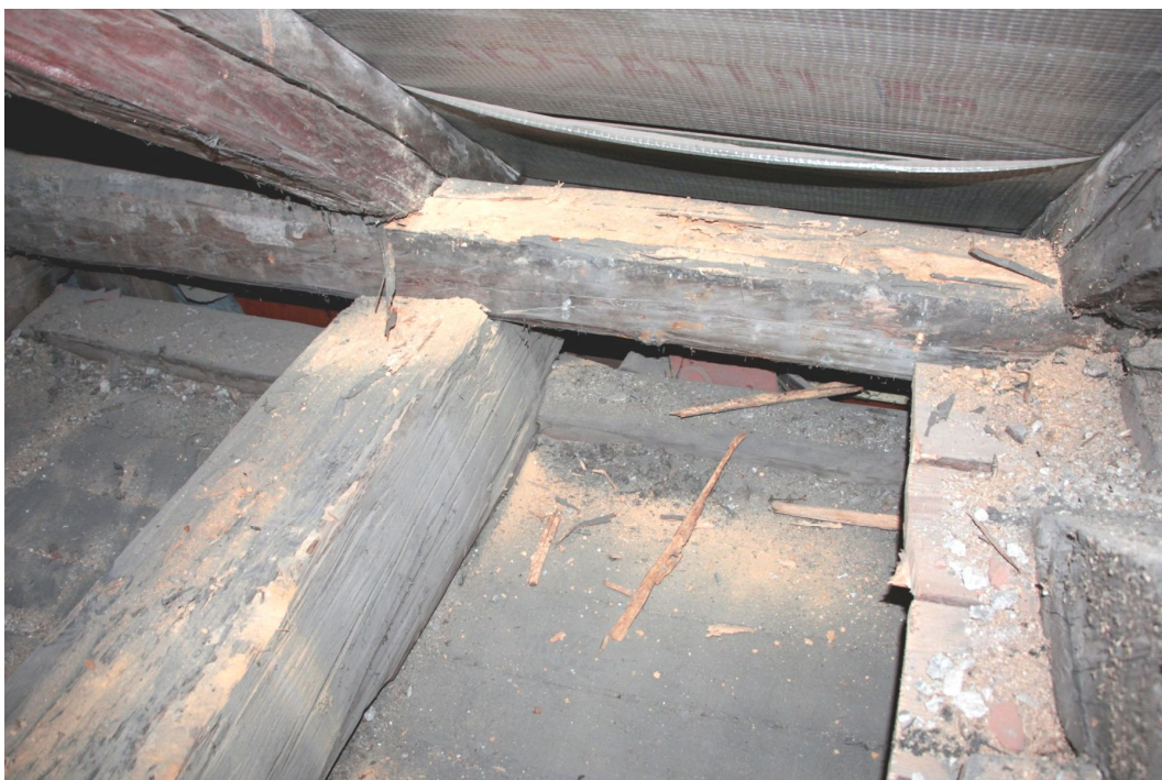
37. Detailní pohled na napadení tesaříkem trámů v lokální sondě v podlaze pod půdou.
