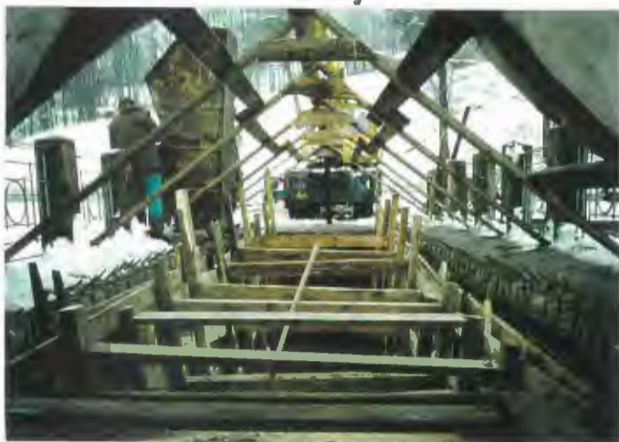
výztuž, bednění a betonáž klenby a boků mostu
