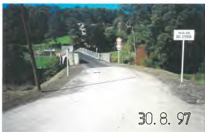
válcování obrusné vrstvy osvahováno a krajnice
