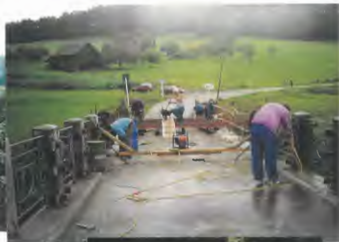
bednění a beton říms
