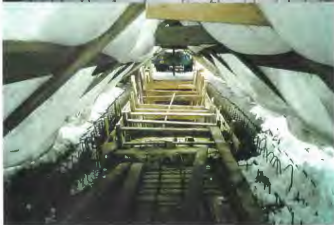
výztuž, bednění a betonáž klenby a boků mostu
