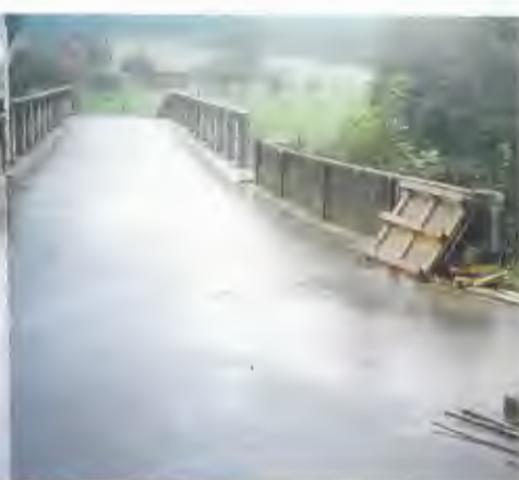
DOLNÍ SÝTOVÁ výšková úprava předmostí zábradelních zídek
