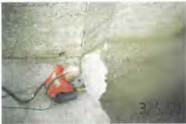
otryskání rubu betonových částí mostovky
