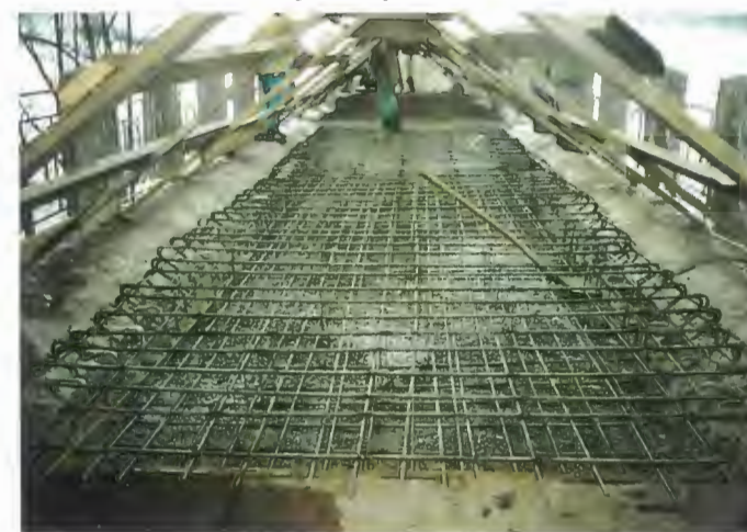
zmonolitňující trny, armatúra a betonáž uzavírací horní desky opravovaného mostu
