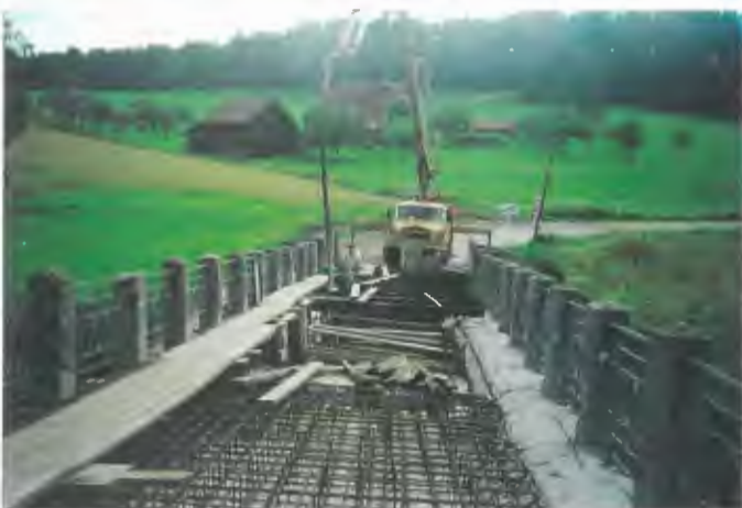
vyvážaná výztuž a betonáž spřažující desky a stěn 22. 7. 97
