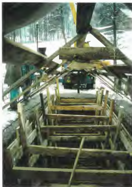
zašalované a vybetonované prsní zdi před ukrytím pod zateplovací stan
