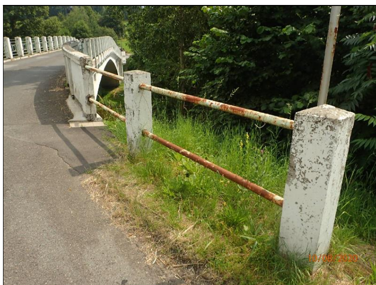
Jednoduché zábradlí navazující na L parapetní zeď za O2.
