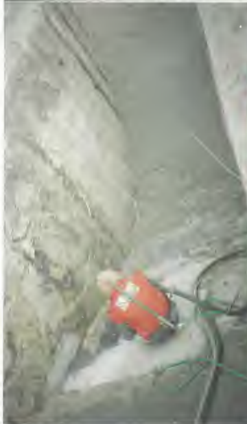
otryskání rubu betonových částí mostovky
