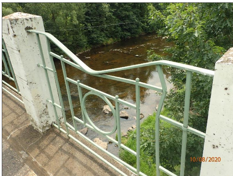
Poškození výplně L zábradlí.
