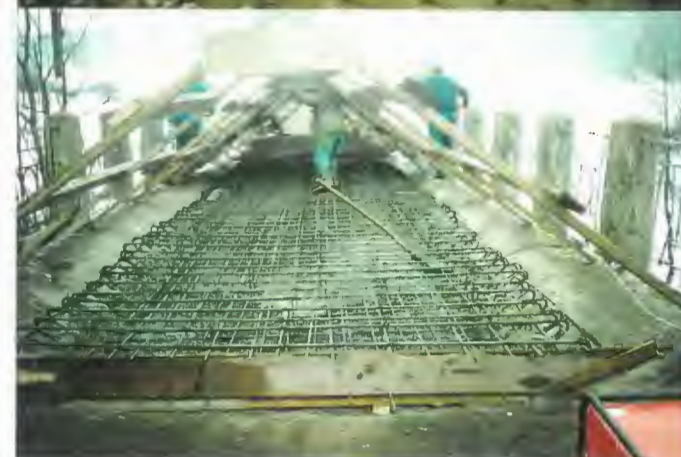
zmonolitňující trny, armatúra a betonáž uzavírací horní desky opravovaného mostu
