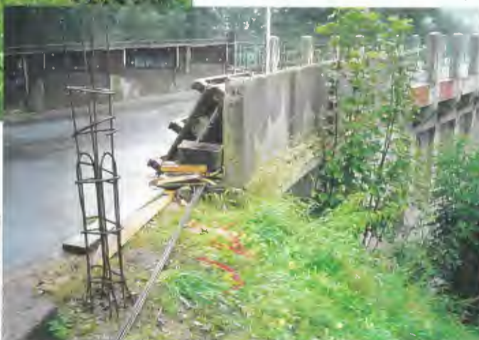
DOLNÍ SÝTOVÁ výšková úprava předmostí zábradelních zídek
