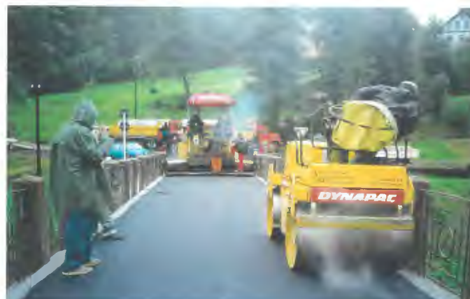
válcování obrusné vrstvy osvahováno a krajnice
