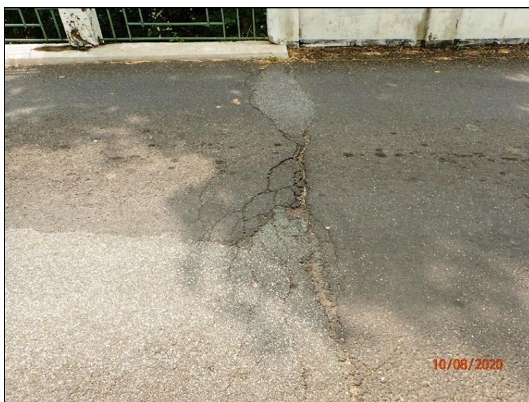
Kryt vozovky nad O2, pohled v příčné linii mezi NK a křídly.
