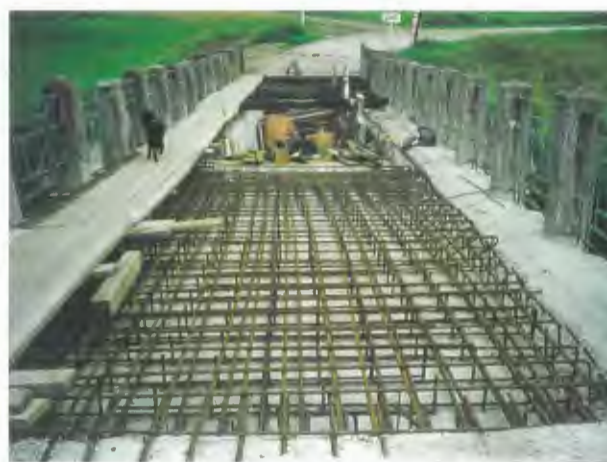
vyvážaná výztuž a betonáž spřažující desky a stěn 22. 7. 97
