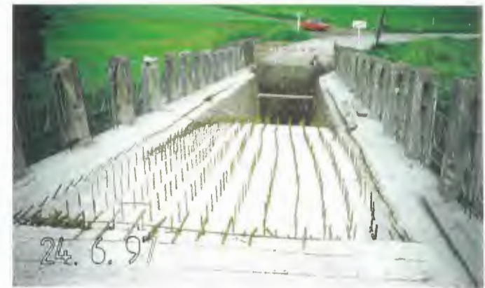
jsou vyvrtány a osazeny spřažující trny
