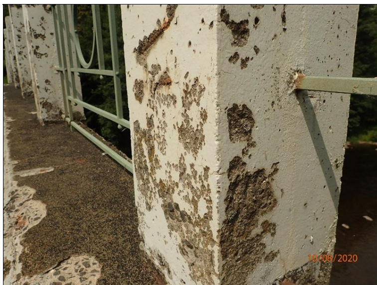
Detail poruch na plášti P zábradelního sloupku.
