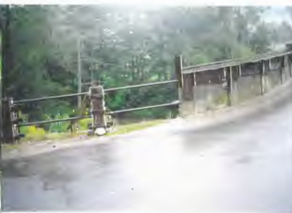
DOLNÍ SÝTOVÁ výšková úprava předmostí zábradelních zídek
