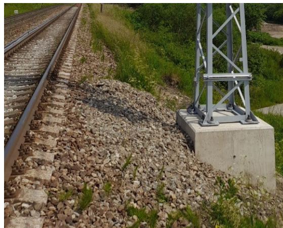
Montáž provizórneho ukoľajnenia BP stožiaru
