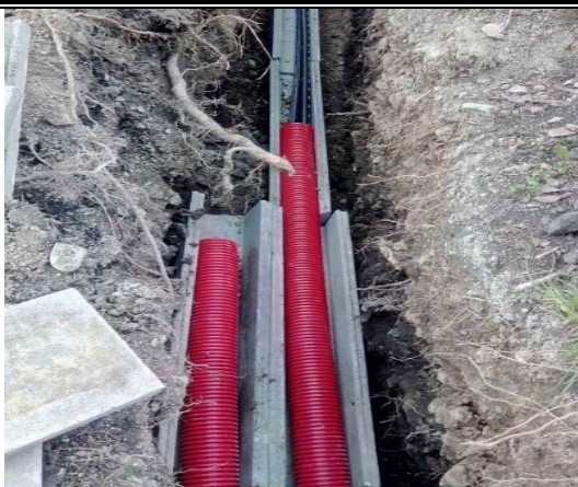
Uloženie káblových žľabov TK1 a T2N
