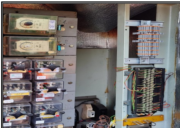
Svorkovnica pre ukončenie kábla
