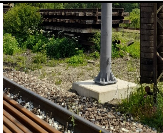
Montáž provizórneho ukoľajnenia TS stožiaru
