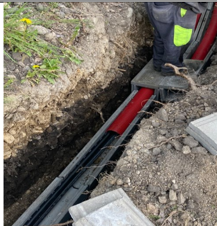
Ochrana káblov uložením v betónových žľaboch
