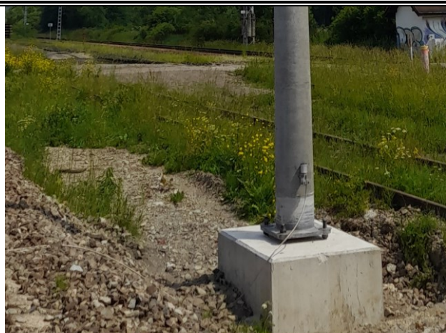
Montáž provizórneho ukoľajnenia PS stožiaru
