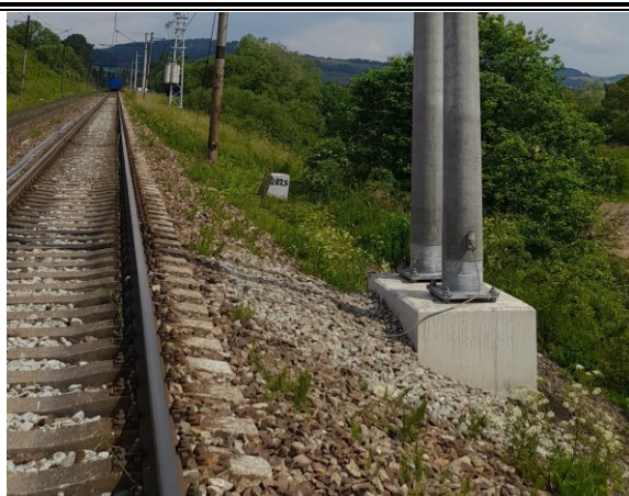
Montáž provizórneho ukoľajnenia dvojice stožiarov
