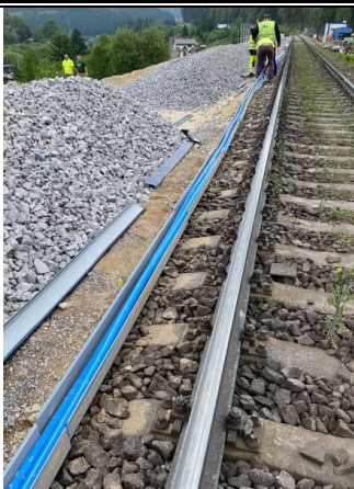
Položenie HDPE rúr do pripravenej provizórnej káblovej trasy
