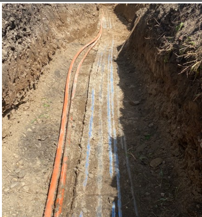
Výkop ryhy a obnaženie káblovej trasy
