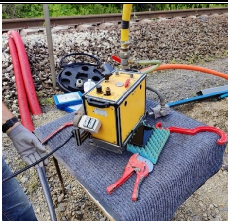
Zafuknutie optického 48 vl. kábla
