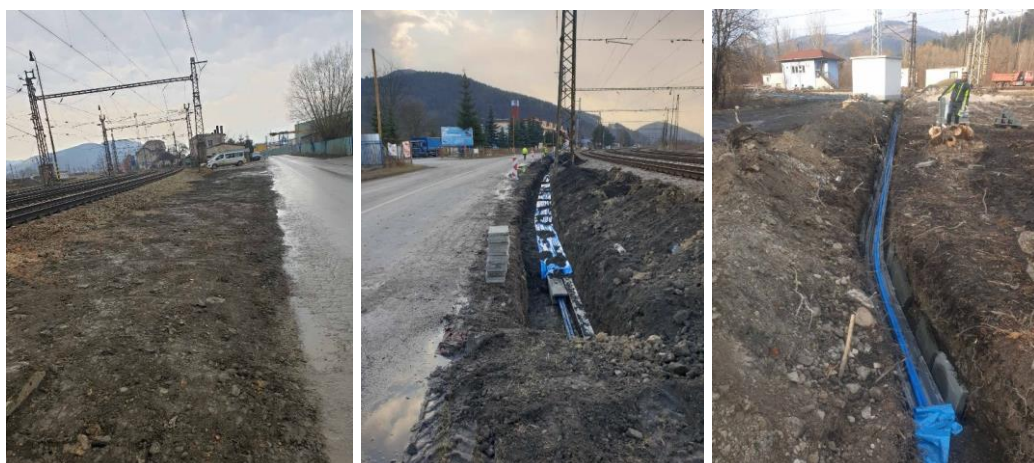
Obr. 10 53-36-03 Žilina Strážov - Váh, preložky oznamovacích káblov „MK-ŽSR“
