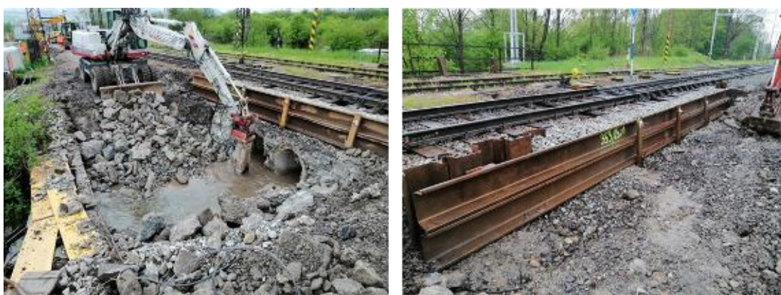
Obr. 21 55-32-09 Traťový úsek odb. a ZAST Varín (vrátane) -Strečno, rekonštrukcia priepustu, sžkm 328,816
