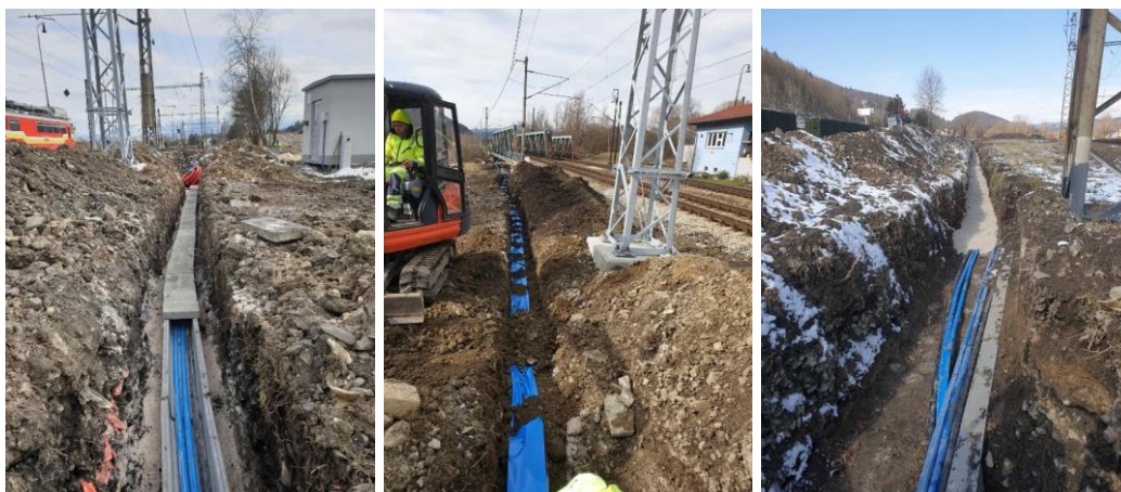
Obr. 9 53-36-02.1 - optických káblov „OK-ŽSR“ - smer Považská Bystrica
