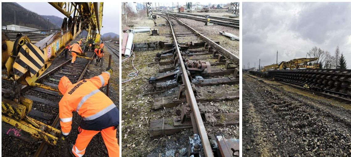
Obr. 6 53-32-09 Žilina Strážov - Žilina os. stanica, železničný zvršok - demontáž
