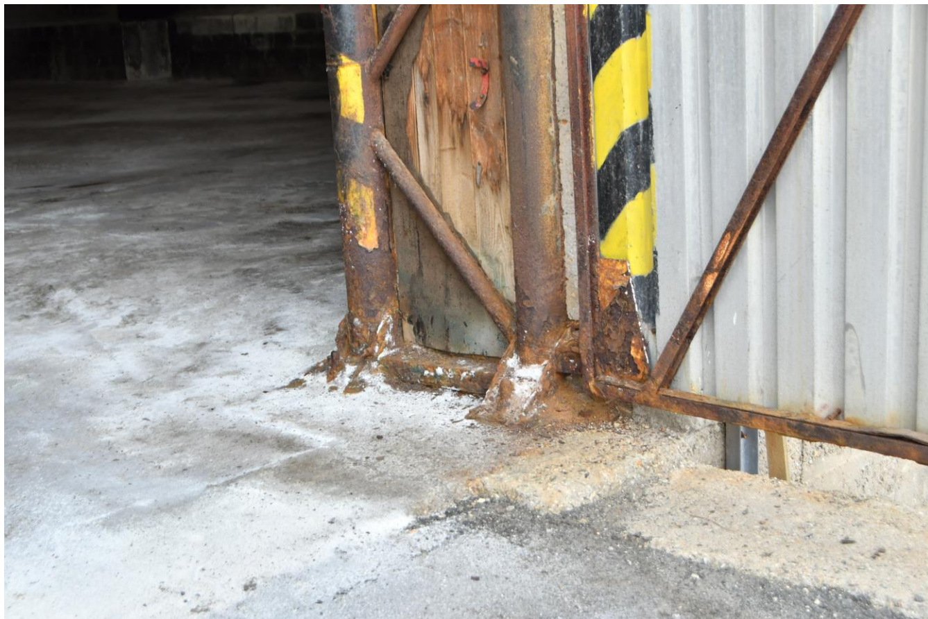
Koroze sloupů u vrat.
