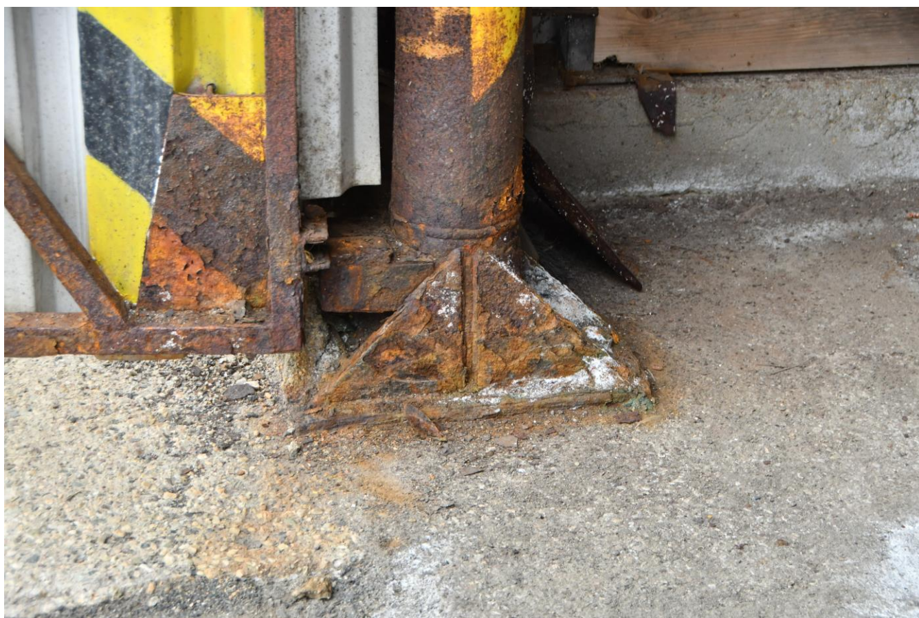
Koroze sloupů u vrat.
