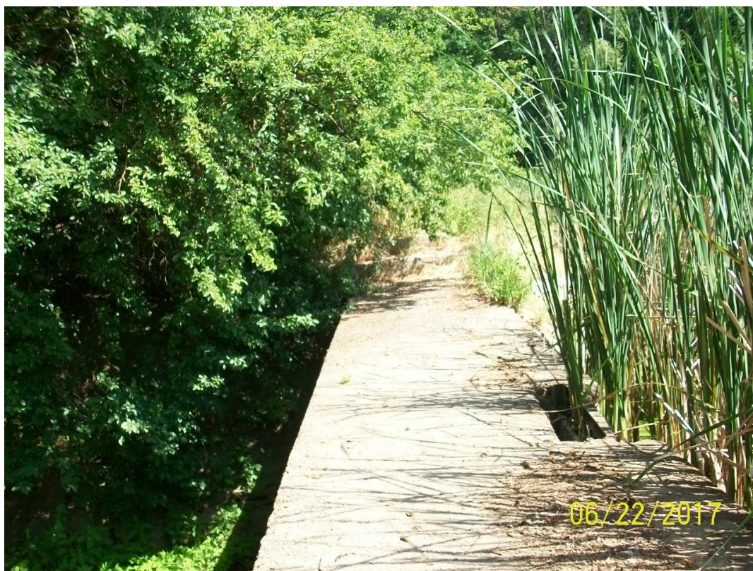
Hráz – opevnění návodní strany – foto č.6
