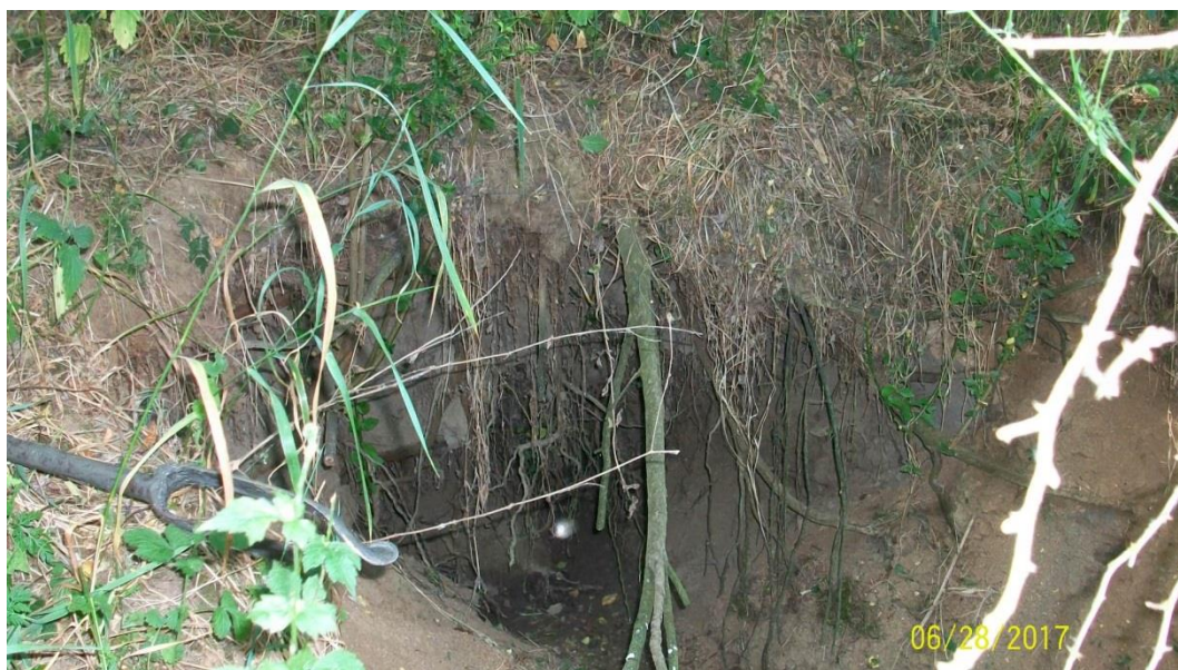
Porucha hráze. Kaverna v místě levobřežního zavázání hráze – foto č.8
