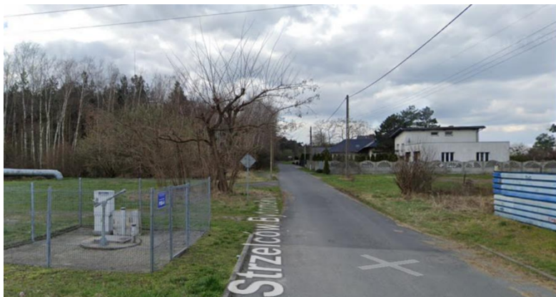
Widok ul. Strzelców Bytomskich od strony skrzyżowania z ul. Fabryczną
