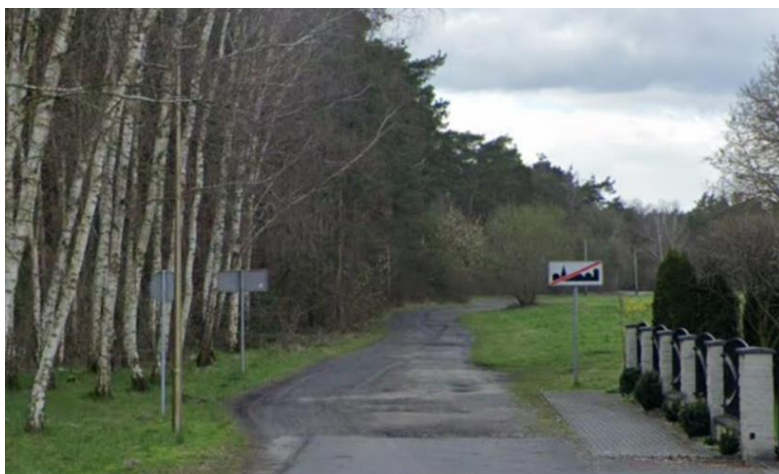
Widok ul. Strzelców Bytomskich w odległości ok. 120 m od strony skrzyżowania z ul. Fabryczną
