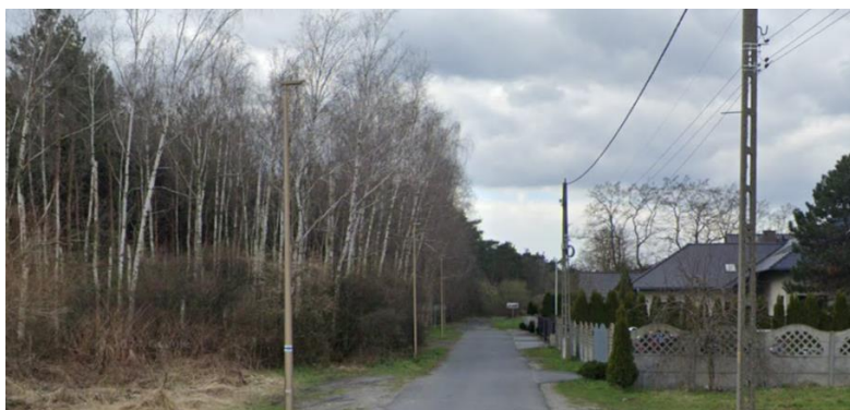
Widok ul. Strzelców Bytomskich w odległości ok. 50 m od strony skrzyżowania z ul. Fabryczną
