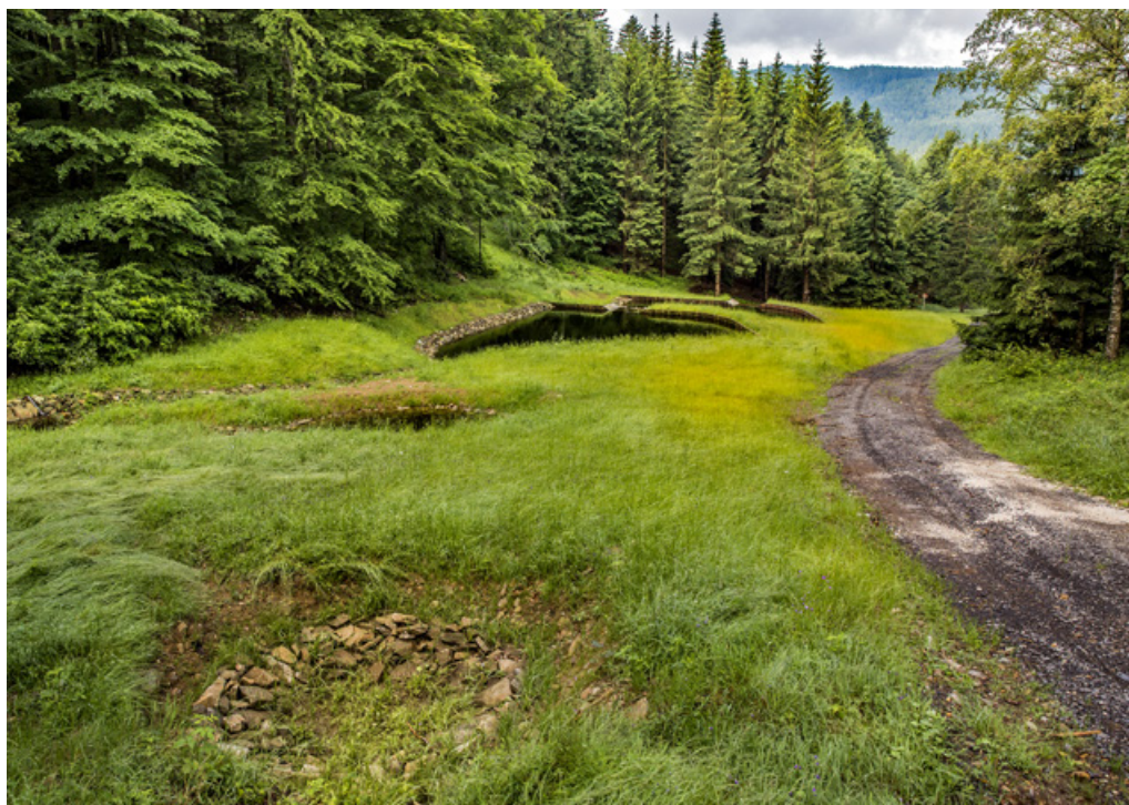
Fot. 136. Doły chłonne i kałuże przejmujące wodę odprowadzaną rowkami z drogi, Nadleśnictwo Łądek-Zdrój (archiwum CKPŚ)
