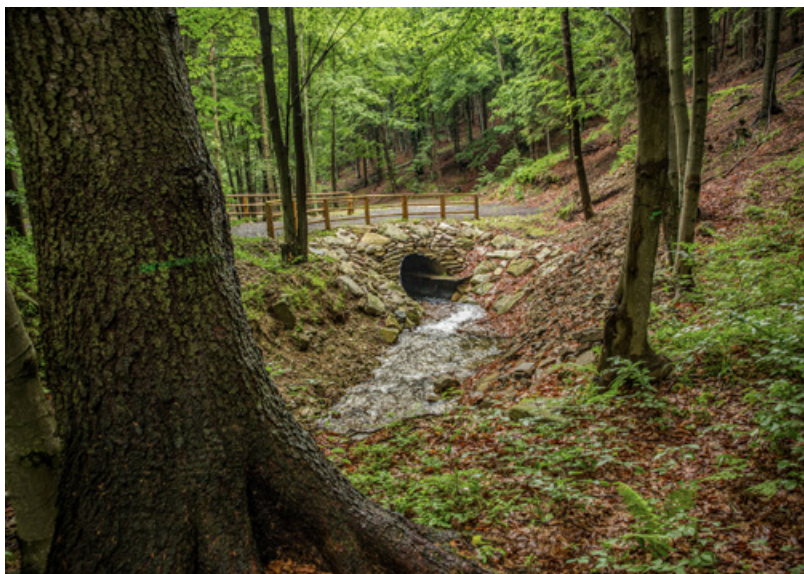
Fot. 95. Przepust ze ścieżką jednostronną w Nadleśnictwie Łądek-Zdrój, 2014 (archiwum CKPŚ)
