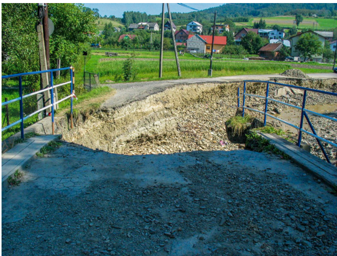
Fot. 146. Zerwany most, Targaniczanka (fot. L. Książek, 2005)
