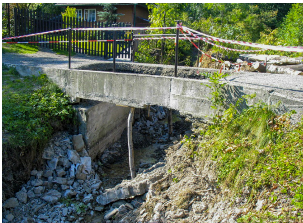
Fot. 142. Straty powodziowe w 2005 roku – uszkodzony mostek o zbyt małym świetle, Targanica (fot. L. Książek)
