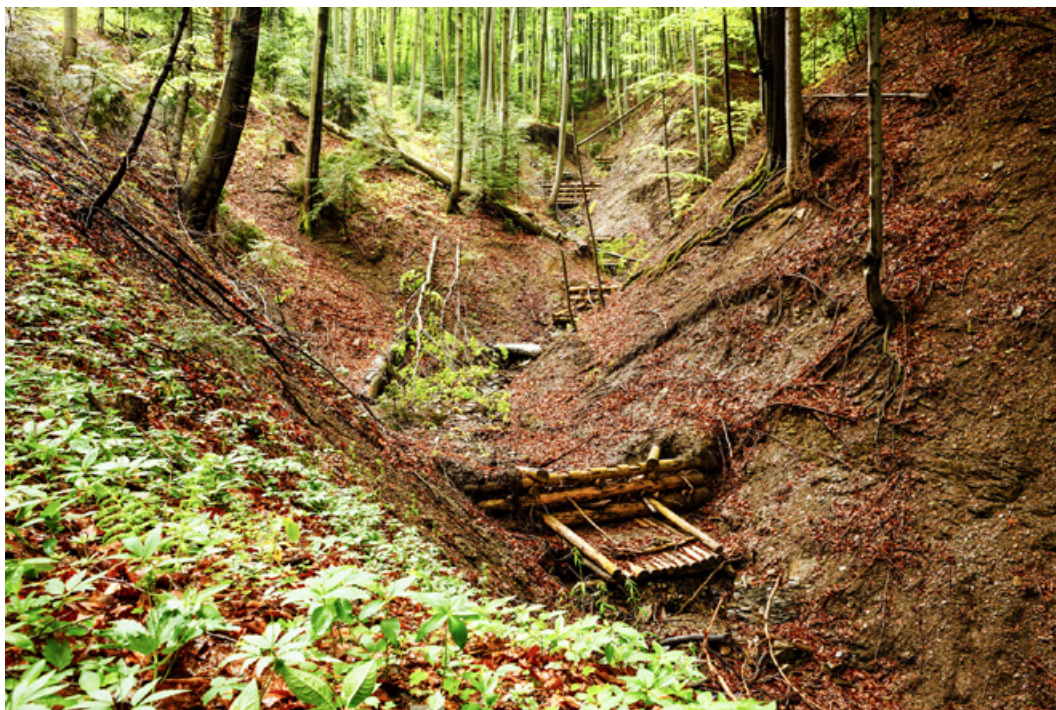
Fot. 149. Niewielkie zapory przeciwrumowiskowe rozłożone w wyerodowanym wąwozie na cieku okresowym, Nadleśnictwo Limanowa (archiwum CKPŚ)
