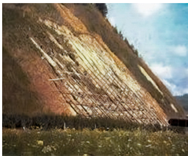
Fot. 65 i Rys. 69. Drewniane rusztowanie na skarpie wzmocnione nasadzeniami wierzbowymi [Begemann i Schiechtl 1999]
