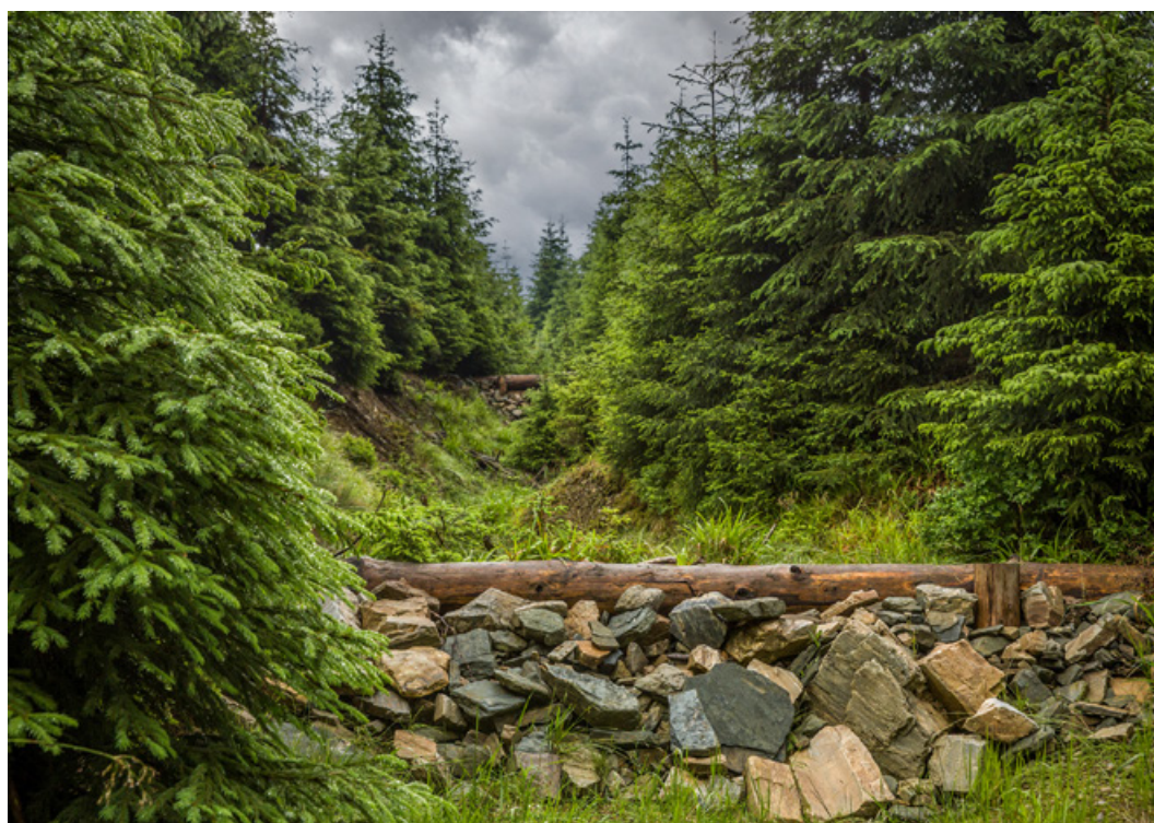
Fot. 8. Zabudowa przeciwozryjna w trasie spływów powierzchniowych, Nadleśnictwo Łądek-Zdrój (archiwum CKPŚ)
