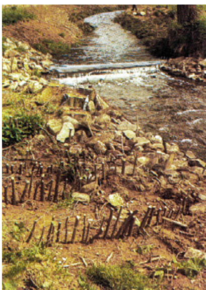
Fot. 69. Płotek ze zrzezów wierzbowych tuż po wykonaniu [Begemann i Schiechl 1999]
