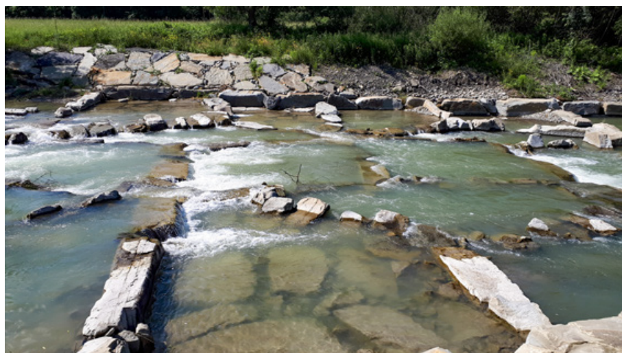
Fot. 99. Bystrze kaskadowe typu „plaster miodu”, rzeka Biała Tarnowska w rejonie miejscowości Florynka (fot. L. Książek, 2020)
