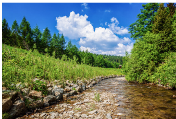
Fot. 67. Fragment umocnienia w trakcie pierwszego sezonu wegetacyjnego, potok Muczne (archiwum CKPŚ)
