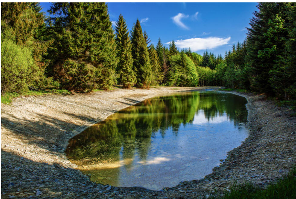
Fot. 10. Zbiornik po zakończeniu realizacji. Brzegi zbiornika posiadają niewielkie nachylenie skarp (archiwum CKPŚ)
