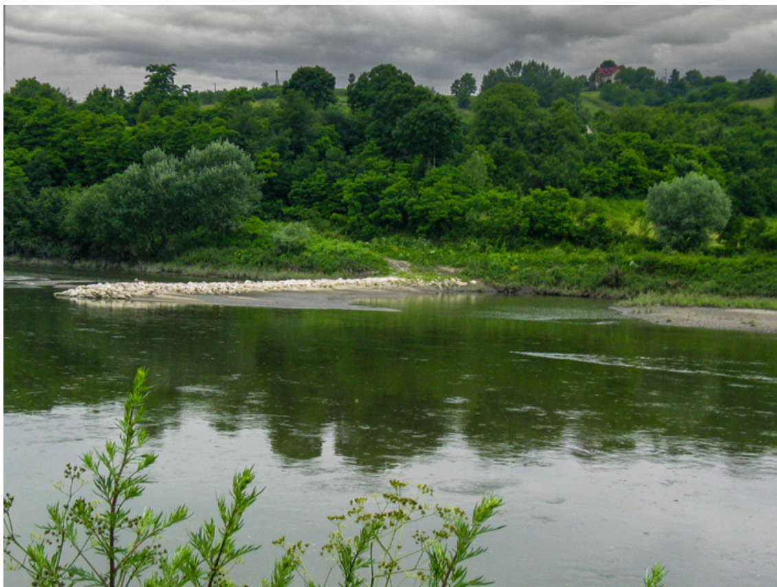
Fot. 4. Ochrona brzegów rzeki wyłącznie przez wykonanie głowic ostróg, Wisła (fot. L. Książek, 2005)
