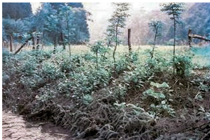
Fot. 68. Brzeg umocniony warstwą chrustu i sadzonymi wierzbowymi [Begemann i Schiechl 1999]
