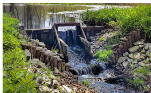
Fot. 32. Wzmocnienia wykorzystane przy budowie zastawki w Nadleśnictwie Oława (fot. K. Jata, 2023)
