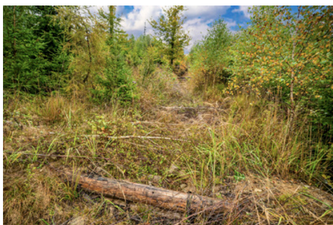
Fot. 100. Przegrody drewniane wypełnione gałęziówką na szlakach zrywkowych, Nadleśnictwo Wiśta (fot. J. Smarczewski, 2021)
