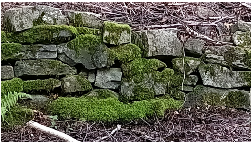
Fot. 73. Murek kamienny bez zaprawy (fot. L. Książek)
