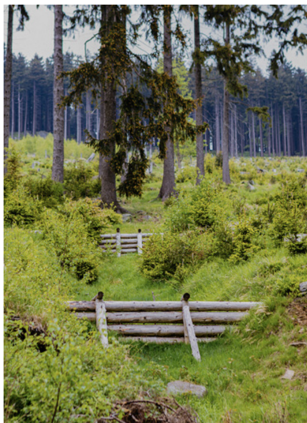
Fot. 104. Typowa zabudowa szlaków zrywkowych z wykorzystaniem belek drewnianych w Nadleśnictwie Jugów, 2015 (archiwum CKPŚ)
