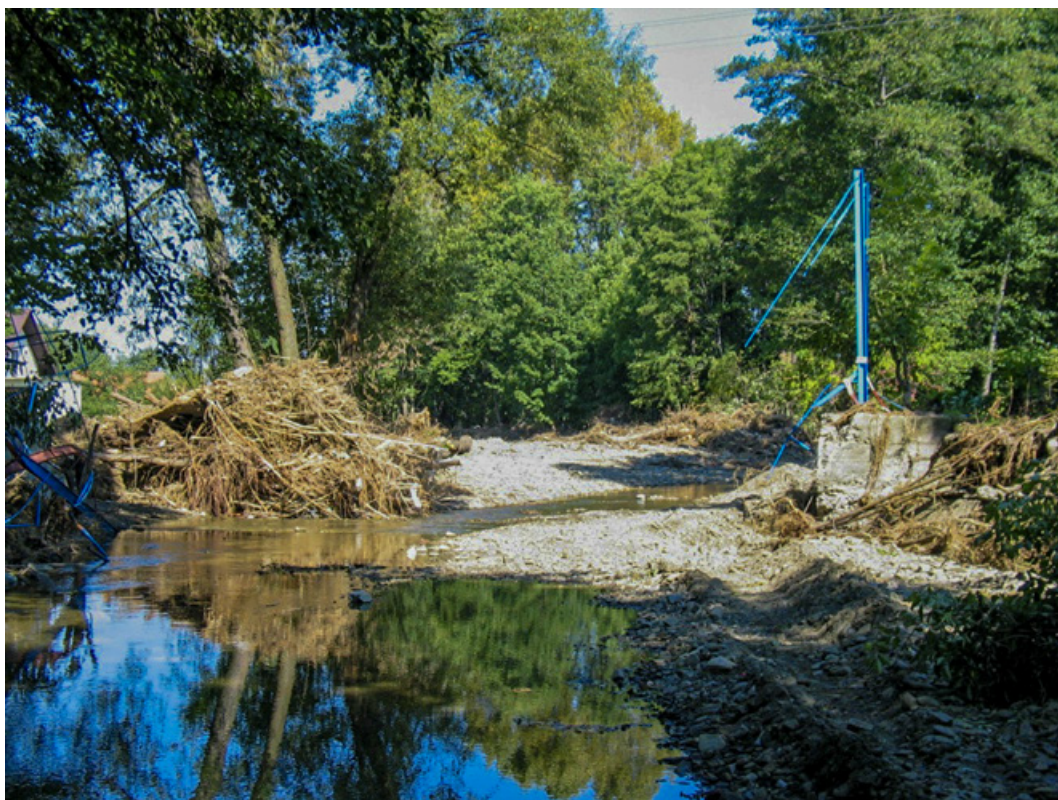
Fot. 144. Rumosz niesiony wodą w czasie katastrofального wezbrania osadzony na moście, Targaniczanka (fot. L. Książek, 2005)
