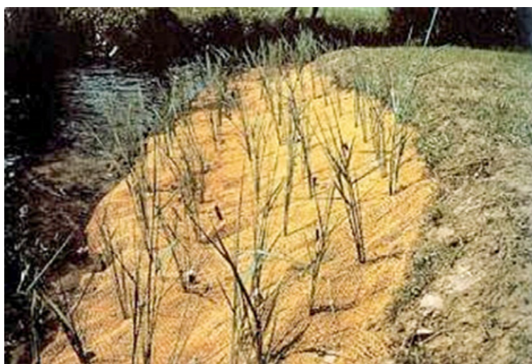
Fot. 71. Umocnienie z siatki jutowej z sitowiem i sadzonkami pędowymi [Begemann i Schiechtl 1999]
