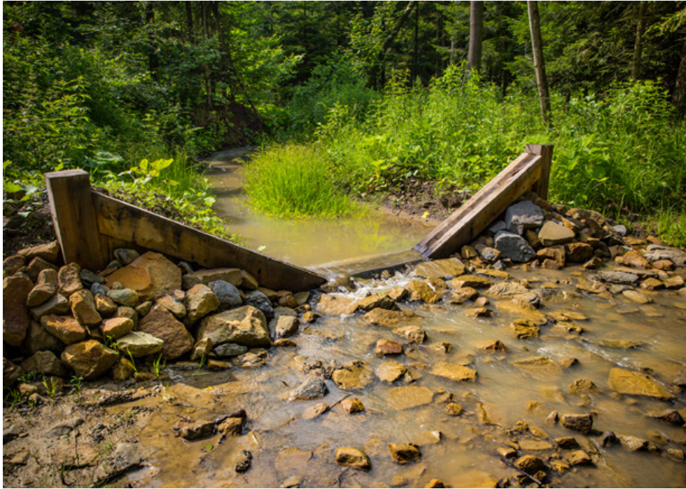
Fot. 37. Prawidłowo ubezpieczone stanowisko górne i dolne progów z pojedynczą ścianką szczelną, Nadleśnictwo Strzyżów (archiwum CKPŚ)
