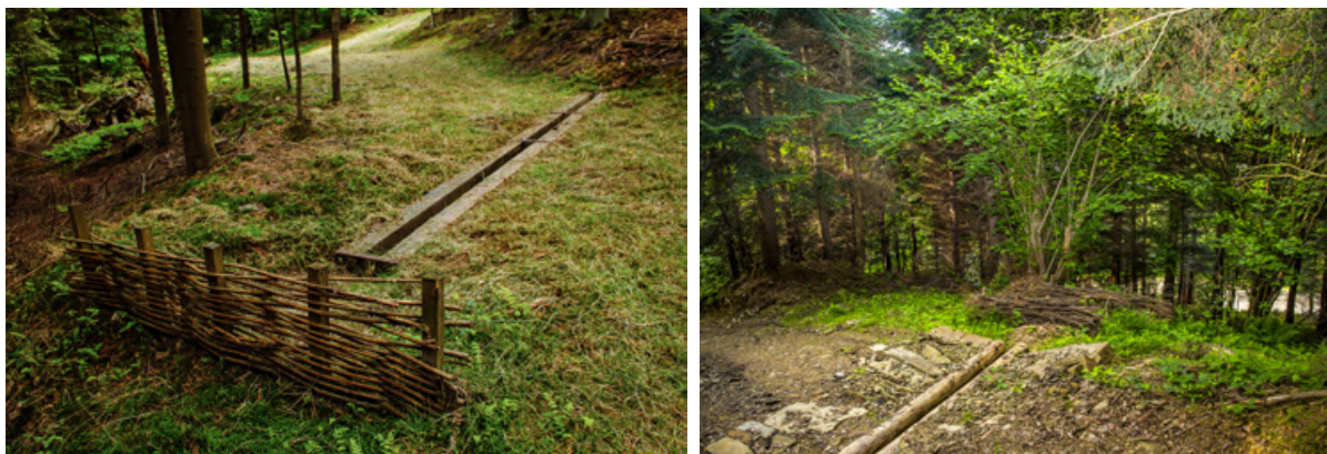
Fot. 134. i Fot. 135. Płotki faszynowe przeciwoerozyjne rozpraszające wodę na stok, Nadleśnictwo Gromnik (archiwum CKPŚ), Nadleśnictwo Łosie (archiwum CKPŚ)
