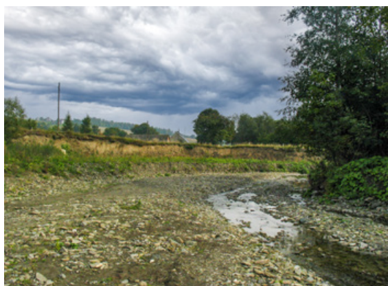
Fot. 66. Przykładowy fragment cieków przed realizacją umocnienia, Słomka (fot. L. Książek, 2005)
