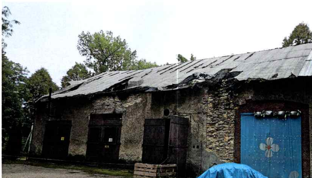
Załamania północnej połaci dachu
