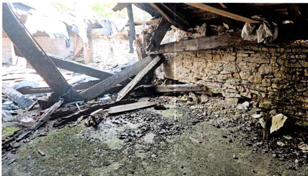
Miejsce ze zdjęcia powyżej widziane od strony strychu.
