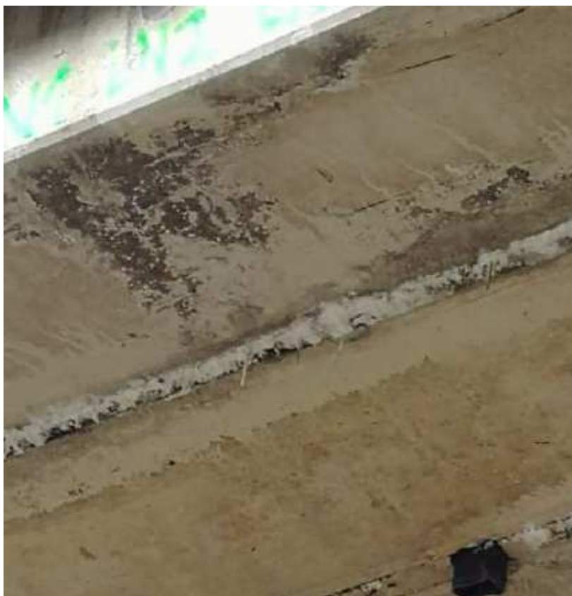
Obrázok 4 Nefunkčná hydroizolácia mostovky a výkvetý na nosníkoch KA-73
