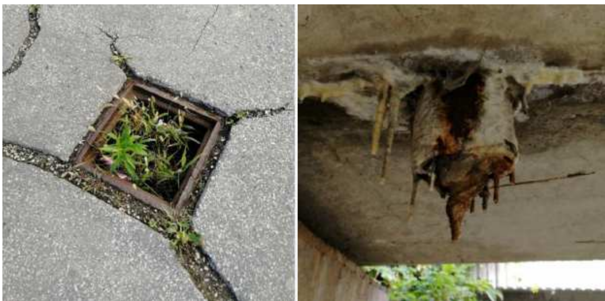
Obrázok 7 Upchaté a nefunkčné odvodňovače
