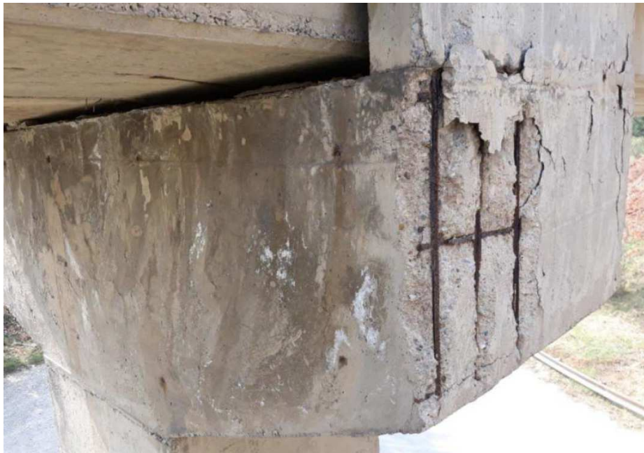
Obrázok 1 Zdegradovaný betónový povrch a obnaženie betonárskej výstuže na pilieroch
