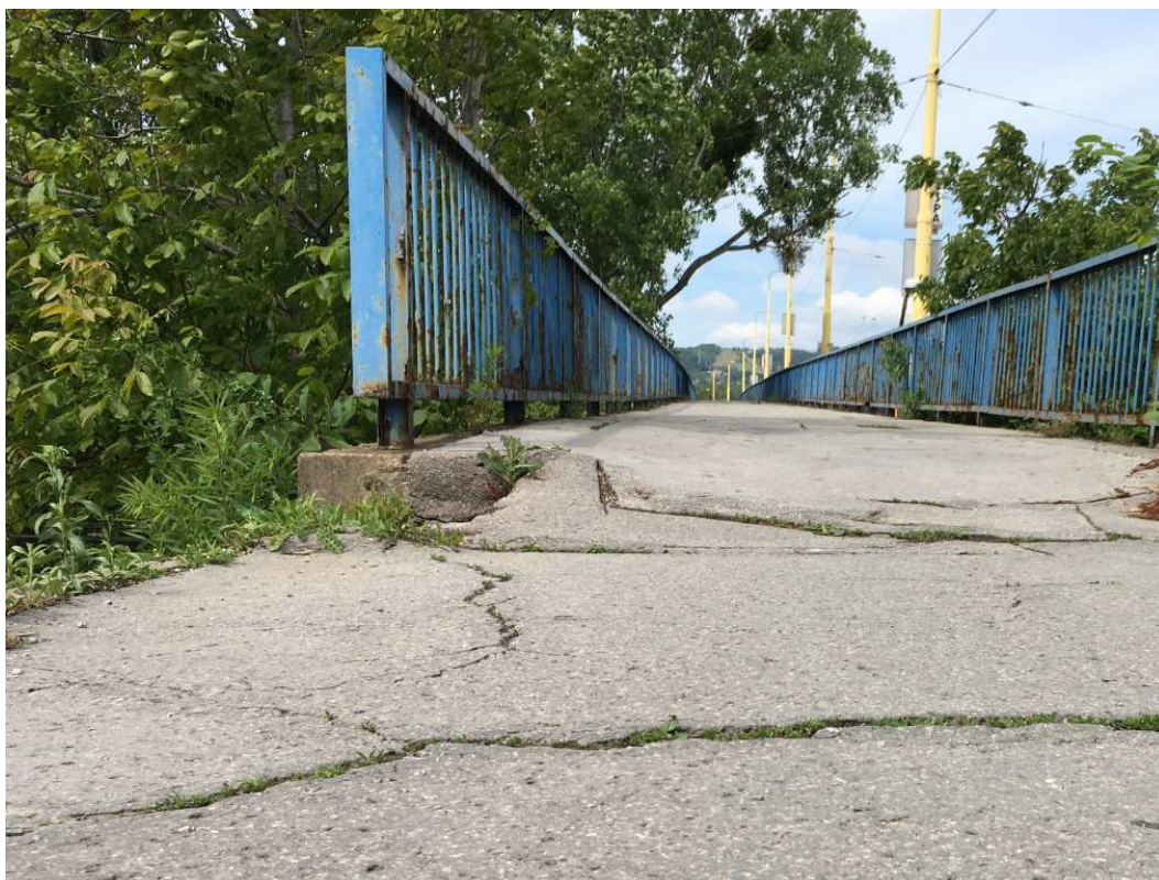
Obrázok 6 Popraskaná a zdeformovaná vozovka, zdeformovaná prechodová oblasť pri opore č. 1
