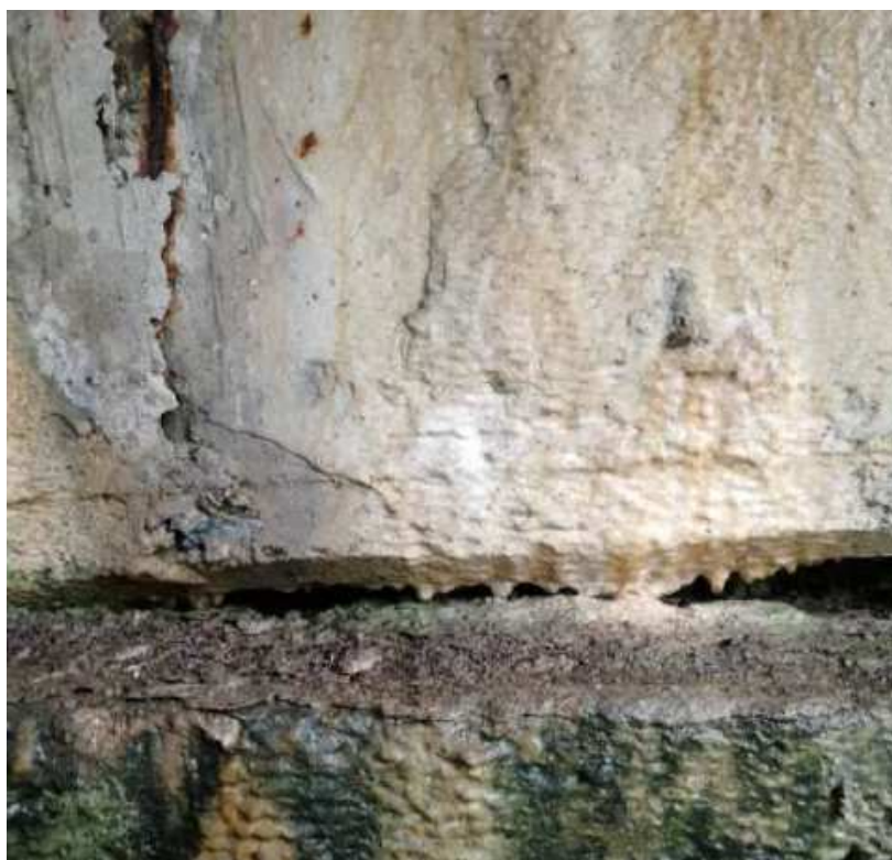
Obrázok 3 Nefunkčná vodotesnosť mostných záverov
