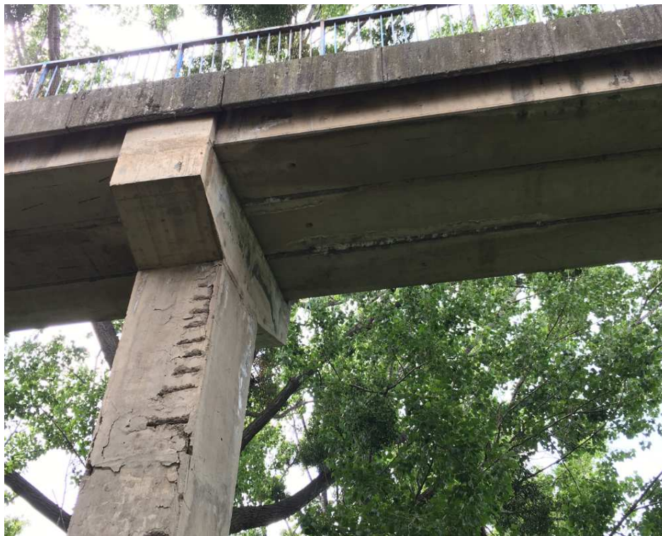
Obrázok 2 Obnaženie betonárskej výstuže na pilieroch a výkvetý na nosníkoch KA-73
