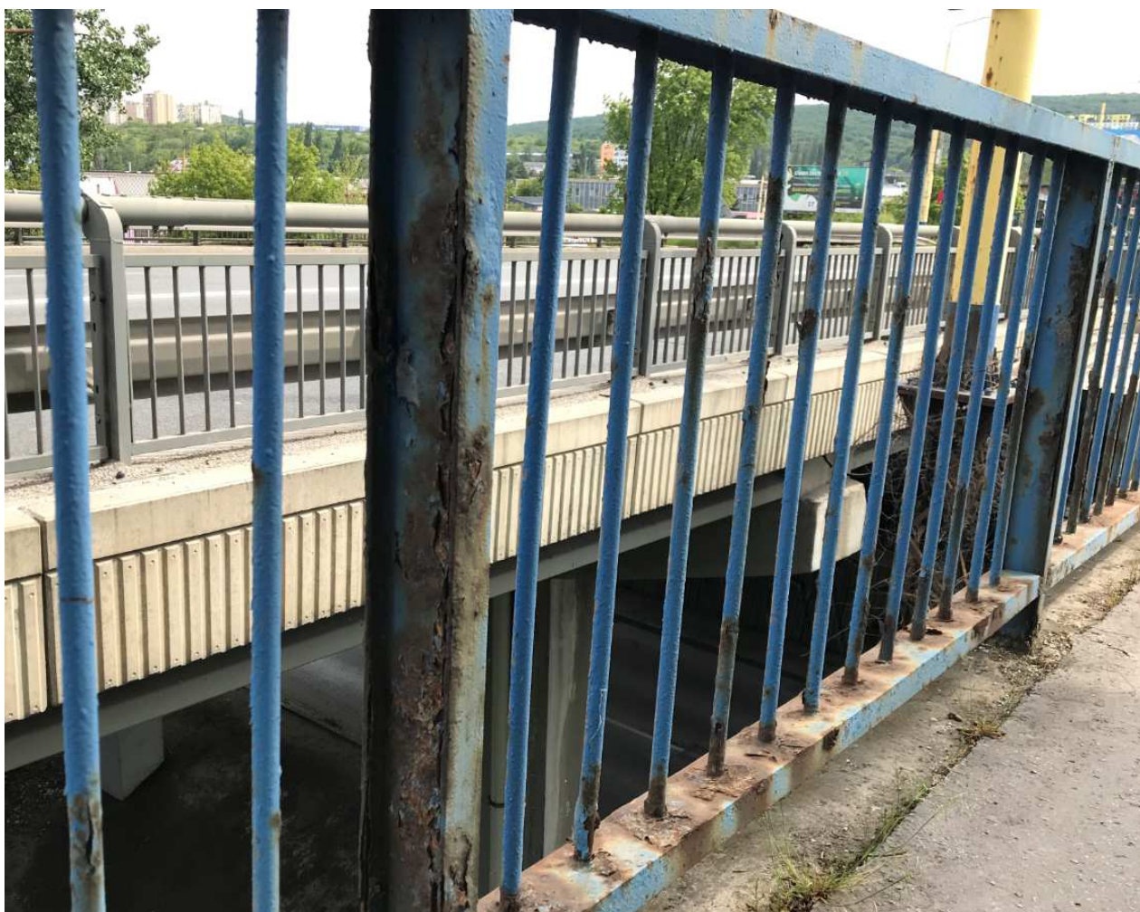
Obrázok 8 Korózia na prvkoch zábradlia a protidotykových zábran
