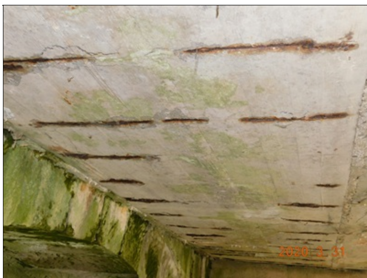
Plošně prokreslená korodující výztuž na spodním líci nosné konstrukce nosníků ŽMP, stopy po zatékání.
