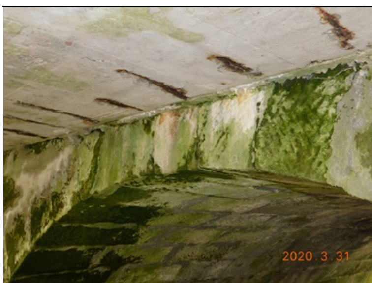
Plošně prokreslená korodující výztuž na spodním líci nosné konstrukce nosníků ŽMP, stopy po zatékání.
