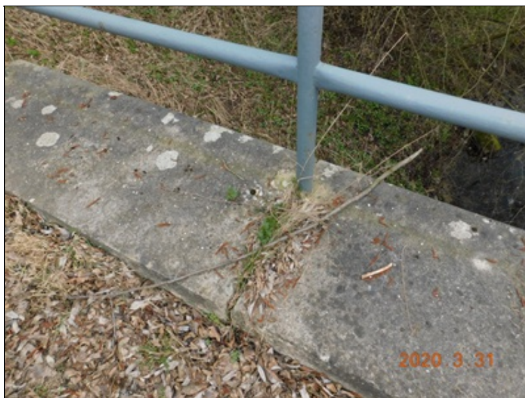
Příčná trhlina v římse, uchycená vegetace.
