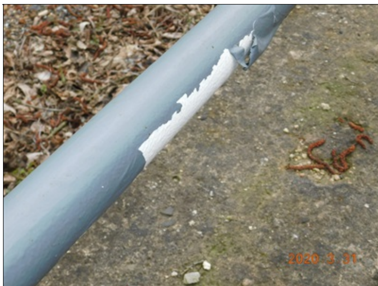
Poškozená protikoroziční ochrana.
