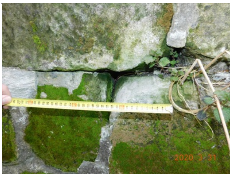
Hloubková degradace spárování křídla.
