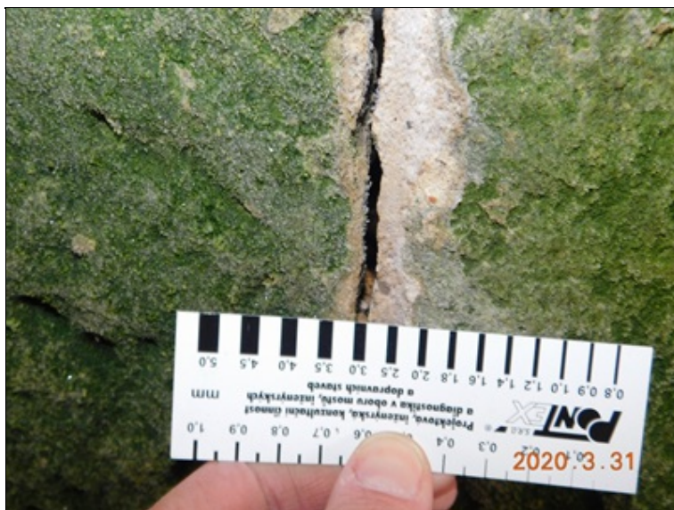
Detail šířky podélné trhliny v klenbě šířky 3,0 mm.
