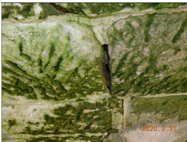
Podélná trhlina v klenbě na pravé straně nosné konstrukce.
