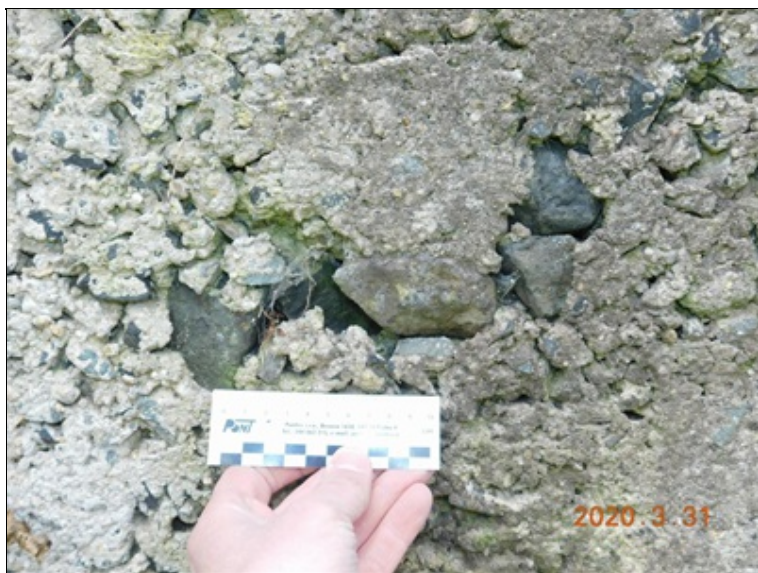
Nekvalitní beton křídel na levé straně.
