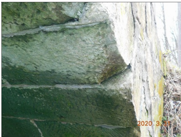
Uražená hrana kamene, chybějící spárování.
