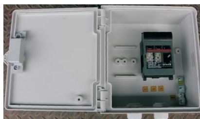
Prípojková skriňa s poistkovým odpínačom 000
