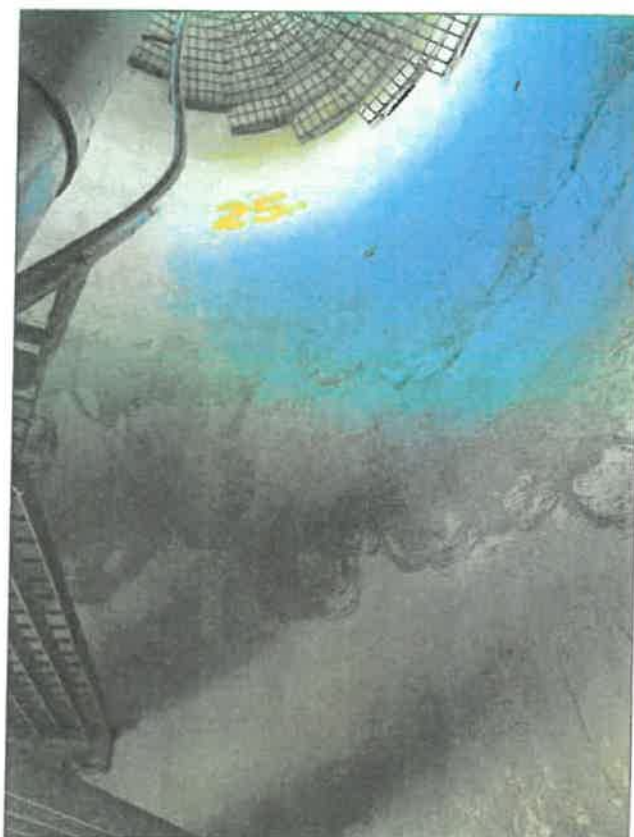
Fot. 22 Powierzchnia wewnętrzna wieży H=22m+25m
