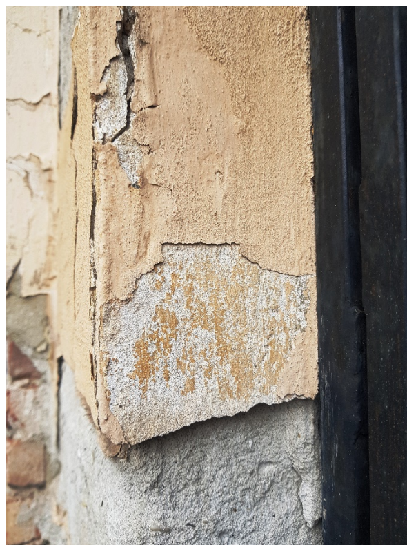
Súčasný havarijný stav, narušené omietkové vrstvy, deštrukcia materiálu,
