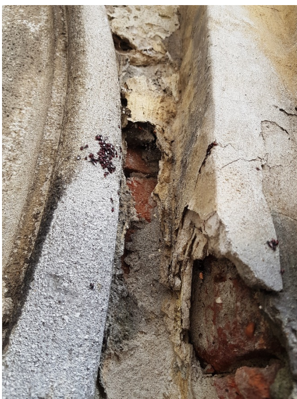
Súčasný havarijný stav, narušené omietkové vrstvy, deštrukcia materiálu,
