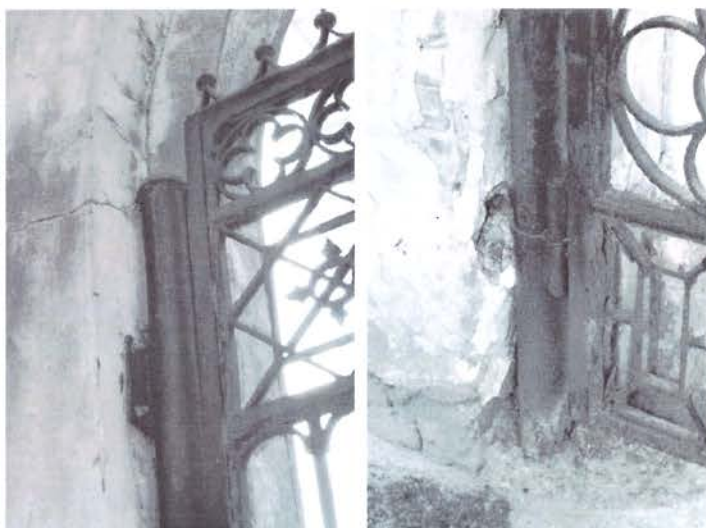
obr.16 – 17 detaily novodobého kotvenia mreže brány do murovaného ostenia
