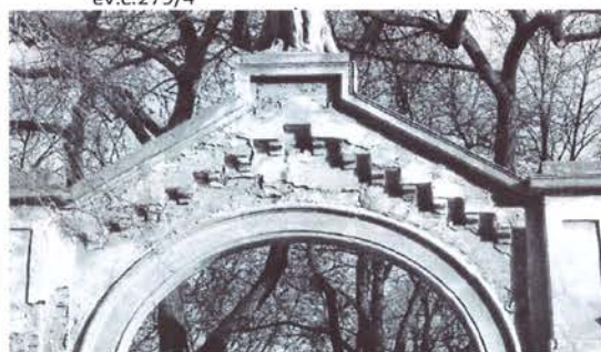
obr.05 – 06 porušená omietka pod nevhodným náterom
