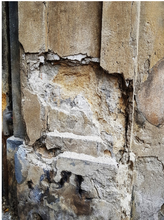
Súčasný havarijný stav, narušené omietkové vrstvy, deštrukcia materiálu,
