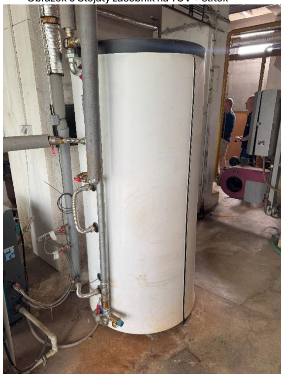
Obrázok 6 Stojatý zásobník na TÚV + štítok
