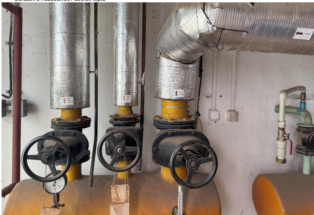
Obrázok 8 Rozdeľovač / zberač tepla
