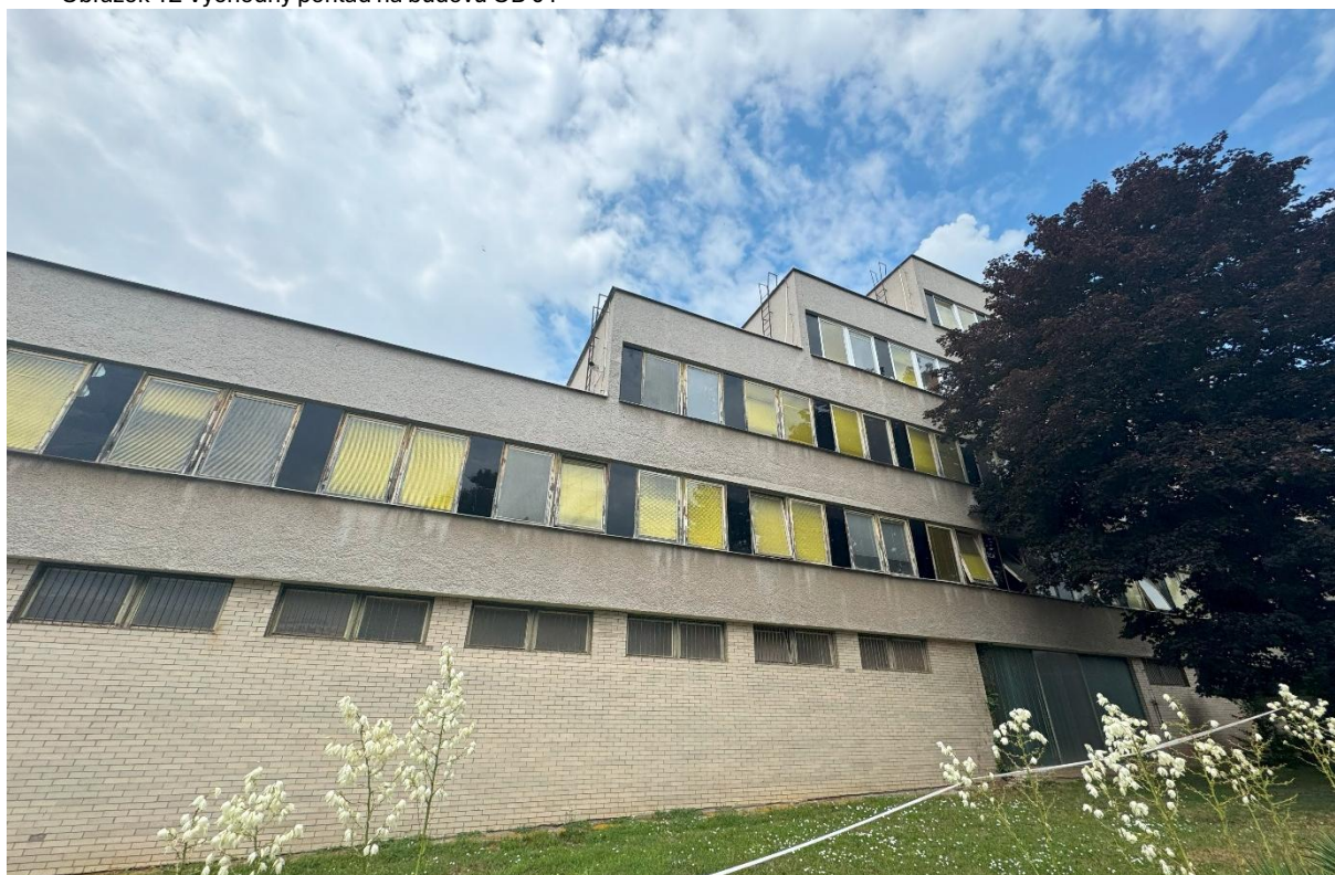
Obrázok 12 Východný pohľad na budovu OB 01
