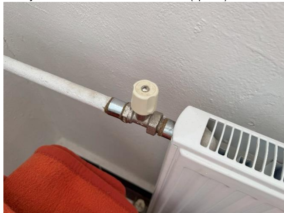
Obrázok 9 Plechový radiátor bez regulácie (vľavo), doskový oceľový radiátor s ventilom otvor / zatvor (vpravo)
