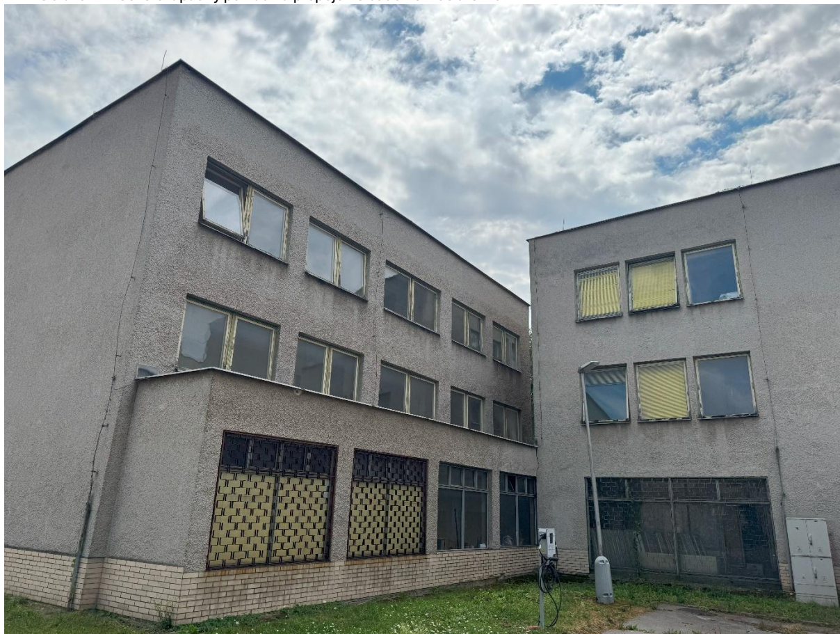
Obrázok 11 Severozápadný pohľad na prepojenie budov OB 03 a OB 04
