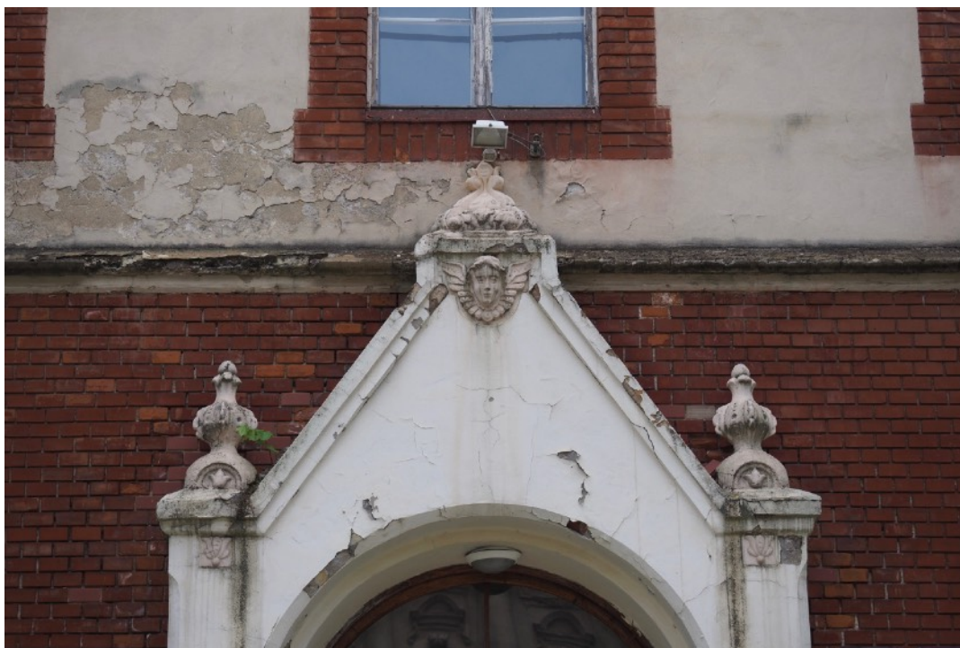
Foto č. 64: Pohľad zo S, stredný hlavný rizalit, centrálna časť, 1.NP, vstupný portál, detail poškodenia.
