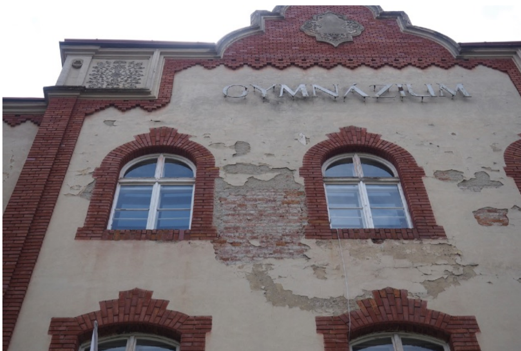
Foto č. 57: Pohľad zo S, stredný hlavný rizalit, centrálna časť, 2.NP, atikový štít, detail poškodenia.
