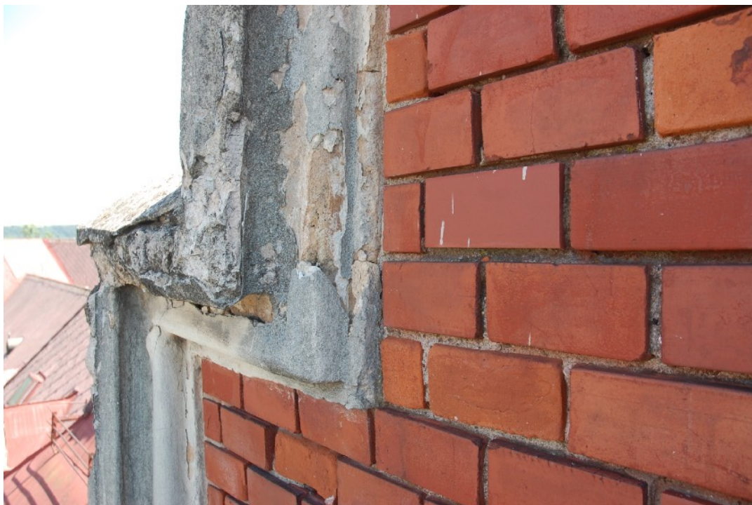
Foto č. 153: Atikový štít, aktuálny stav, detail poškodenia.
