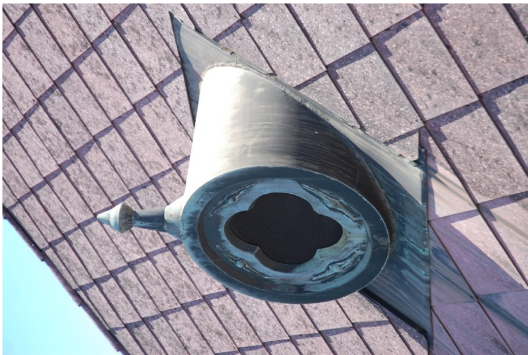
Foto č. 140: Detail zdobného otvoru strechy, tepaný prvok z medeného plechu, strešná krytina je eternit.
