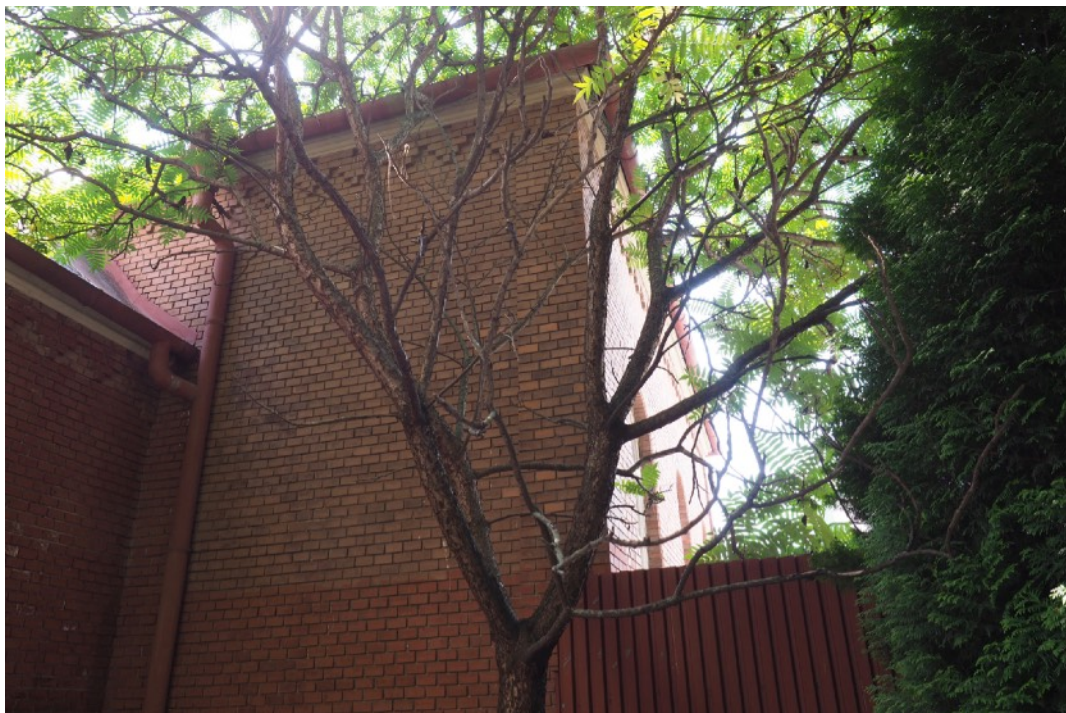
Stav pred reštaurovaním.
