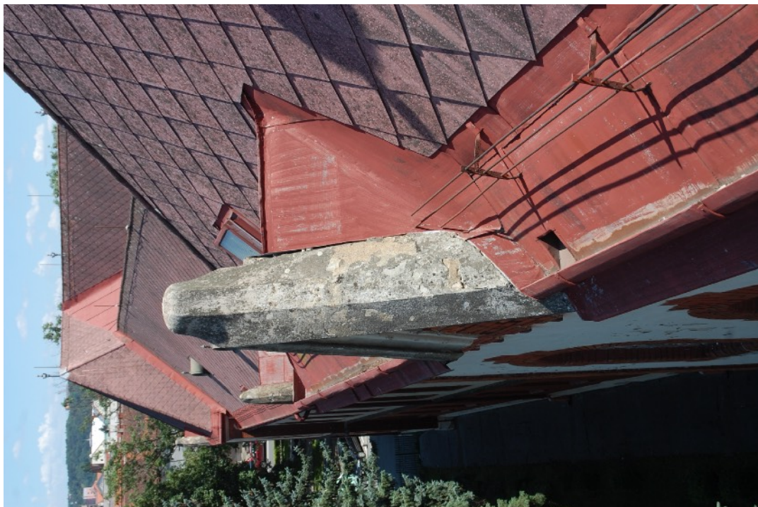
Foto č. 141: Aktuálny stav: detail strechy s atikovým štítom.
