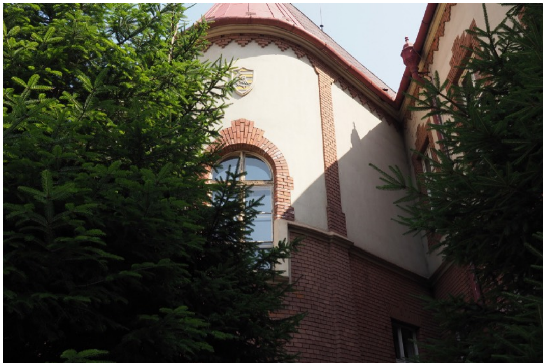
Stav pred reštaurovaním.
