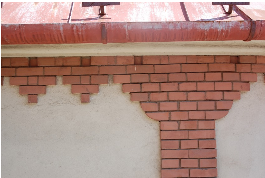
Stav pred reštaurovaním.
