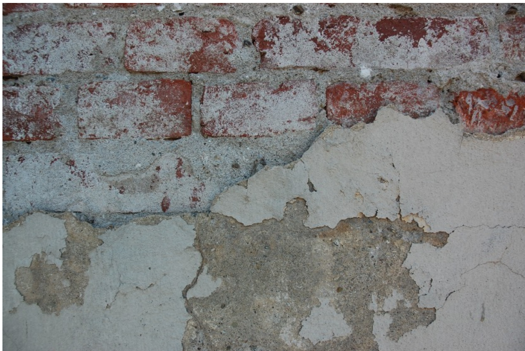
Foto č. 159: Stredový hlavný rizalit S fasády, centrálna časť, 2.NP, detail poškodenia, stratiografia, detail muriva a štruktúry omietkovej a farebných vrstiev.
