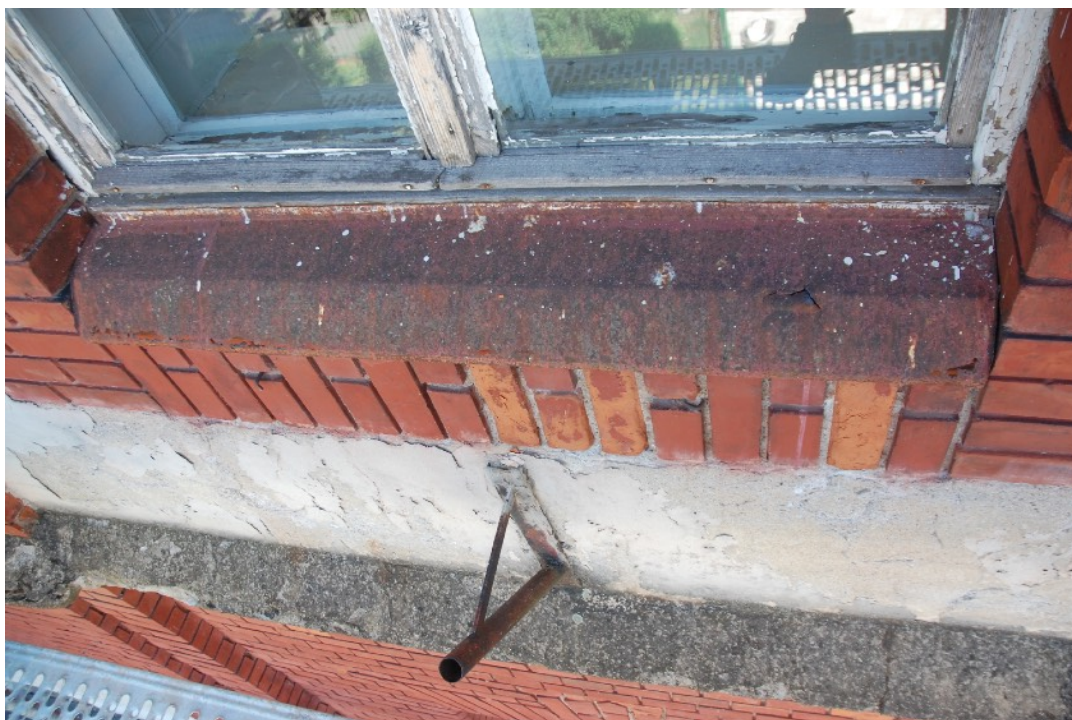
Foto č. 164: Stredový hlavný rizalit S fasády, centrálna časť, 2.NP, detail poškodenia sekundárneho oplechovania parapetu.
