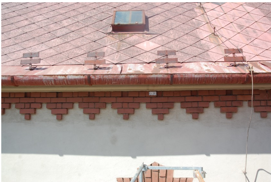
Stav pred reštaurovaním.
