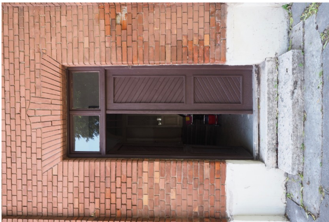
Foto č. 136: Pohľad zo Z, dvorová fasáda, časť tzv "veľký dvor", časť V kridla so stredovým rizalitom, 1. NP, centrálna časť, vstup.
