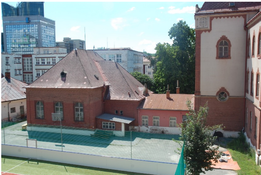
Stav pred reštaurovaním.
