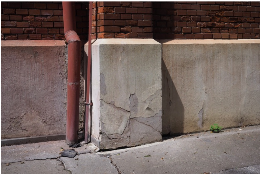
Foto č. 23: Pohľad z V, trojosový stredný rizalit, 1.NP, detail poškodenia.
