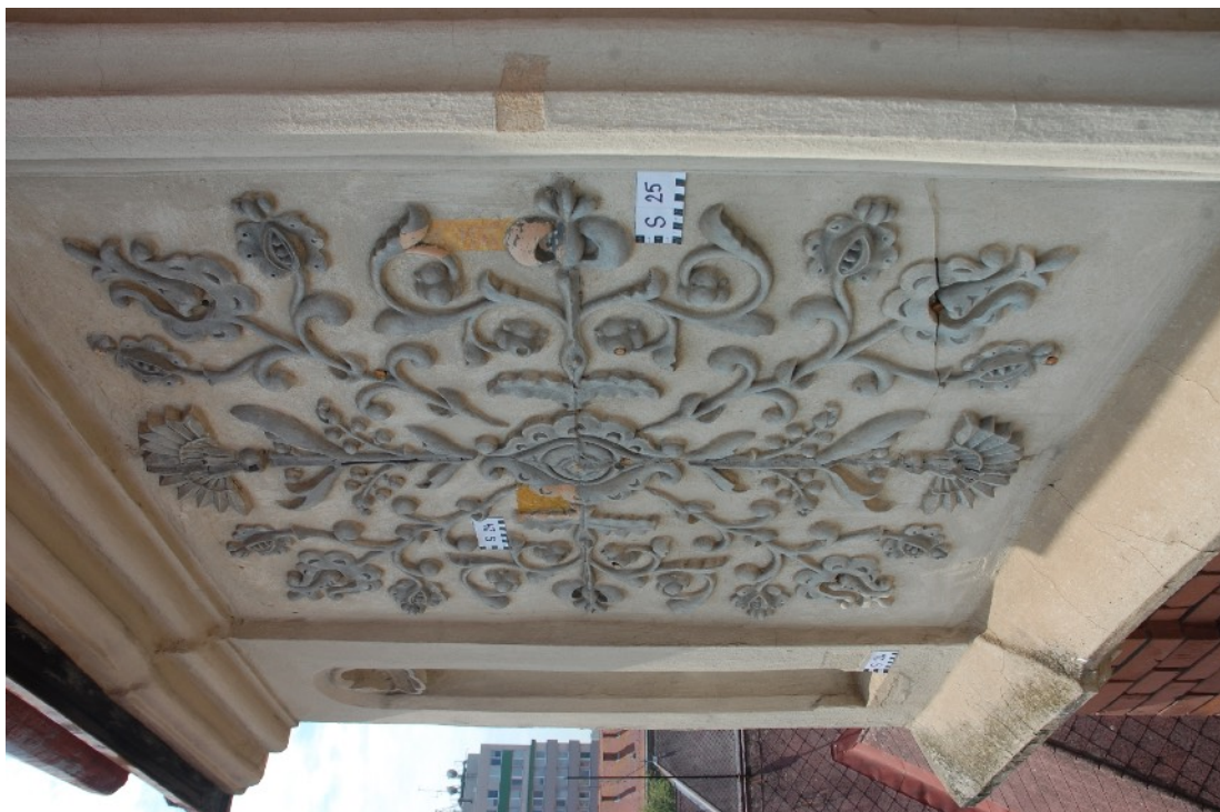
Foto č. 207: Sonda S24 a S25. Keramická kartuš.
