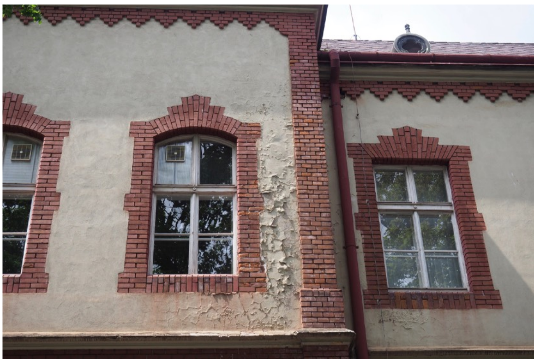
Foto č. 21: Pohľad z V, trojosový stredný rizalit, 2.NP, detail poškodenia.
