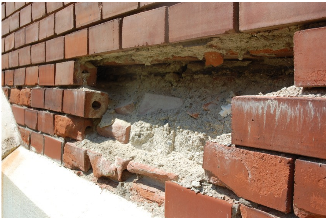
Stav pred reštaurovaním.
