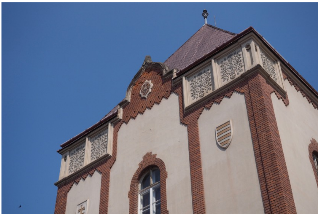
Stav pred reštaurovaním.
