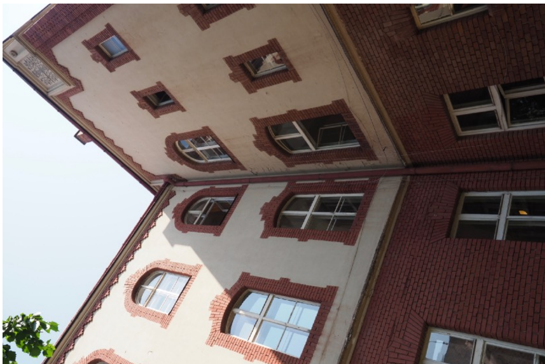
Foto č. 101: Pohľad z J, dvorová fasáda, časť tzv "malý dvor", časť S kridla s hlavným stredovým rizalitom, 2.NP.
