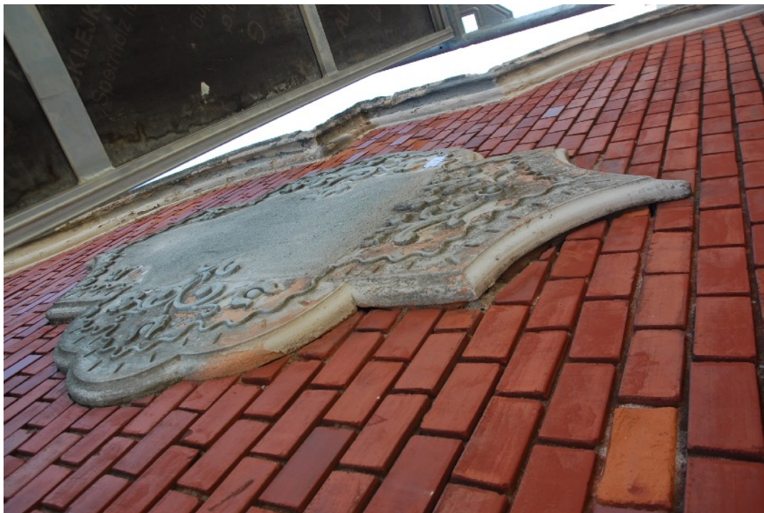
Foto č. 145: Keramická kartuš / terč a lícovátchla atiky, aktuálny stav, detail.
