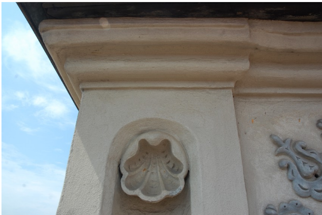
Stav pred reštaurovaním.
