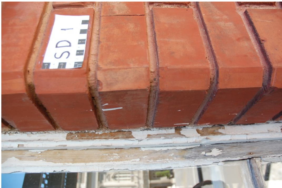
Foto č. 161: Sonda SD1. Primárna farebnosť hnedočervení tón a detail skladby lícovej tehly na šambráne okenného otvoru.
