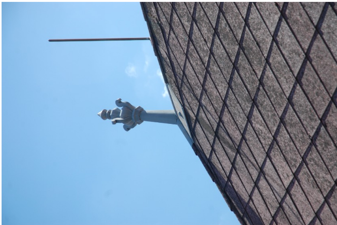
Foto č. 139: Detail zdobného pilónu koruny strechy, prevdopodobne tepaný prvok zo zinkového? plechu, strešná krytina je eternit.
