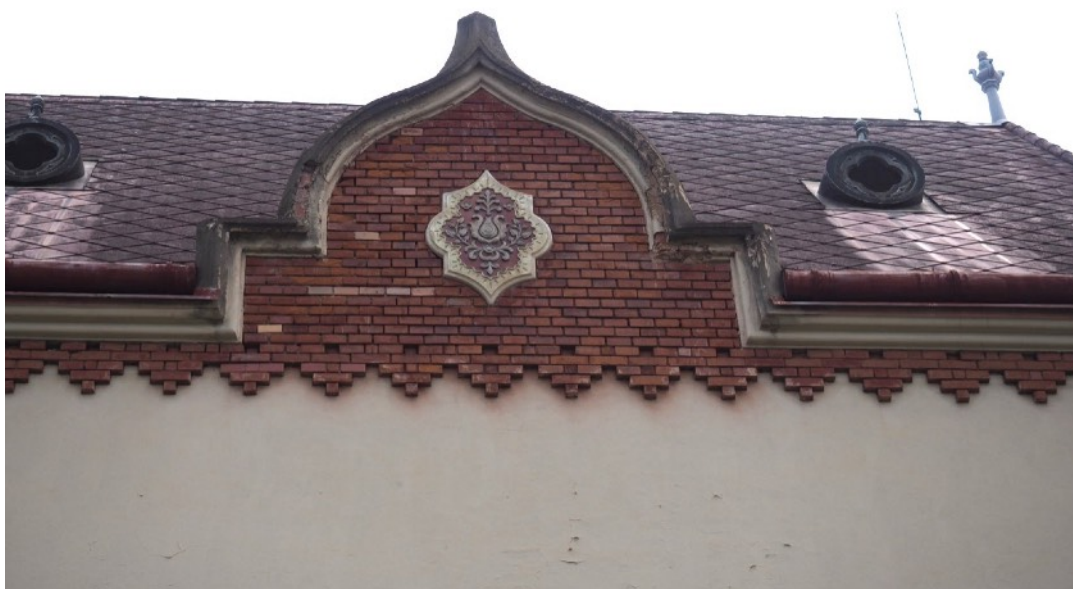
Stav pred reštaurovaním.
