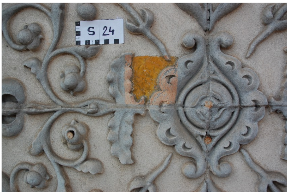
Foto č. 202: Sonda S24. Keramická kartuš.
