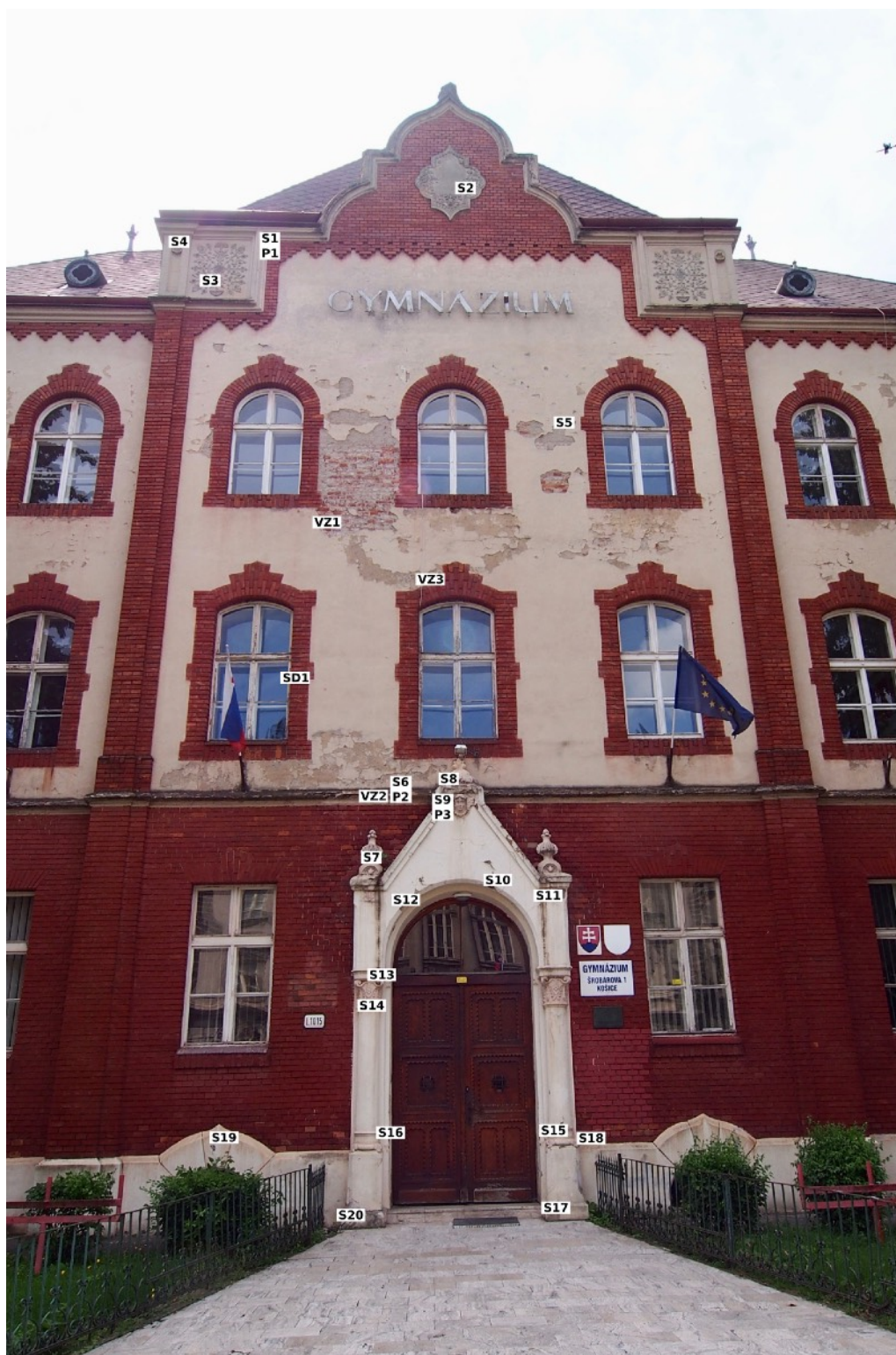
Príloha č. 1: Lokalizácia sond (S) / Miesta odobratia vzoriek (VZ) / Miesta odobratia profilov (P) - hlavná čelná severná uličná fasáda. Legenda: S - sonda, VZ - vzorka, P - profilácia.
