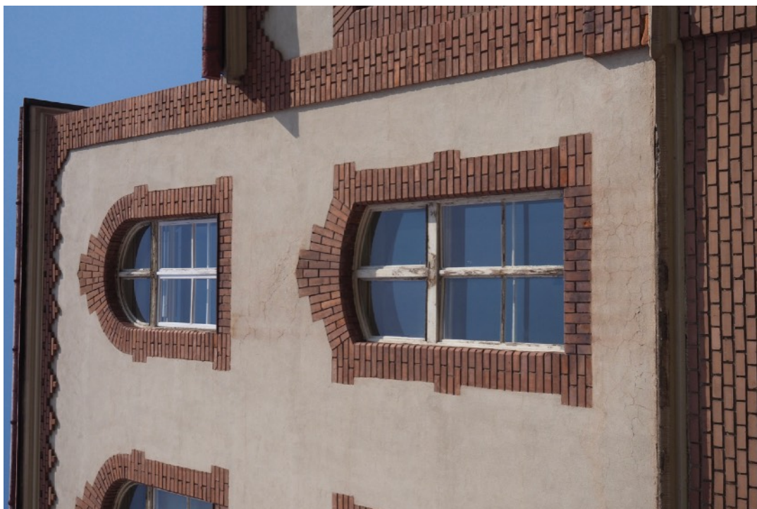
Foto č. 116: Pohľad z J, dvorová fasáda, časť tzv "veľký dvor", časť S kridla s hlavným stredovým rizalitom, 2. a 3.NP, okenný otvor.
