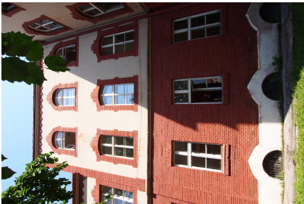
Foto č. 98: Pohľad z J, dvorová fasáda, časť tzv "malý dvor", časť S kridla s hlavným stredovým rizalitom.
