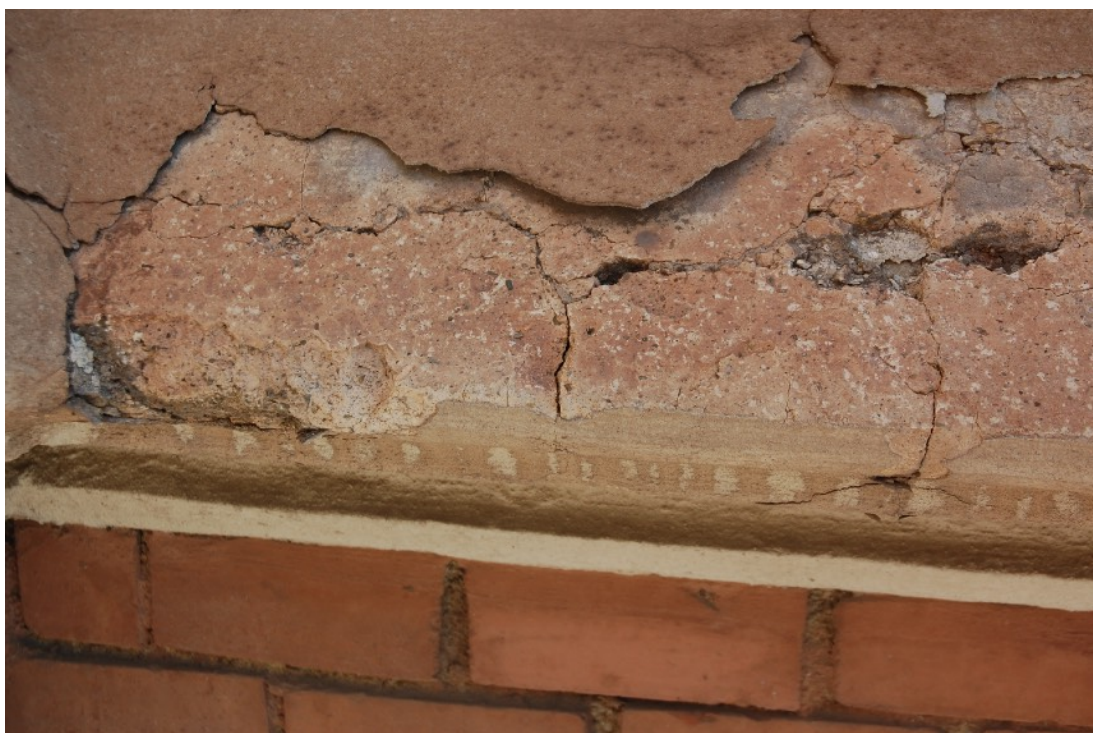
Foto č. 200: Pohľad zo Z, dvorová fasáda, časť tzv "veľký dvor", časť S krídla s rotundou, medzipodlažná rímsa / kordon, detail poškodenia.
