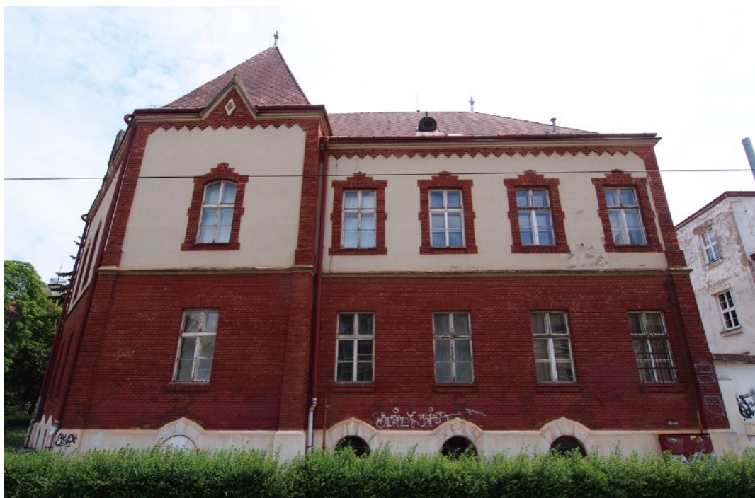
Stav pred reštaurovaním.
