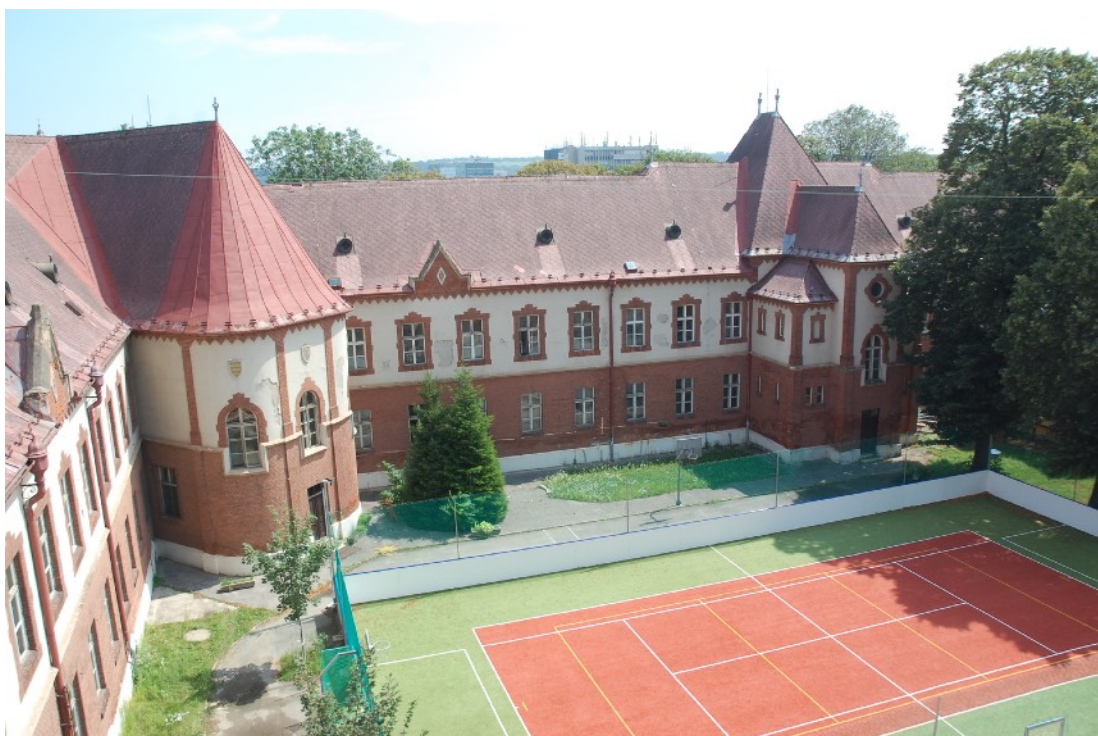
Stav pred reštaurovaním.
