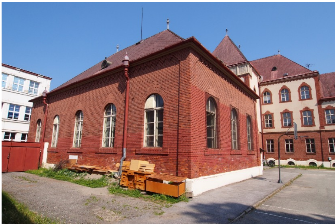
Stav pred reštaurovaním.
