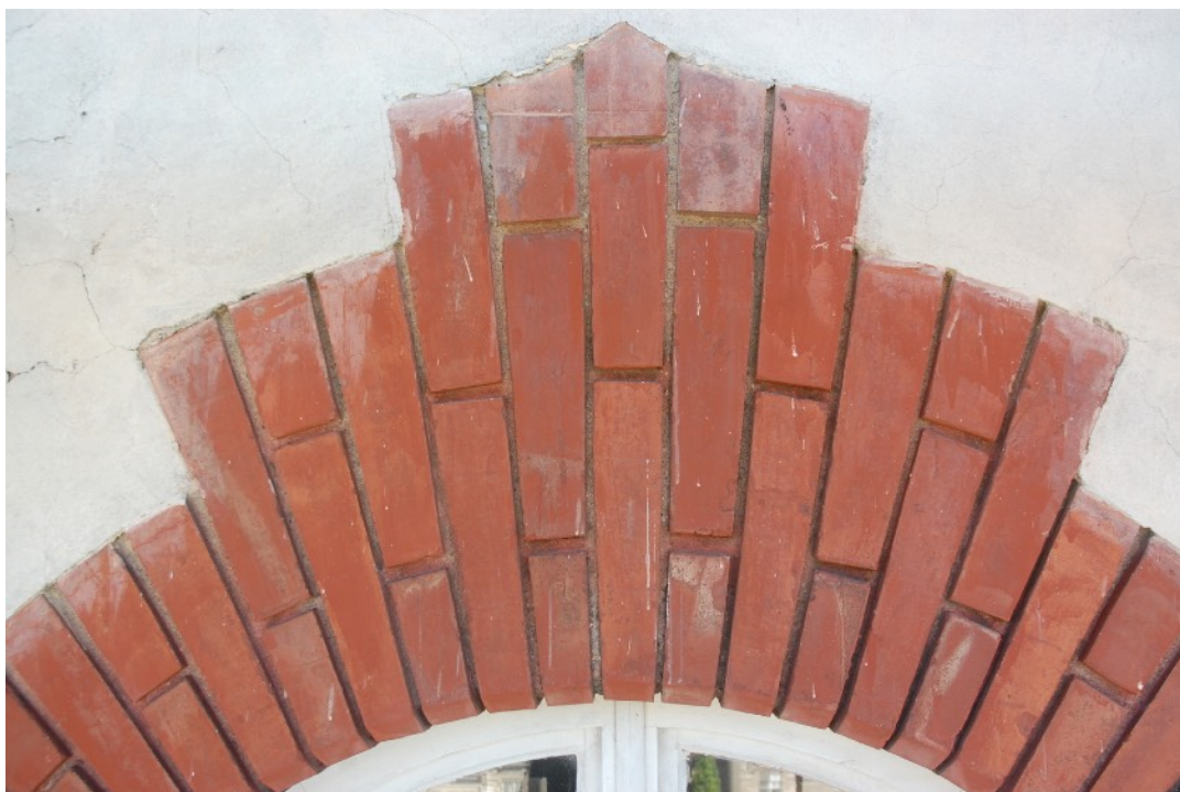
Foto č. 156: Nadokenná skladbe lícovej tehly, aktuálny stav, detail.
