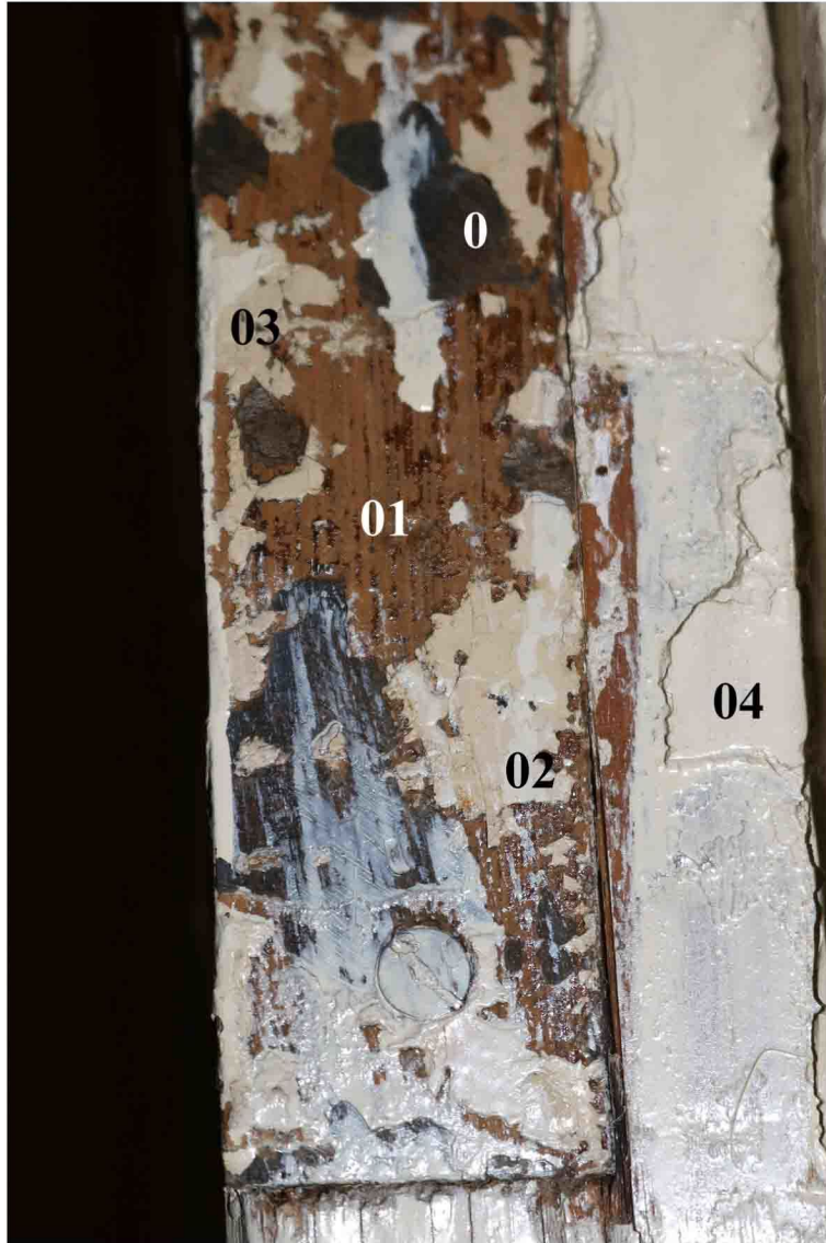
Sonda na medzichodbových dverách pri hlavnom schodisku, interiér, 2NP (chodba)
