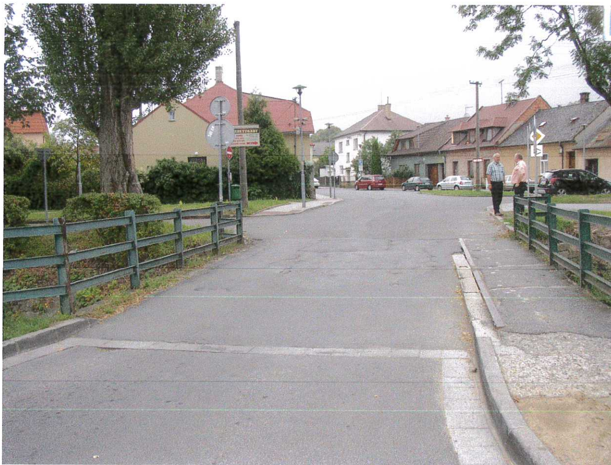
POHLED NA MOST
