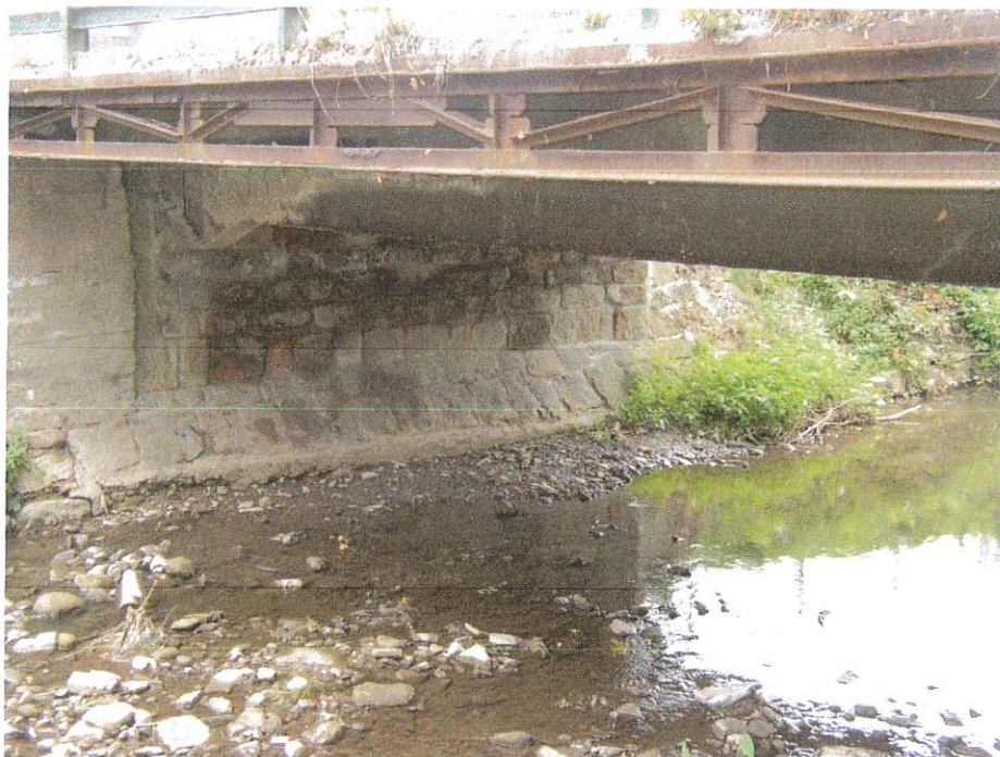
POHLED NA MOSTNÍ OPĚRU
