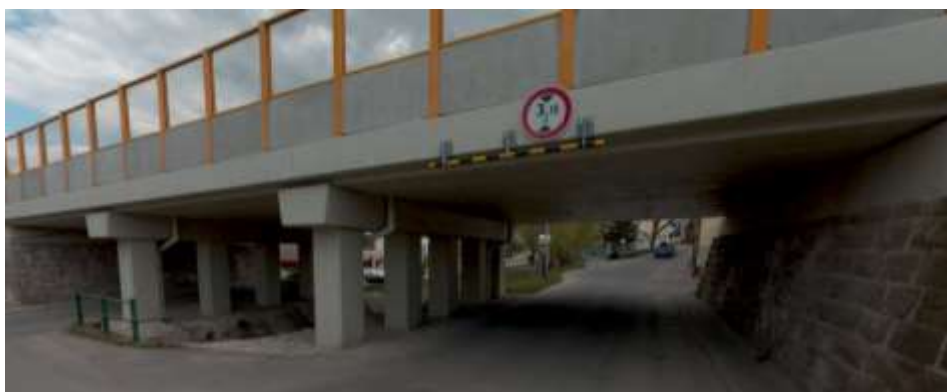
Obrázok č.1 - Podjazd na Opatovej
