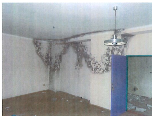
dôsledok poškodenej krytiny
