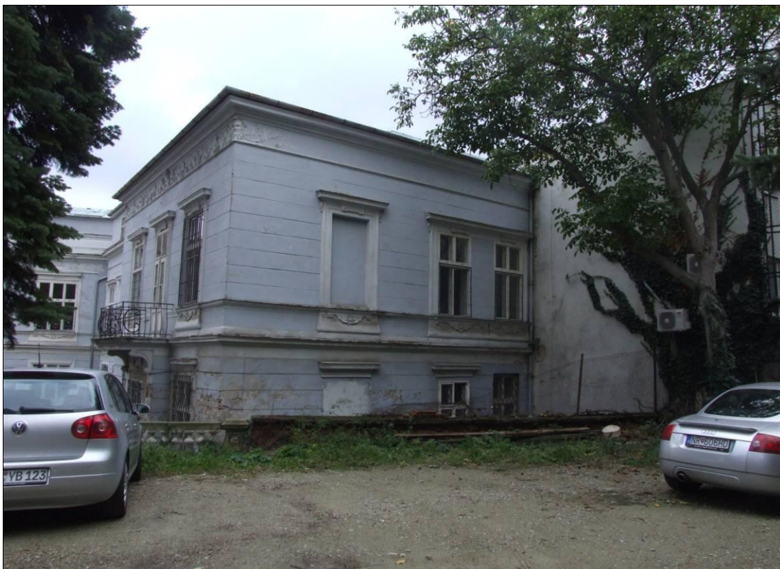
západné krídlo, severná fasáda
