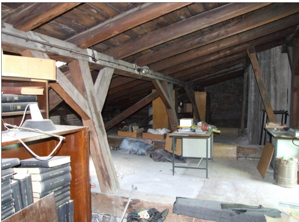
južné krídlo, krov nad severnou časťou
