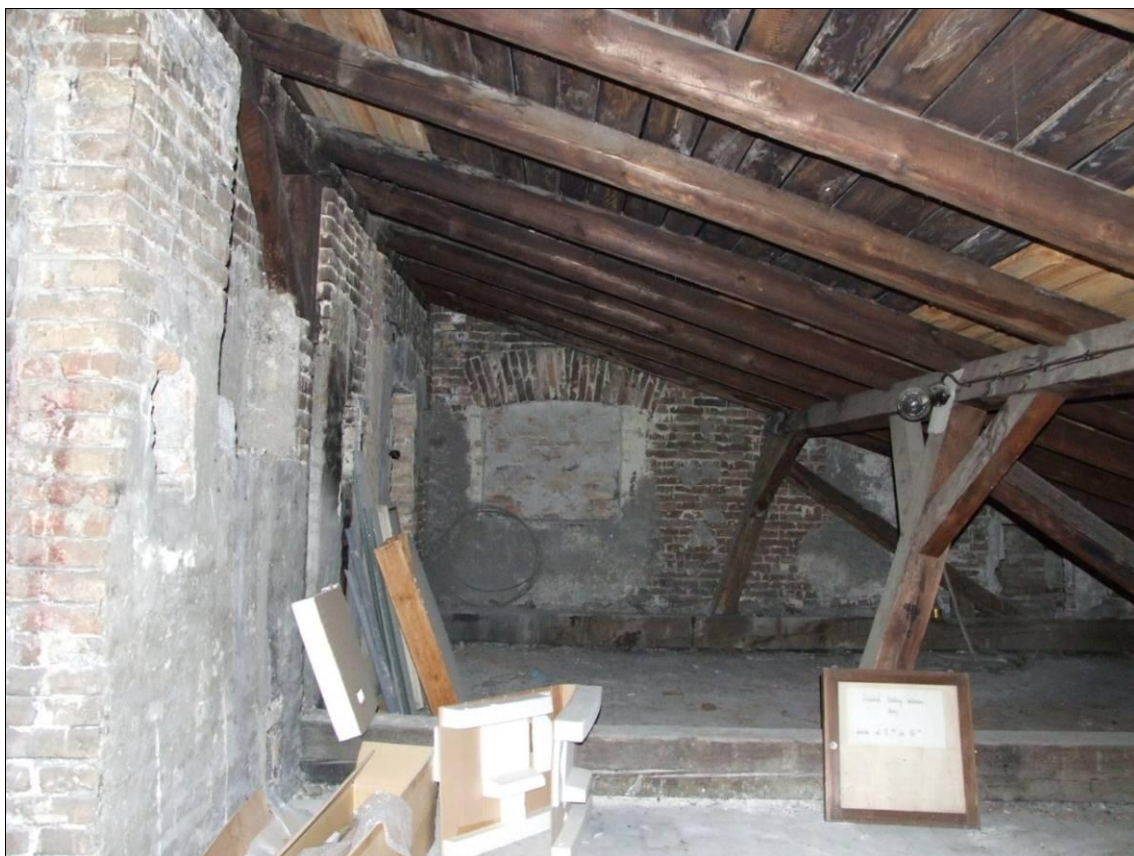
južné krídlo, krov nad severnou časťou
