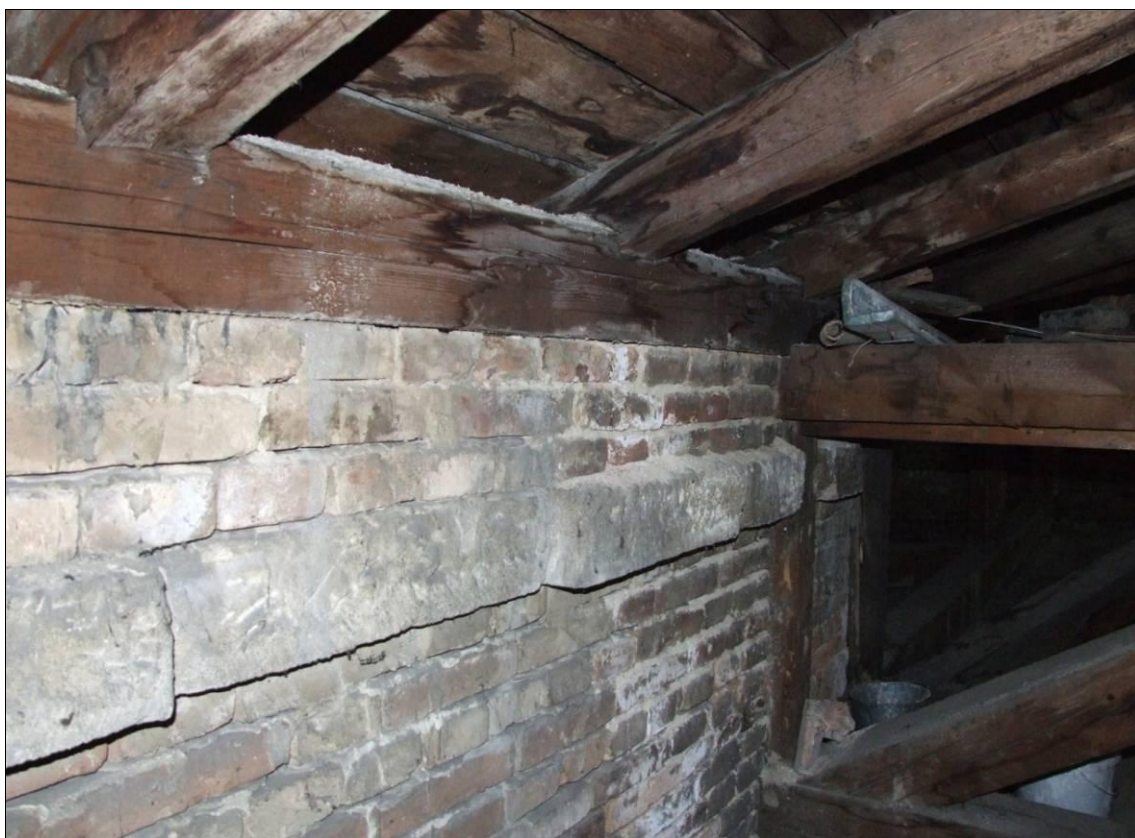
južné krídlo, krov nad južnou časťou, kamenné konzoly korunnej rímasy
