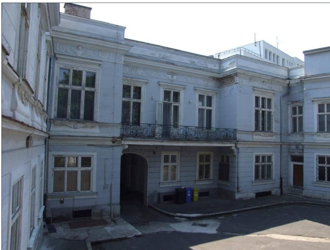
južné krídlo, severná dvorová fasáda
