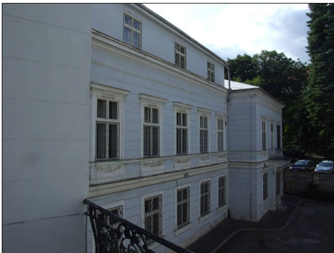
západné krídlo, dvorová fasáda, pohľad z juhu
