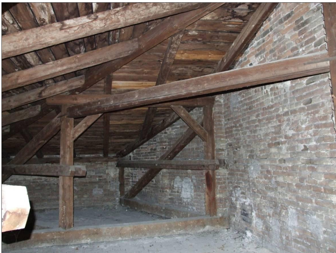
južné krídlo, krov nad južnou časťou
