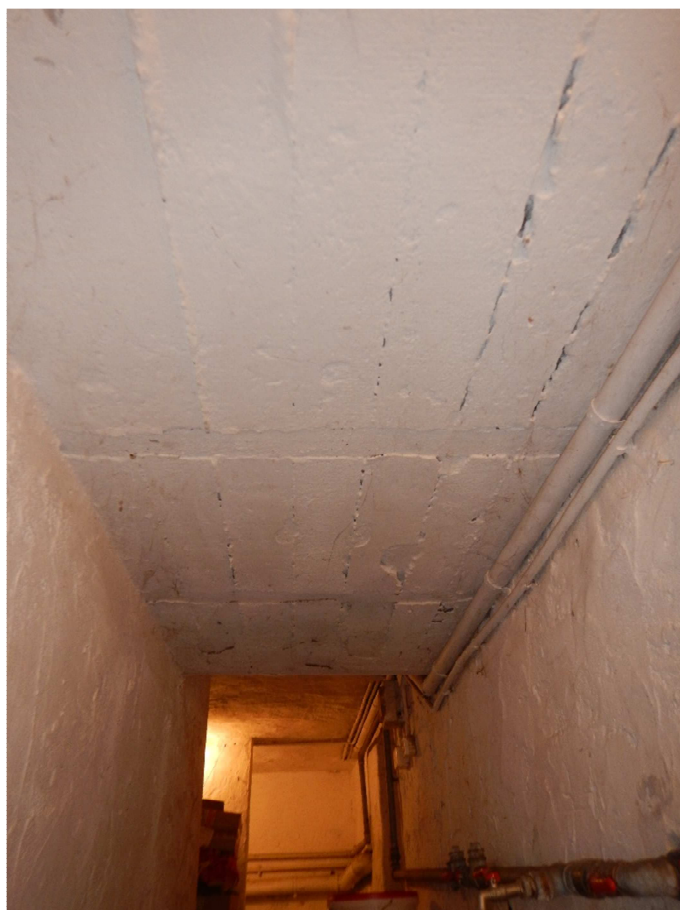
Fot. 13 Strop Kleina nad piwnicą
