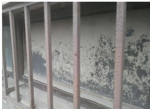
Obr. 6 Pôvodné okenné konštrukcie (Zdroj: autori)
