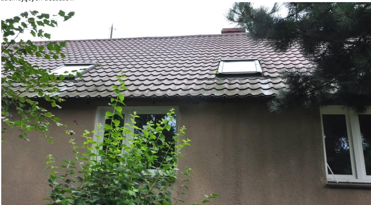
Fot. 6. Widok na budynek od strony południowej. Mały okap dachu powoduje zamakanie elewacji podczas zacinających deszczów
