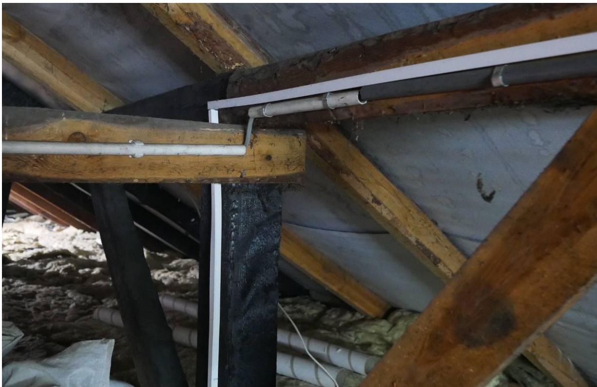
Fot. 3. Fragment konstrukcji więźby - uszkodzenia przez działanie ognia, lokalnie występuje kora na elementach krokwi
