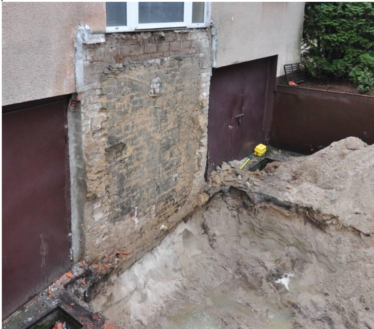
Fot. 14. Ściana szczytowa od strony zachodniej (zdjęcie archiwalne) - widoczny materiał oraz odsłonięty fundament
