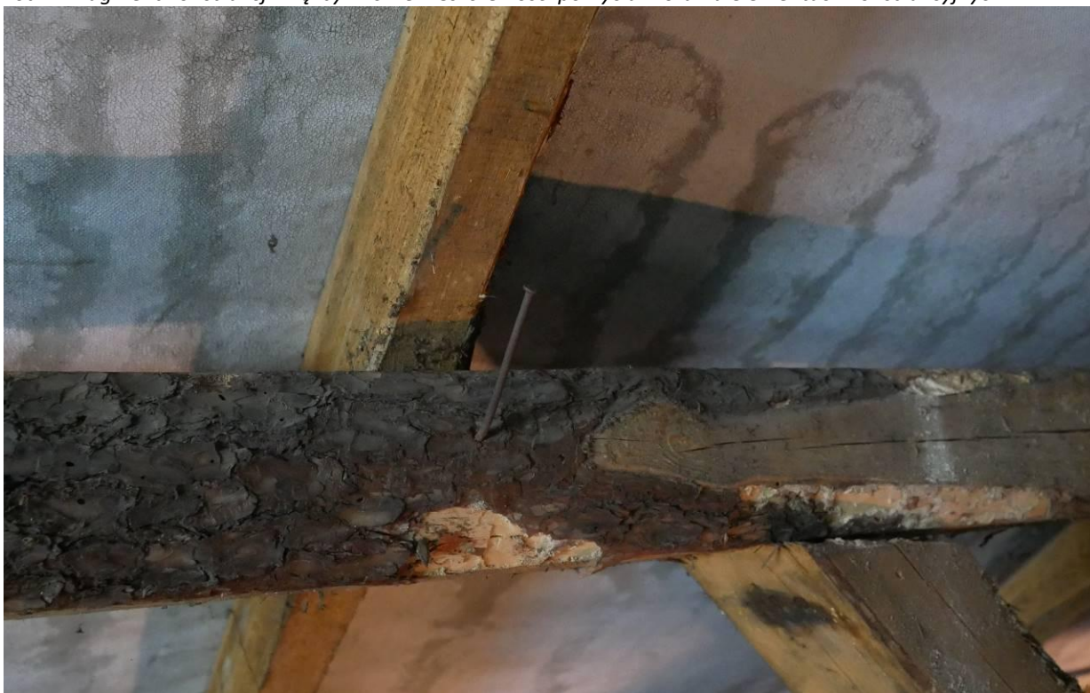
Fot. 4. Fragment konstrukcji więźby - liczne nieszczelności pokrycia. Kora na elementach konstrukcyjnych
