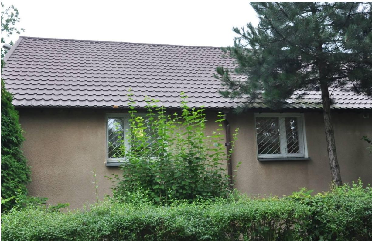
Fot. 6. Widok na budynek od strony południowej. Mały okap dachu powoduje zamakanie elewacji podczas zacinających deszczów
