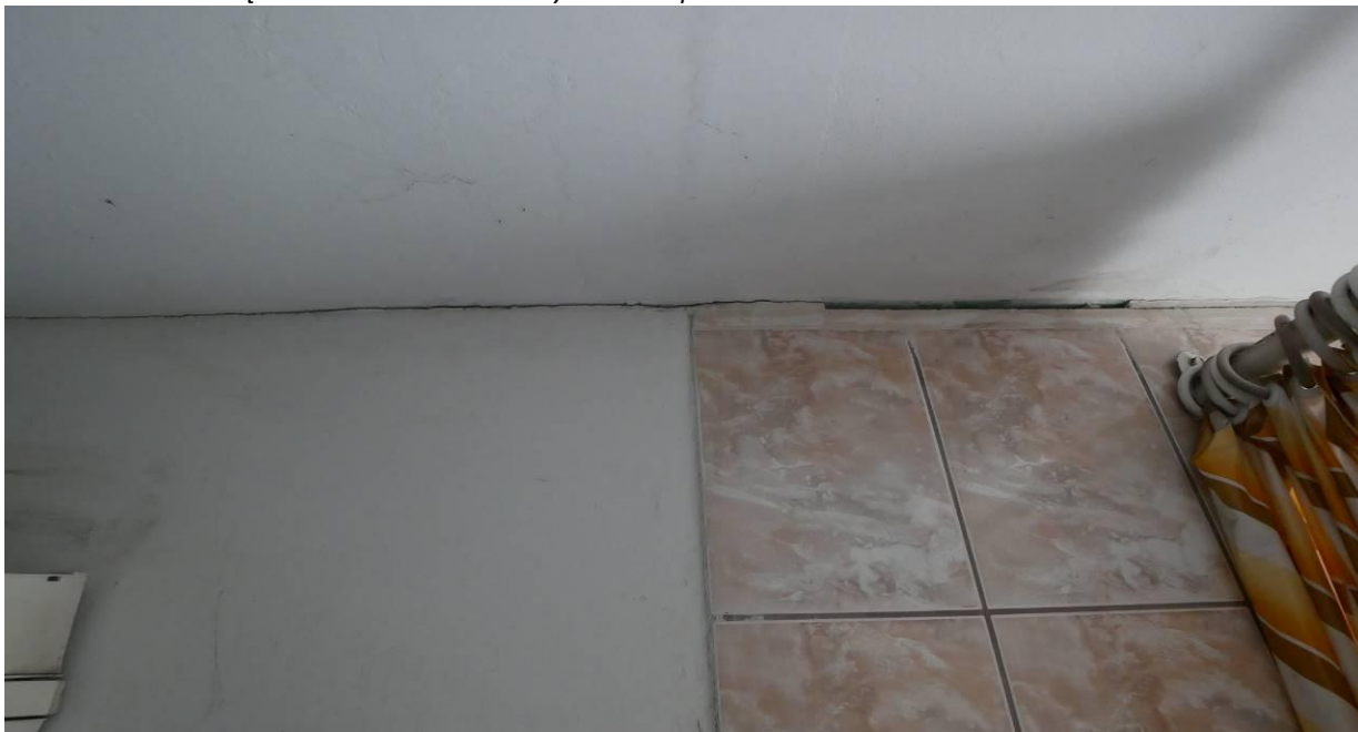
Fot. 9. Ściana wewnętrzna - uszkodzenia na styku ze stropem
