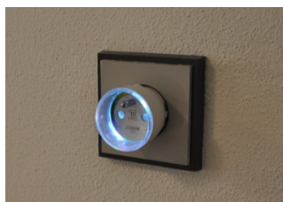
Obrázok 17 Inteligentná elektrická zásuvka
