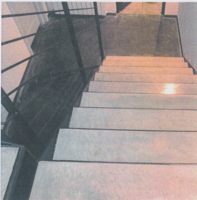
SCHODY WYKONANE Z MIKROCEMENTU
