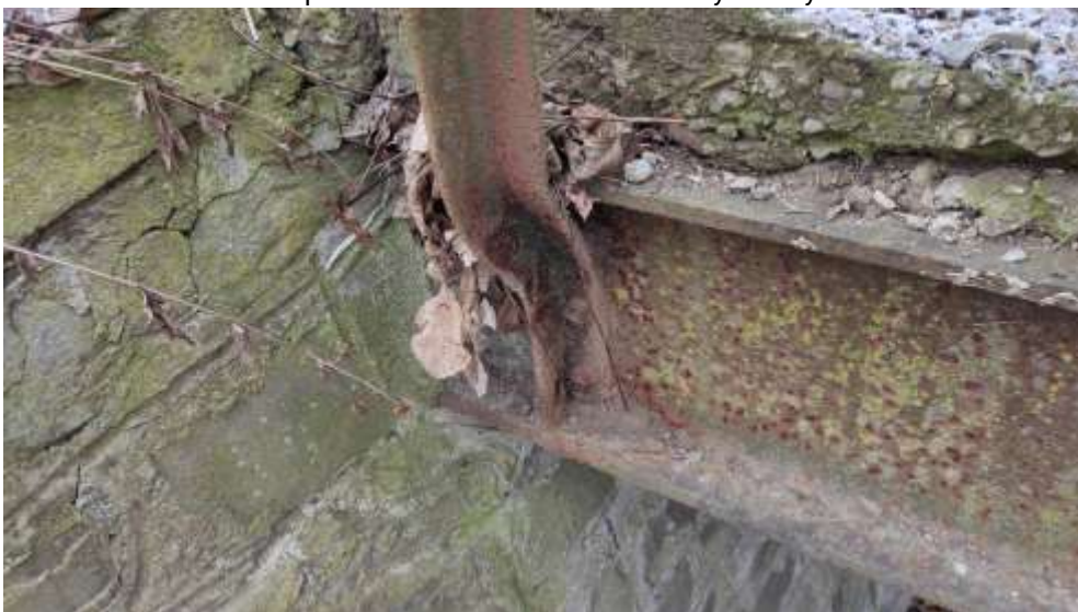
Obr.č.6: Nosník NK – koroze nosníků.
