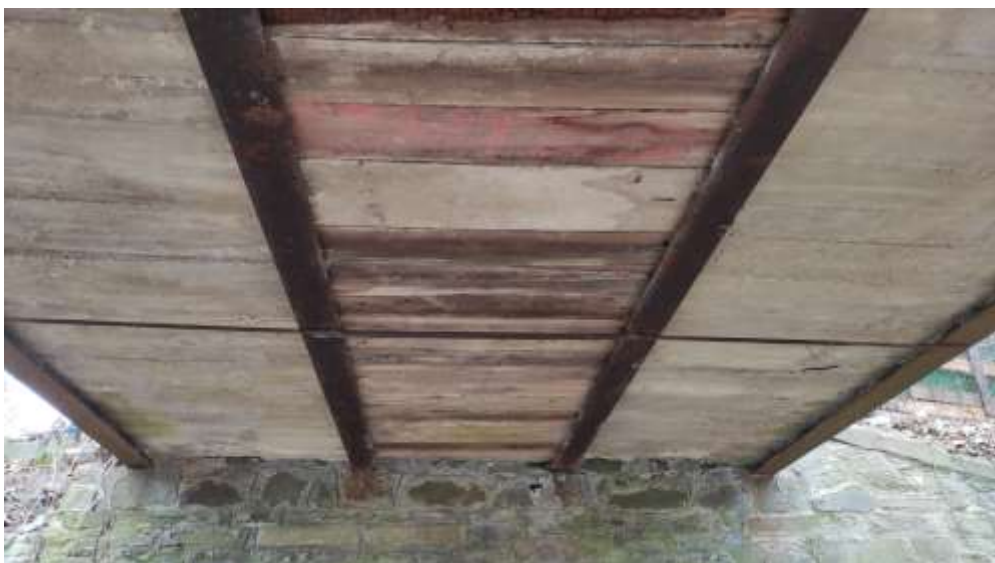
Obr.č.7: Podhled NK – neodstraněné desky podbednění NK, vydrolené spáry.
