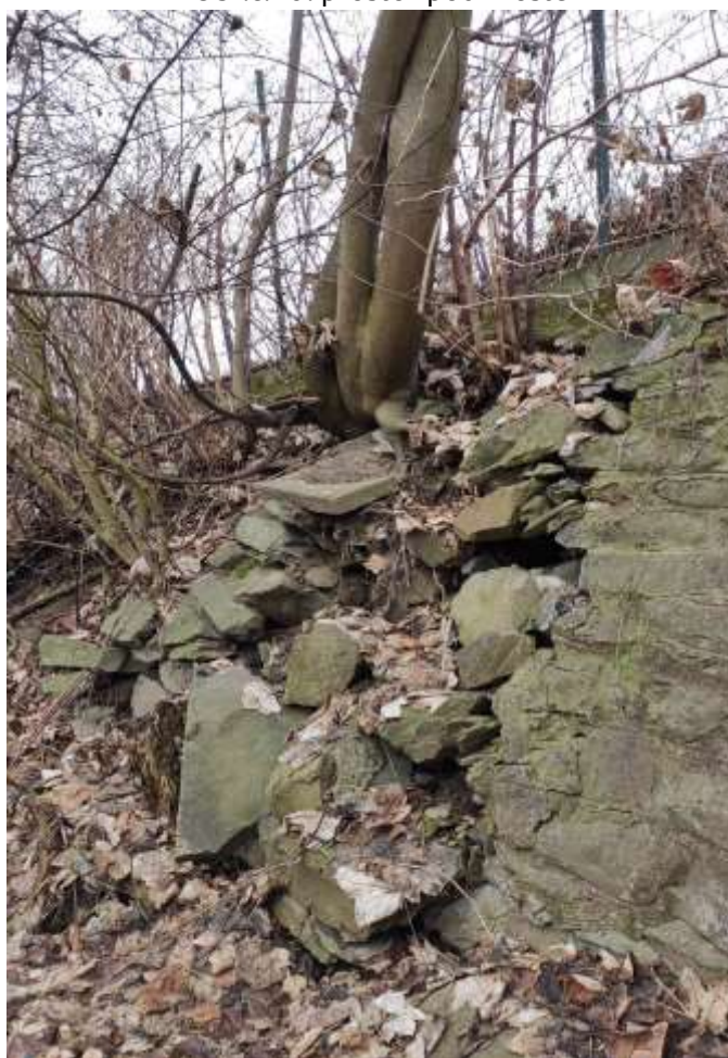
Obr.č.11: Rozpad opěrné zídky
