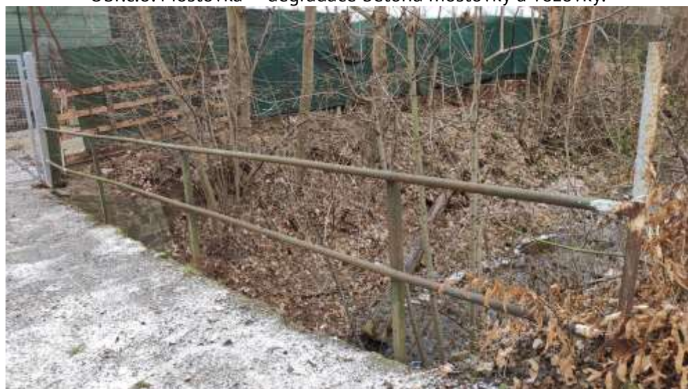
Obr.č.9: zábradlí – koroze zábradlí.
