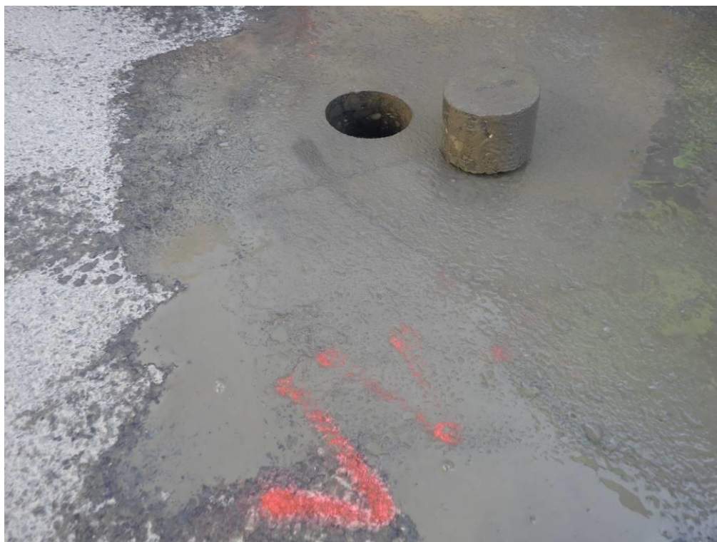
Detail místa vývrtu JV 4
