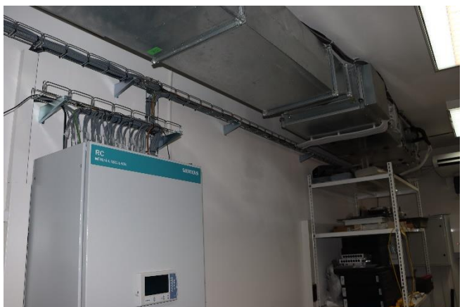
Pohled na kabeláž vedenou v chráničkách a na řešení odvodu kondenzátu včetně sifonu.
