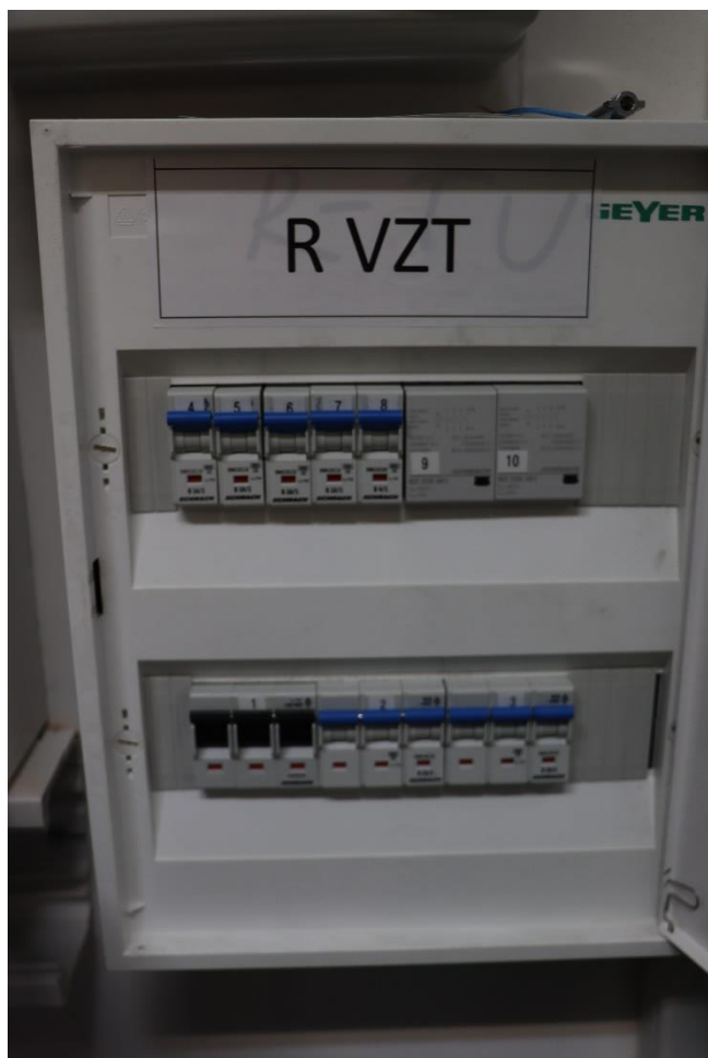
Pohled na rozvaděč s jističi pro VZT umístěný vedle rozvaděče MaR.
