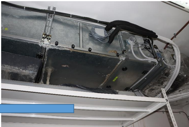
Stávající VZT jednotka C.I.C. Hřebec pod stropem serverovny a směr proudění vzduchu.
