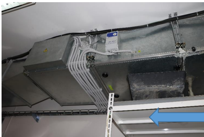
Stávající VZT jednotka C.I.C. Hřebec pod stropem serverovny a směr proudění vzduchu.
