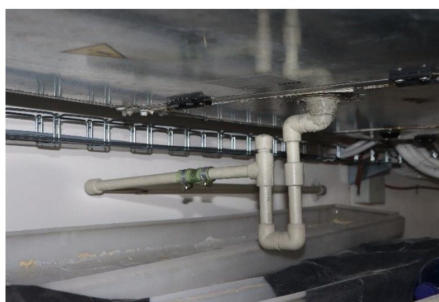
Pohled na kabeláž vedenou v chráničkách a na řešení odvodu kondenzátu včetně sifonu.
