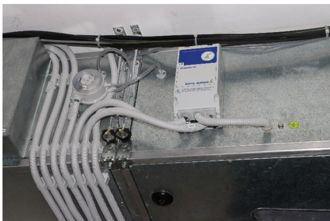
Pohled na kabeláž vedenou v chráničkách a na řešení odvodu kondenzátu včetně sifonu.
