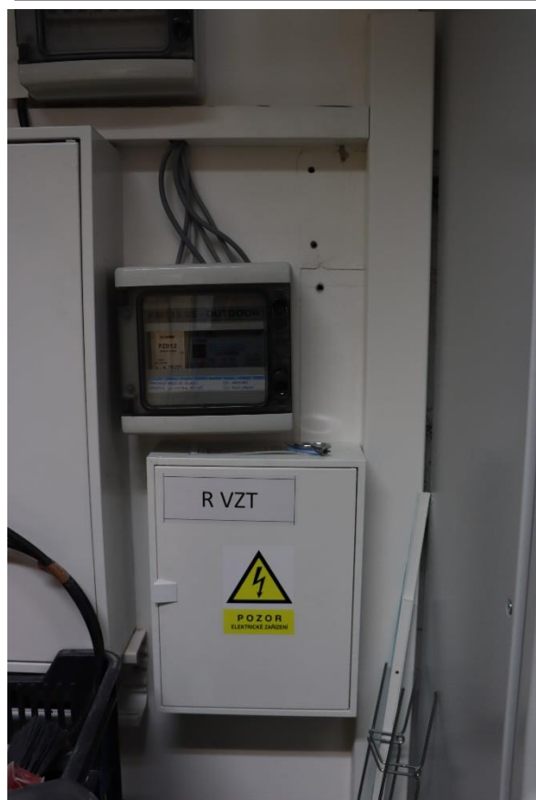
Pohled na rozvaděč VZT a na modul KM113.05-OUTDOOR pro řízení kondenzační jednotky LG.
